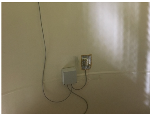
Fig. 6.2- Extensómetro do parque eólico da tocha, situado a 6 metros e meio da base da turbina.
