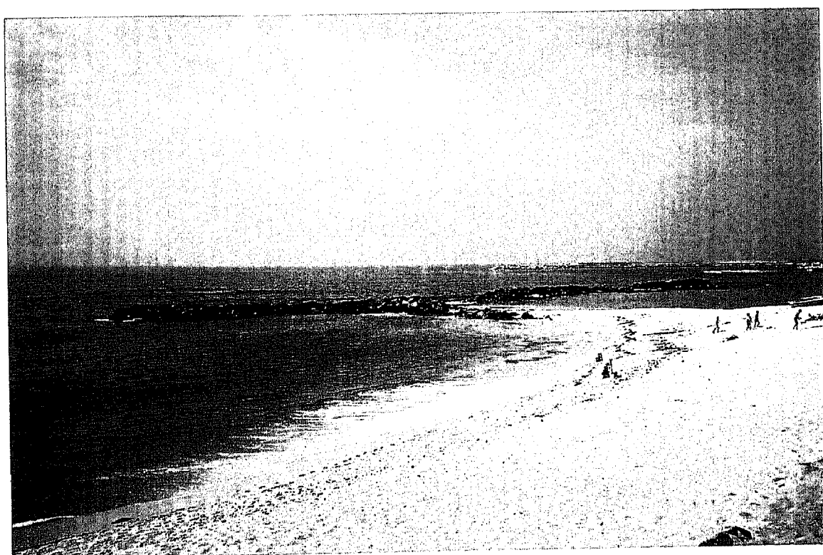
Figura D - Quebra-mar longitudinal destacado e respectivo tómbolo de areias, induzido pelo fenómeno de dupla difracção das ondas. Praia de Caxinas, Vila do Conde.
