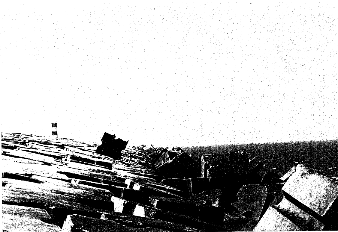
Figura B - Porto de Sines. Tetrápode de 90 tf projectado pelo mar.
