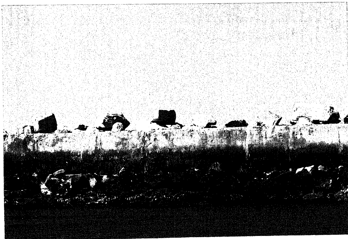
Figura E - Quebra-mar destacado de Castelo de Neiva ainda com a cota de coroamento de +4 m (Z.H.). A colonização biológica está já bem desenvolvida mas não ultrapassa a cota de +3 m (Z.H.). Agosto de 2000.
