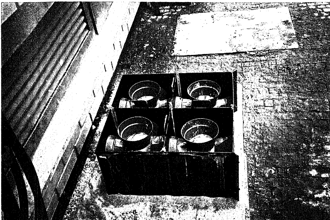
Figura 39 - Aspecto da cofragem completa, pronta a ser betonada.
