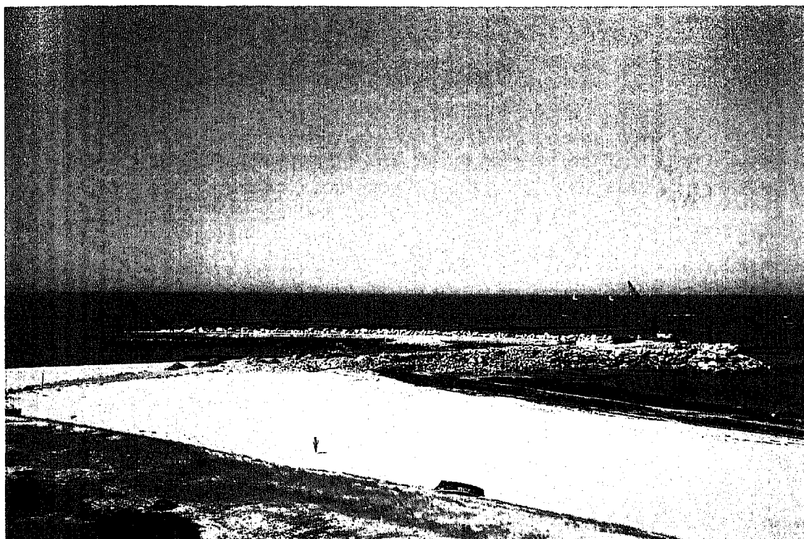
Figura F - Quebra-mar de Castelo de Neiva. Acumulação de areias a norte (barlamar) do acesso ao quebra-mar, atingindo praticamente a cota deste. Agosto de 2000.
