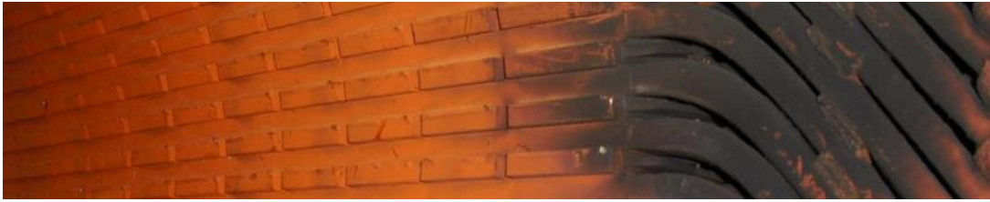
Figura 4.7 - Falha na isolação dos enrolamentos de uma máquina elétrica rotativa [33]
