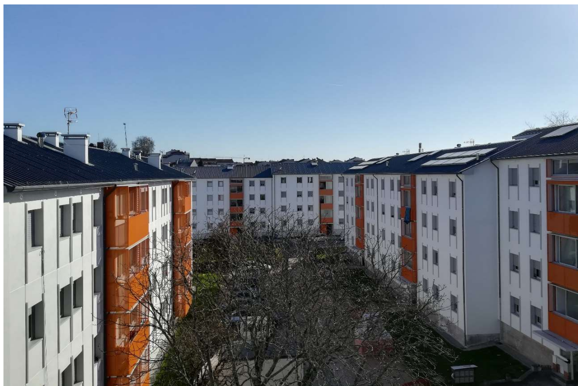
Figura 3.4 Fotografia da obra caso de estudo
