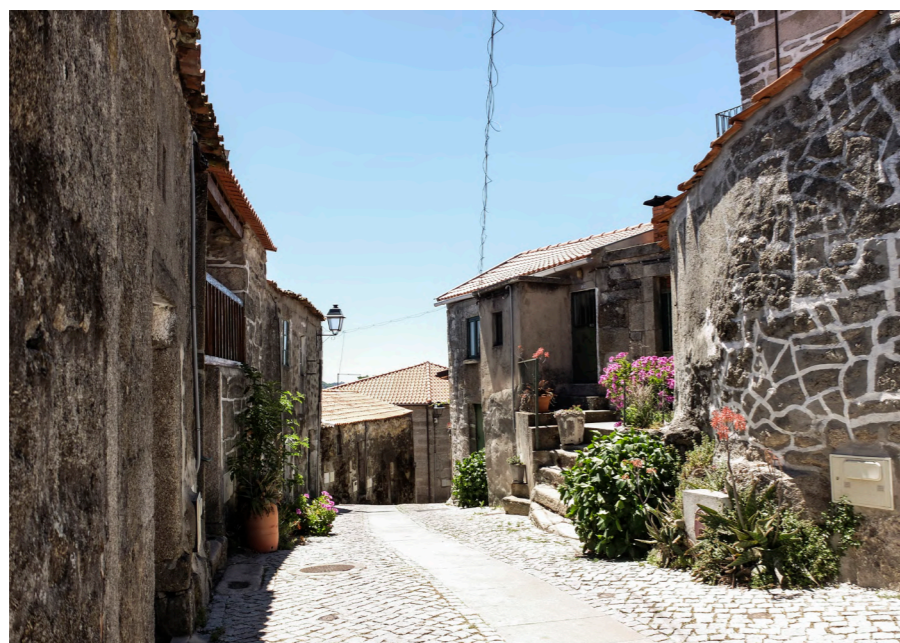
Fig.46 | Urbanização na Rua Engenheiro Amaro da Costa (Maio de 2019).
