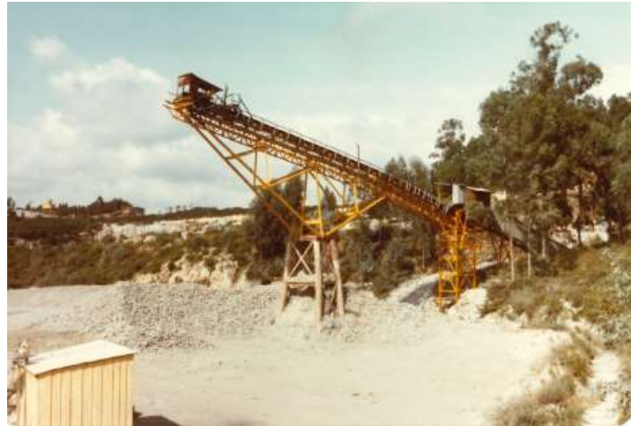
Fotografia 35 – Estrutura da tela transportadora de alimentação do Pré-Stock. (Fotografia do Autor)
