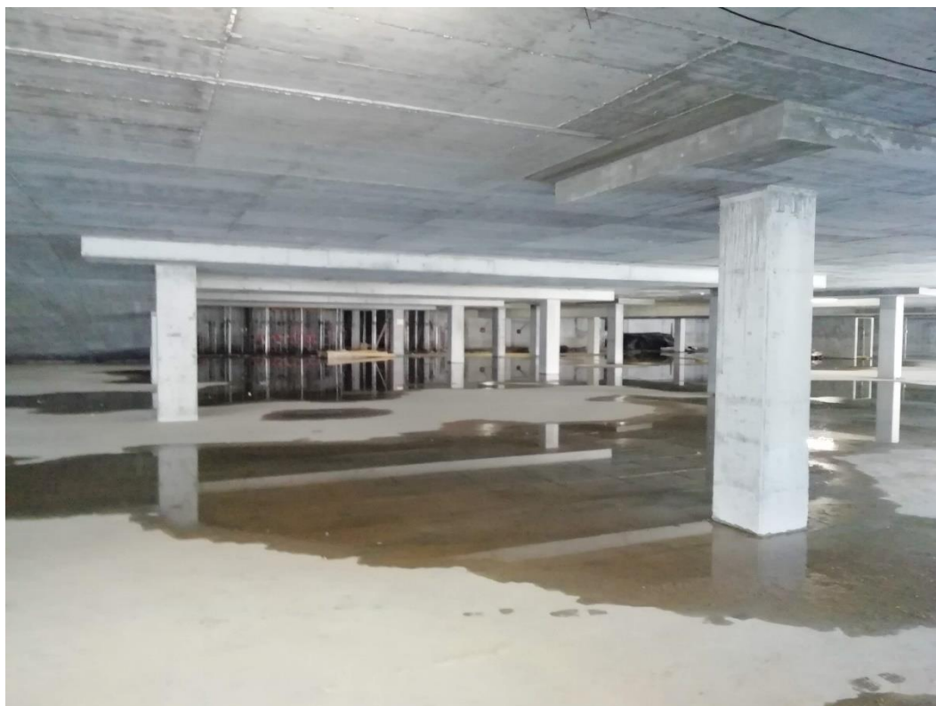
Fig. 3.7 – Zona de construção nova abaixo de MC
