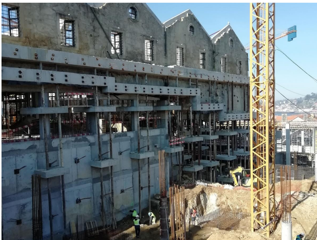
Fig. 3.5 – Abaixamento de cotas na zona do AS e exemplo das ancoragens
