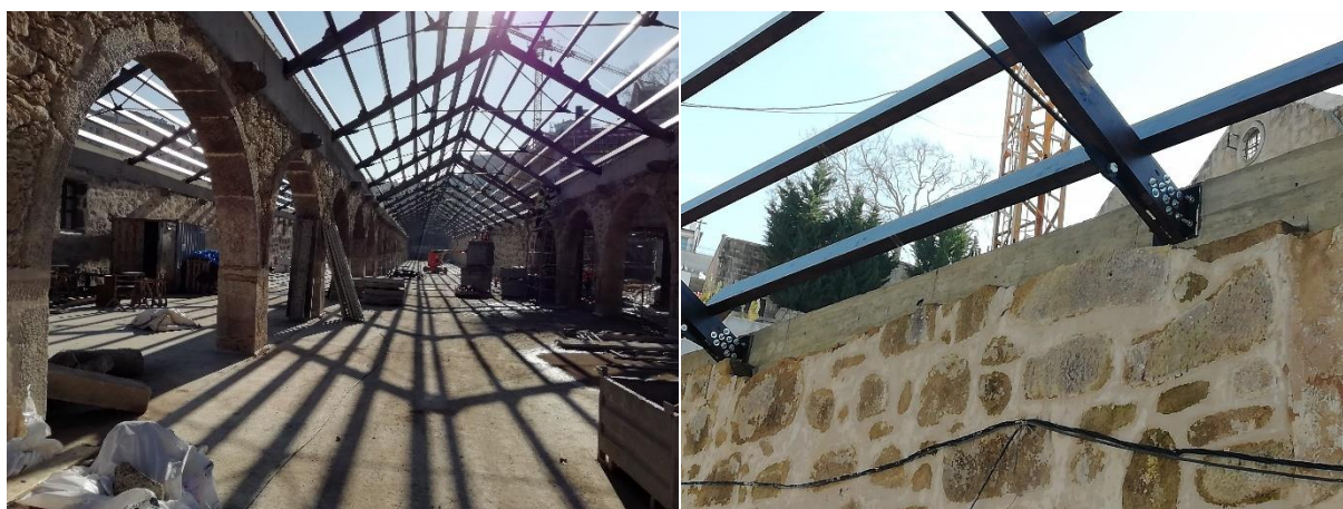
Fig. 3.6 – Ligação da estrutura metálica nova da cobertura às paredes reabilitadas do AN
