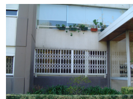
Figura 8.3_ Protecção ao nível do r/c
