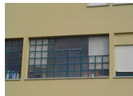
Figura 8.15_ Vão em ferro
