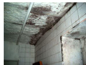
Figura 3.3_ Condensações. Hospital da Lapa. 2002.
