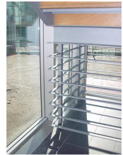
Figura 8.10_ Caixa de escadas metálica
