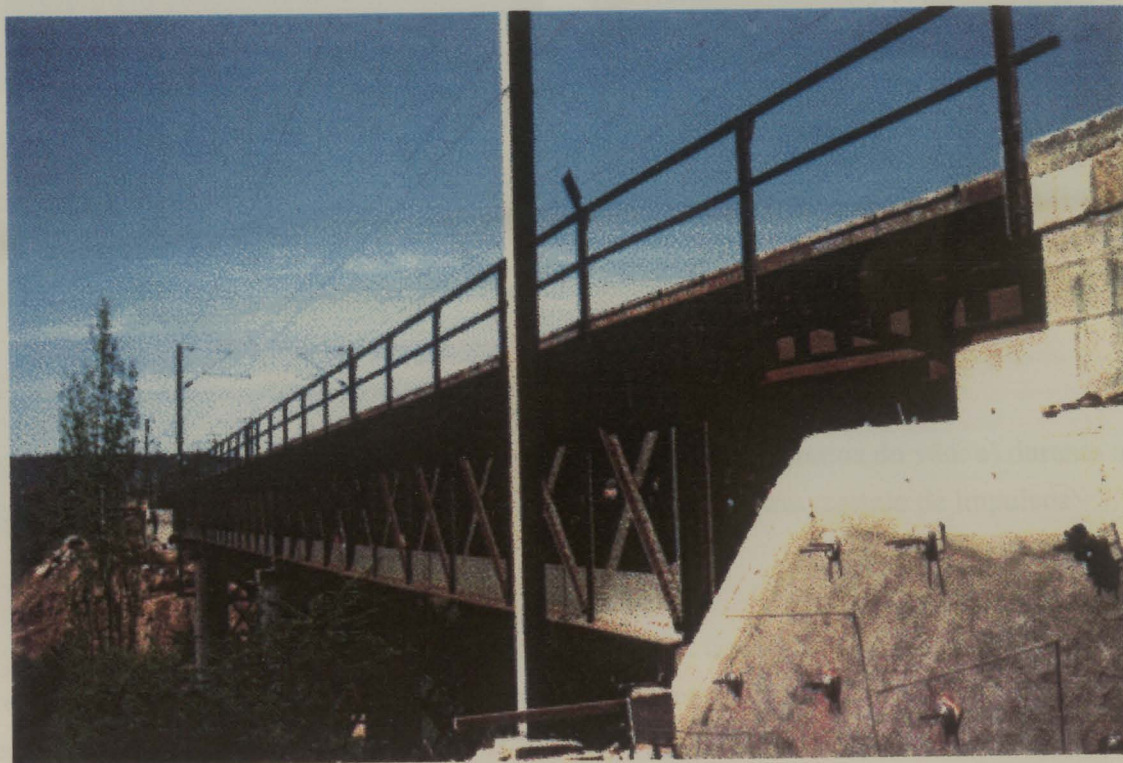
Figura 6.2 - Vista da Ponte de Seixa situada ao km 0+132.081 da Linha do Norte
