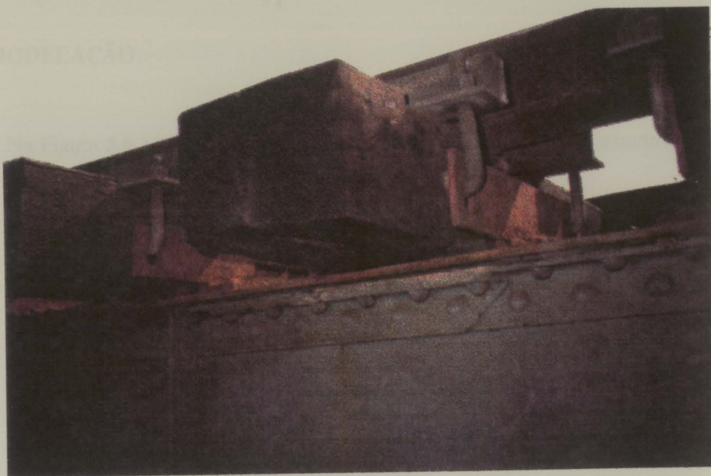
Figura 5.4 - Pormenor da colocação das travessas sobre as vigas do pontão
