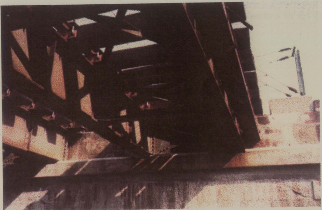
Figura 5.3 - Vista inferior do pontão de Riada
