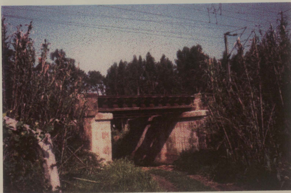
Figura 5.1 - Vista Lateral do Pontão de Riada
