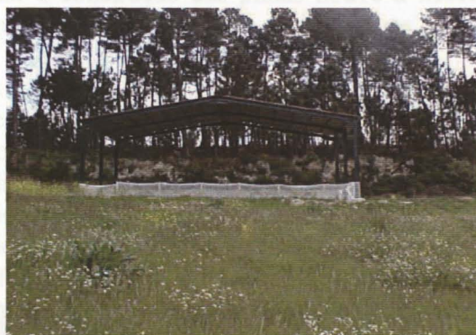
Figura 3.1: Centro de Compostagem.
