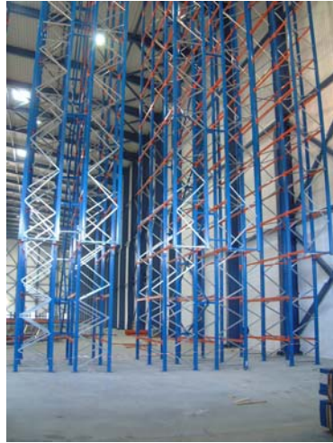
Figura 5.52 – Estantes apoiadas na laje do armazém
