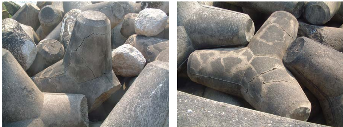
Figura 5.4 – Roturas ocorridas em situações de serviço
