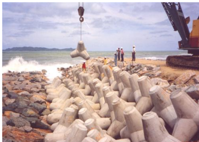
Figura 5.1 – Construção de um quebra-mar – colocação de tetrápodes
