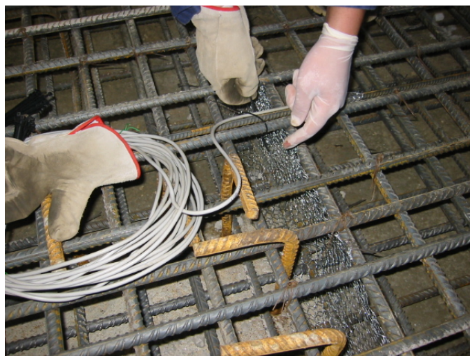
Figura 5.58 – Colocação de um termómetro sobre a malha superior de armaduras da laje
