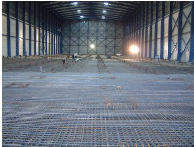
Figura 5.53 – Aspecto global do armazém anteriormente às betonagens
