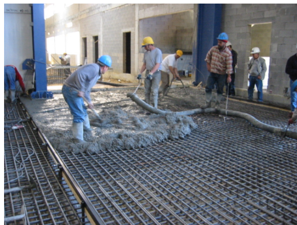
Figura 5.55 – Aspecto da betonagem da primeira faixa transversal (21/03/2003)
