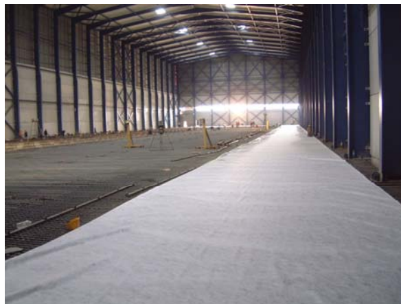
Figura 5.56 – Aspecto do armazém após betonagem da primeira faixa longitudinal (26/03/2003)
