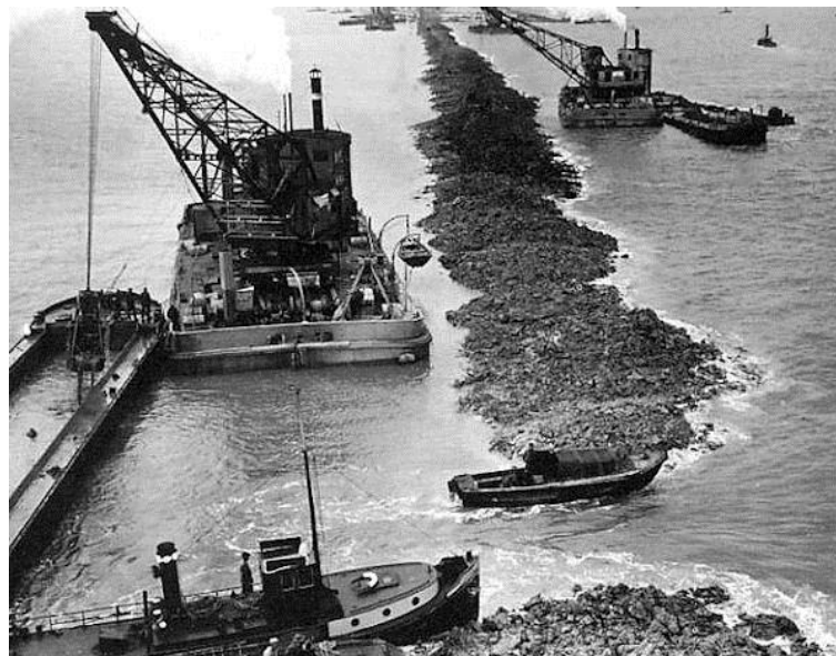
Fig. 1.5 – Construction of the Afsluitdijk (Hakkenes 2017).
