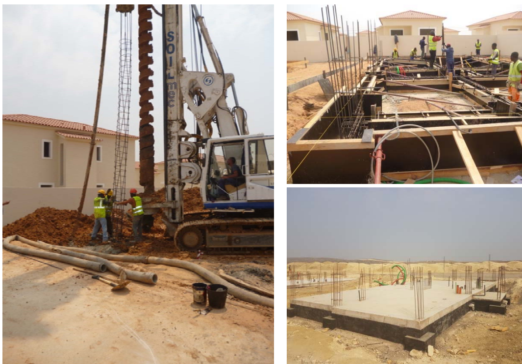
Figura 4.12 – Execução das fundações e laje do piso 0 de uma moradia: realização de estacas (esquerda), execução da cofragem para a betonagem dos maciços de encabeçamento e vigas de fundação (direita, em cima), maciços de encabeçamento, vigas de fundação e laje do piso 0 betonados
