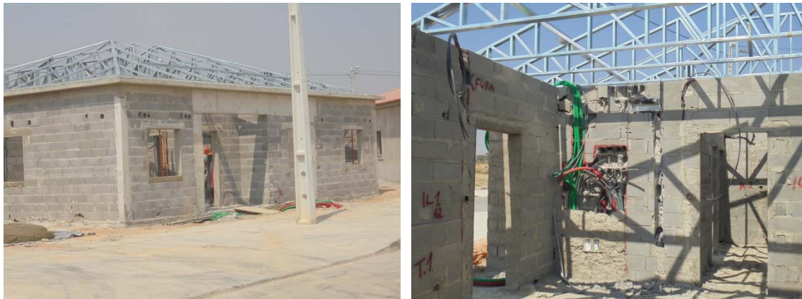
Figura 4.10 – Estrutura da cobertura em treliças de LSF
