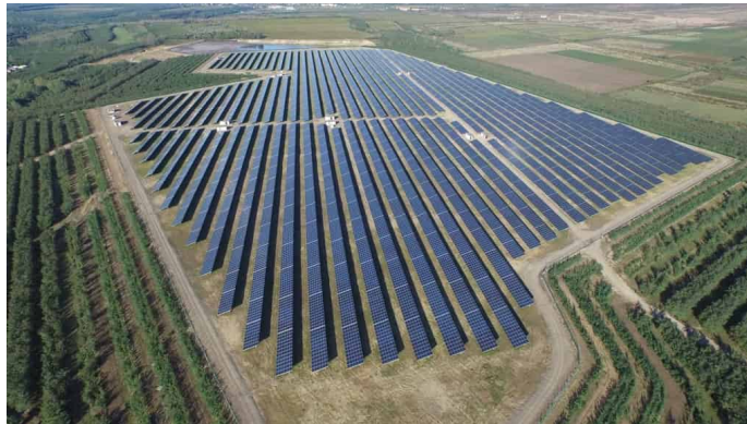
Figura 7 - Central fotovoltaica ligada à rede, com P_N = 18,5MW_p , na Hungria (Ossenbrink 2015).
