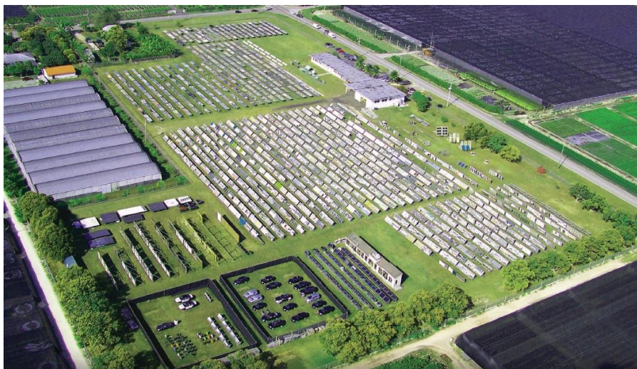
Figura A.5 - Instalações do SFTS. [31]
