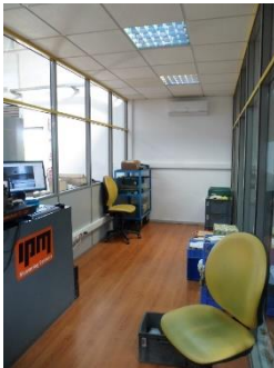
Figura 28 Estado do gabinete Refurbishment Antes da Melhoria
