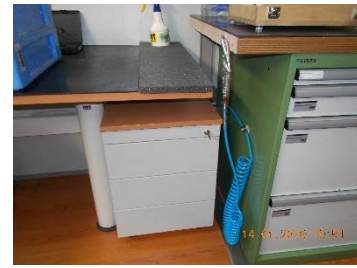
Figura 31 Mangueira de Ar Comprimido Instalada Depois
