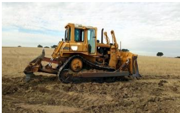
Figura 10. Etapa de estabilização do terreno[27]
