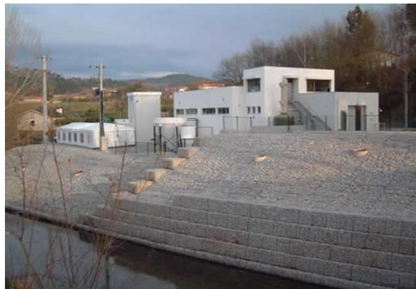
Figura 31 – ETA do Ferro.
