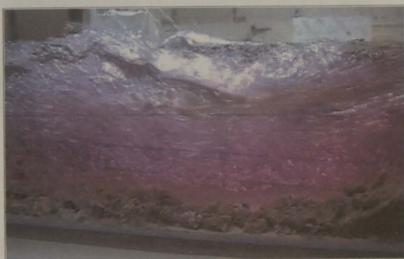
Fotografia 6.35 - Vista da fossa criada pelo escoamento com abertura inferior do vão lateral
