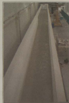
Fotografia A.11 - Ensaio de estanqueidade do canal
