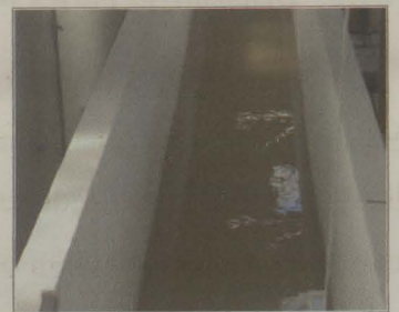
Fotografia A.14 – Ondulação superficial
