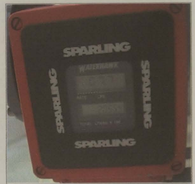
Fotografia 5.10 Calibração do medidor de caudal
