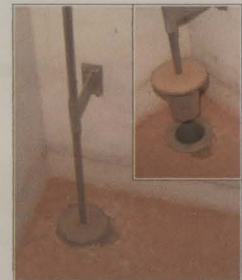
Fotografia A.6 - Descarga de fundo na zona de alimentação do canal
