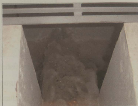
Fotografia 5.17 - Zona de tranquilização Queda
