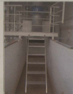
Fotografia A.7 - Escada para acesso ao canal (montante)
