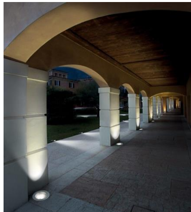
Figura 3.2 - Ilustração da Iluminação Up Light em Colunas [56]
