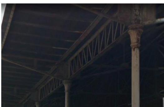
Figura 4.50 - Estrutura em Ferro Trabalhada [70]
