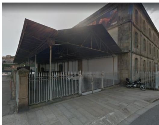
Figura 4.7 - Estrutura Lateral da Alfândega [70]
