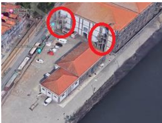
Figura 4.6 - Edifício Lateral "Novo" da Alfândega [70]
