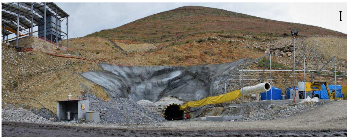
Figura 20: Emboquilhamento da galeria experimental, que fica na base do Cabeço do Lobo, referência do monte (que também dá nome a um vinho famoso da região), onde se destacam ainda o ventilador e a infraestrutura energética à direita, e parte da lavaria à esquerda num nível superior, onde se evidencia o silo de alimentação de um dos moinhos
