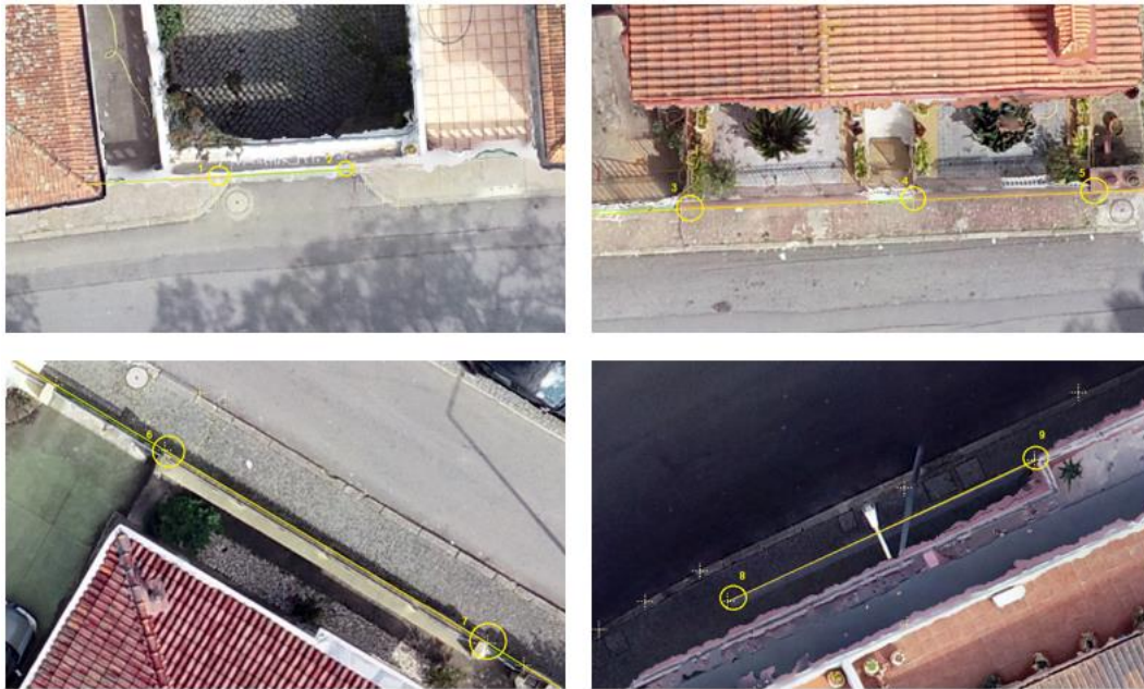
Fig.39 - Representação de imagens com algumas análises feitas na digitalização de muros e vedações.
