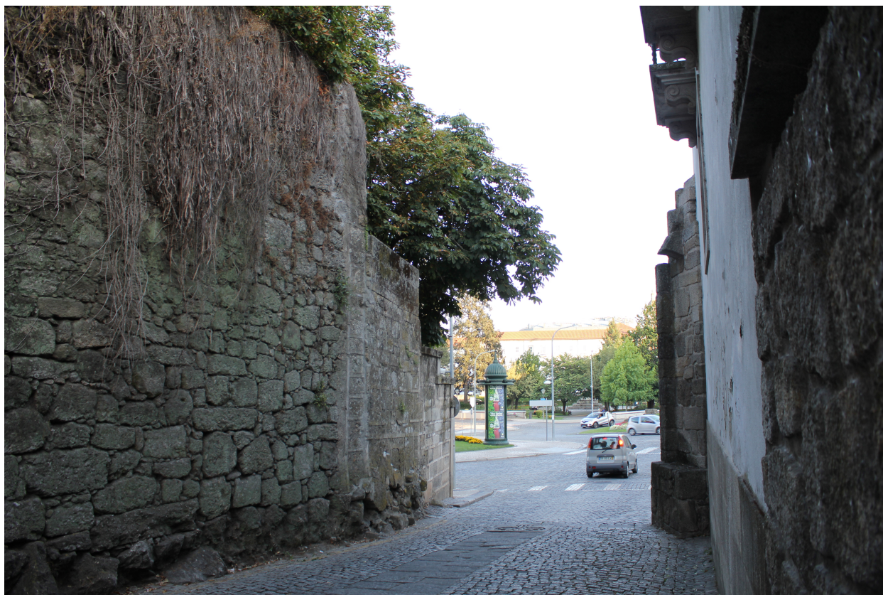
Em cima: pormenor do arranque do antigo arco da Porta e pormenor do muro defronte Em baixo: vista geral do local onde estaria a Porta a partir do interior da rua da Árvore
