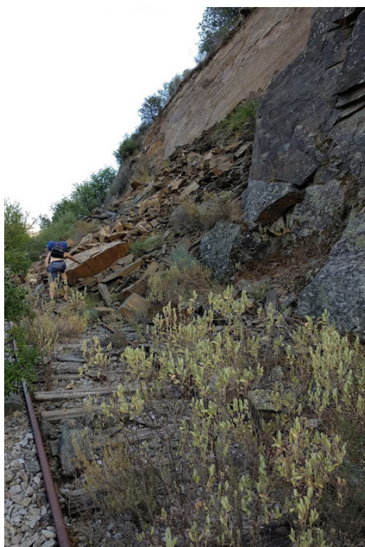
Fig. 75– Derrocada sobre os carris. Fonte: Elaborada pela autora. Fig. 76– Poste danificado e suspenso sobre a linha. Fonte: Clara Pimenta do Vale, 2016 Fig. 77– Interior destruído de um edifício abandonado ao longo da linha férrea. Fonte: Elaborada pela autora
