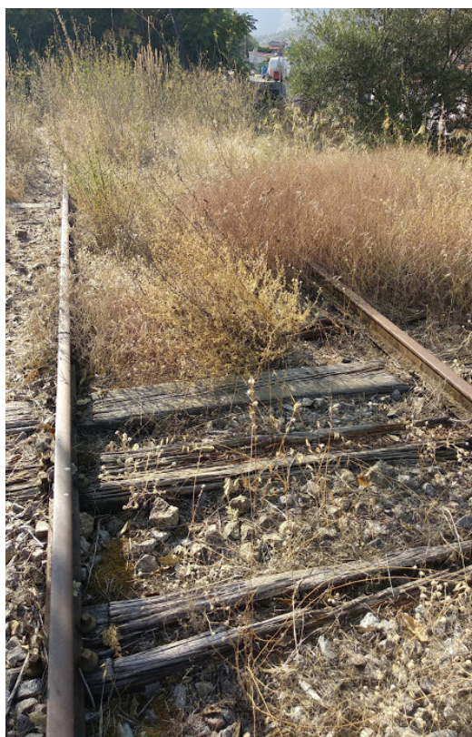
Fig. 72– (dir.) Carris e travessas de madeira danificadas. Fonte: Elaborada pela autora Fig. 73– (cima, dir.) Vegetação ao longo da linha férrea desativada. Fonte: André Ferreira. Fig. 74– (baixo, dir.) Troço da linha férrea sem carris. Fonte: Elaborada pela autora
