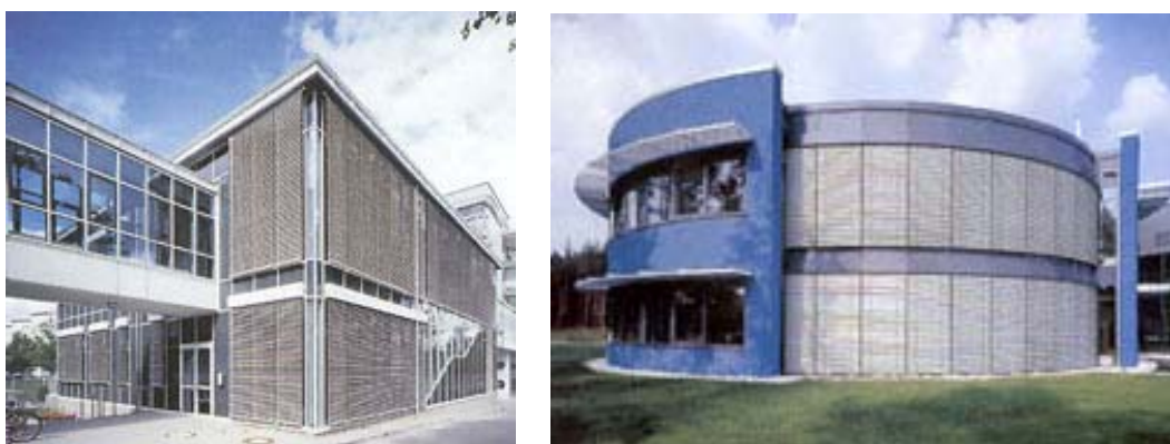
Figura 4.13 - Sistemas de Protecção Solar – Estores exteriores em edifícios com grande percentagem de envidraçados http://www.cruzfer.pt/cgi-bin/cruzfer
