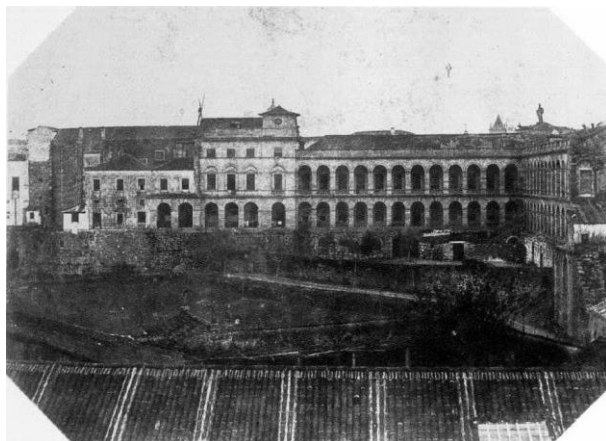
Figura 407 - Hospital de Santo António em construção, em 1849, fotografia de Frederick William Flower, disponibilizada em https://bit.ly/2PsPqnK .
