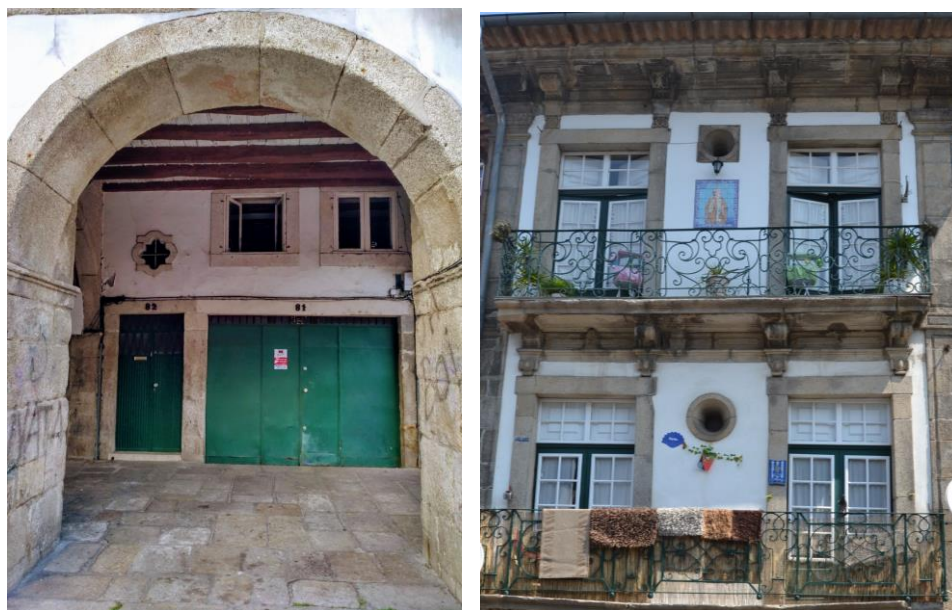
Figura 106 – Óculos na fachada de duas casas na rua de Miragaia. 2018.
