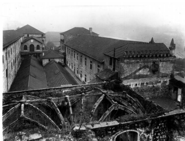
Figura 381 - Vários aspectos do Convento de Monchique, arquitectura manuelina do século XVI. Obra de Diogo de Castilho. «Cruzaria de ogivas da cobertura da igreja, À direita, o único torreão existente dos dois que ladeavam o corpo do edifício. Este torreão, do lado poente, apresenta ainda coruchéus com merlões do tipo «gótico alentejano». Os elementos da abóbada desapareceram por volta de 130 (sic?), estando o corpo da igreja hoje coberto por um telhado parcialmente em ruína». Fotografias da Coleção Vitorino Ribeiro. 1983. AHMP.
