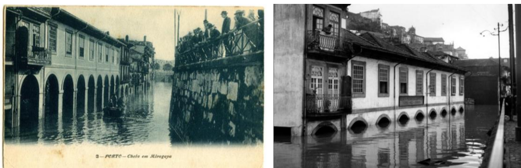
Figura 278 – Esq.: Armazéns da rua de Miragaia durante uma cheia. Bilhete postal ilustrado. 1910. AHMP, disponível em linha: https://bit.ly/2z4b2N4 ; Dir.: Armazéns da rua de Miragaia durante uma cheia. Fotografia de Teófilo Rego. 1962. AHMP, disponível em linha: https://bit.ly/2qEQaY8 .
