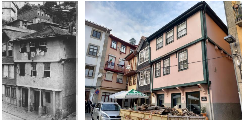
Figura 104 – Esq.: Casa com os andares superiores levantados em tabique. 1933. Bomfim Barreiros. AHMP, disponível em linha: http://bit.ly/2B8bsn5 . Dir.: A mesma casa em 2018, alojamento local, Miragaia House . Rua de Miragaia.
