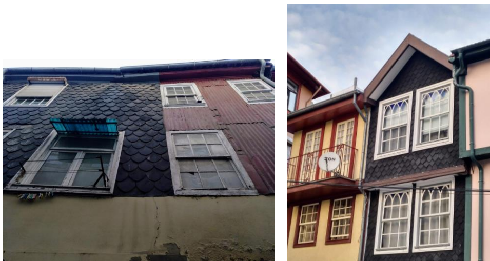
Figura 135 – Esq.: Edifícios revestidos a lousa (escamas de ardósia) e chapa, rua da Arménia. 2018; Dir.: Casa com o revestimento em lousa, rua de Miragaia. 2018.
