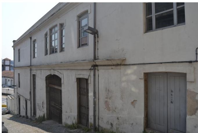
Figura 325 – Edifício onde se situam os escritórios da Sociedade. 2018.
