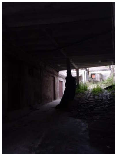
Figura 318 – Uma das entradas de acesso ao referido pátio, através da calçada de Monchique. 2018.
