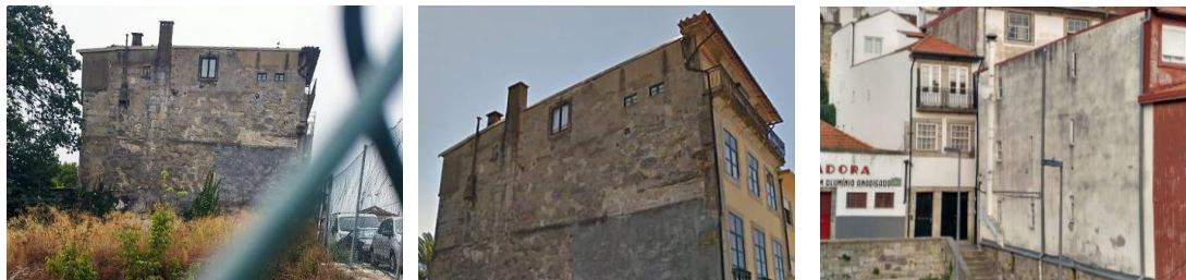
Figura 133 – Janelas e postigos rasgados na empena. Largo do Viriato. Rua da Arménia e rua de Miragaia.
