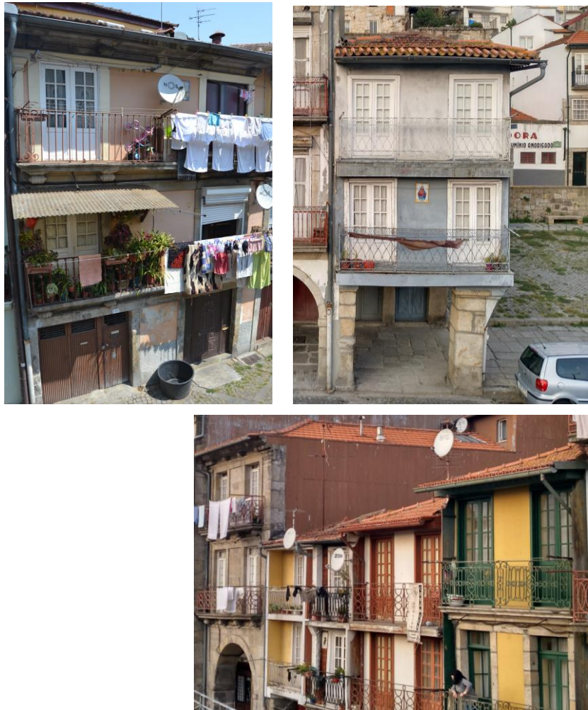
Figura 107 - Fachadas com pano de parede fechado entre os vãos. Casas na rua de Miragaia. 2018.
