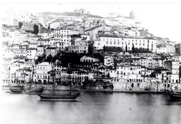
Figura 121 - Vista da zona ribeirinha: fins do séc. XIX. Bilhete postal ilustrado, s/d. AHMP, disponível em linha: http://gisaweb.cm-porto.pt/units-of-description/documents/49700/?q=miragaia+xix
