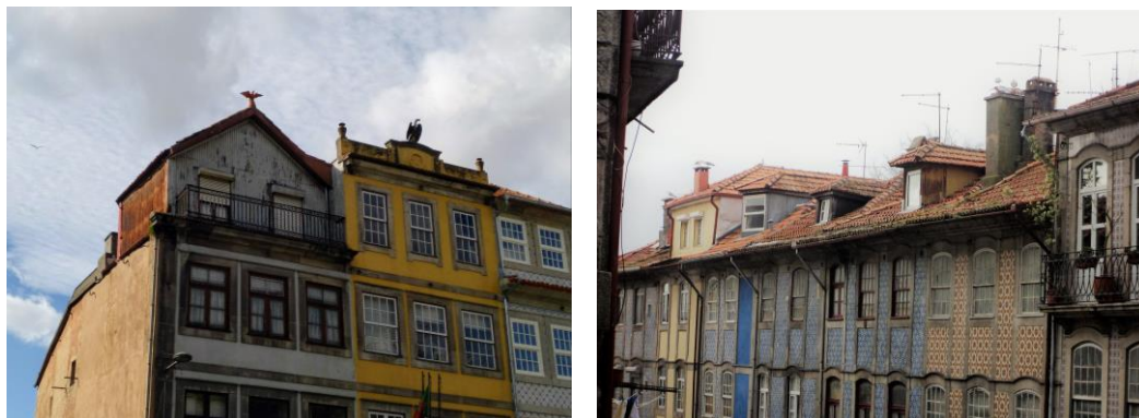
Figura 125 – Janelas de sacada com guardas de ferro, na rua Professor Vicente José de Carvalho, ao Campo dos Mártires da Pátria, 2018. Dir: Molduras em cantaria, nos edifícios da rua do Dr. Barbosa de Castro. 2016.
