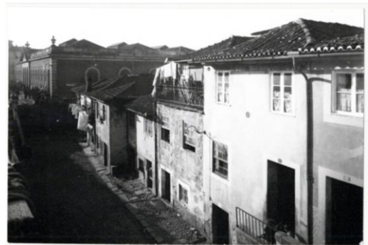
Figura 423 – Edifícios demolidos para dar lugar ao Palácio da Justiça. Ao fundo, o antigo Mercado do Peixe. Bilhete postal ilustrado. s/d. AHMP, disponível em linha: http://gisaweb.cm-porto.pt/units-of-description/documents/49642/?q=mercado+do+peixe
