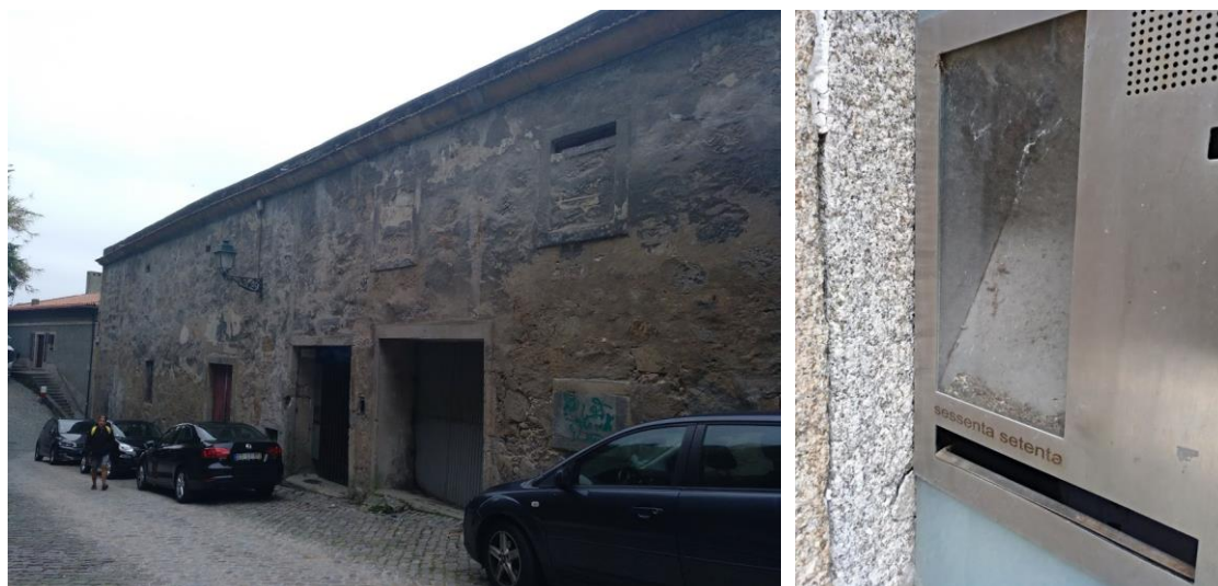
Figura 323 - Aspeto exterior do edifício. Rua de Sobre-o-Douro. 2018.
