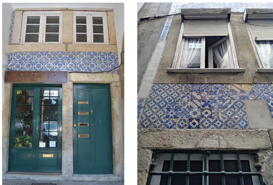
Figura 219 – Exterior da casa que serviu de mostruário. Rua de Miragaia e rua Arménia, 2018.
