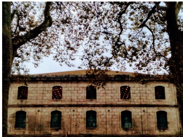
Figura 344 – Pormenor do edifício da alfândega ao entardecer. 2018.
