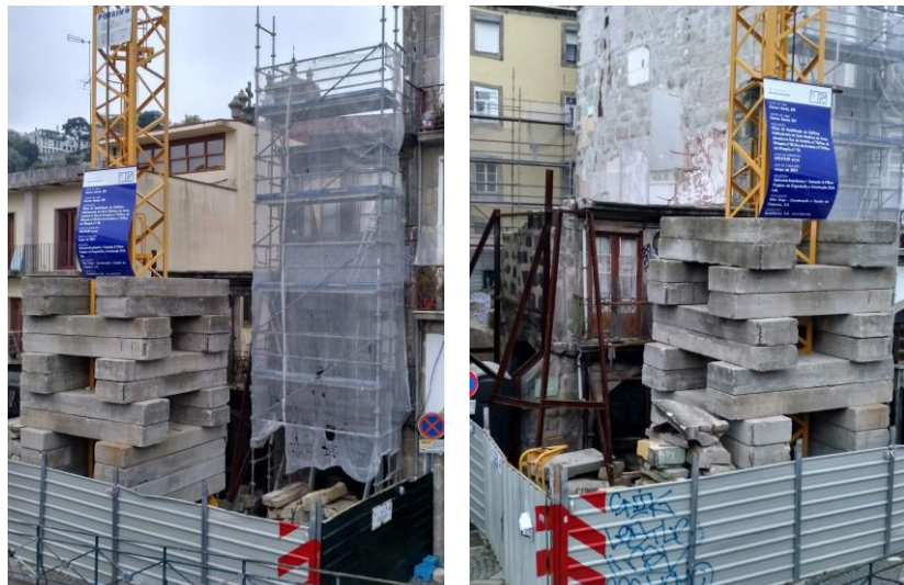
Figura 183 – Edifício em reabilitação pela Domus Social, projeto da Apicarote Arquitectos. Frente voltada à rua de Miragaia n.ºs 56/58. 2018.
