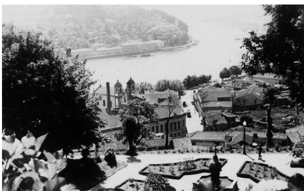
Figura 433 - A zona ribeirinha de Massarelos e o edifício da Cervejaria Leão vista dos jardins do Palácio de Cristal, c. 1930. Fotografia disponibilizada em https://bit.ly/2T4DK93
