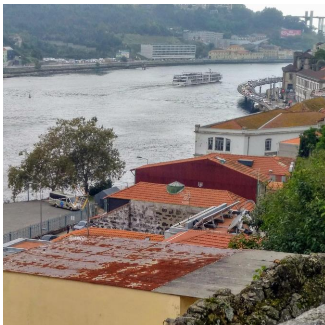
Figura 111 – Claraboia em telhado da rua de Miragaia, vista do miradouro das Sereias. 2018.
