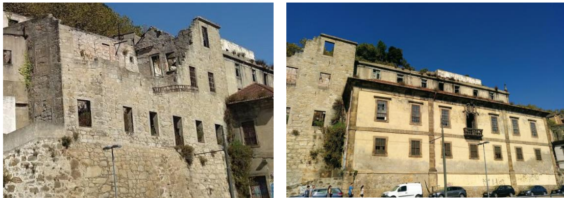
Figura 272 – Armazéns e Casa do Cais Novo, 2018.
