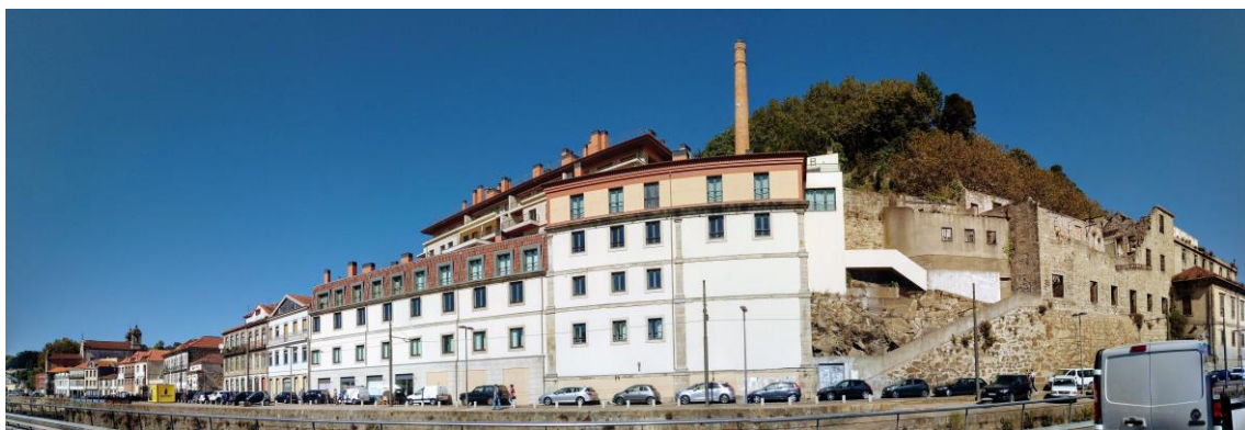
Figura 223 – Panorâmica do edifício atual. Cais das Pedras/Rua de Monchique. 2018.
