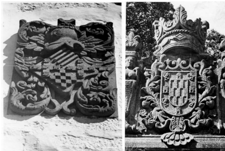
Figura 389 – Esq.: Pormenor da pedra de armas do século XVII, (heráldica de família Rocha, Ferreira (?) e Barbuda (?)) existente na casa n.º 32, da rua de São Pedro de Miragaia. Fotografia de Bomfim Barreiros. 1943. AHMP, disponível em linha: http://gisaweb.cm-porto.pt/units-of-description/documents/334465/? . Dir.: Pormenor da pedra de armas do século XVIII, (heráldica de família Portocarreiro) existente na Casa das Sereias, na rua da Bandeirinha. Fotografia de Guilherme Bomfim Barreiros. 1943. AHMP, disponível em linha: http://gisaweb.cm-porto.pt/units-of-description/documents/334078/?q=casa+sereias
