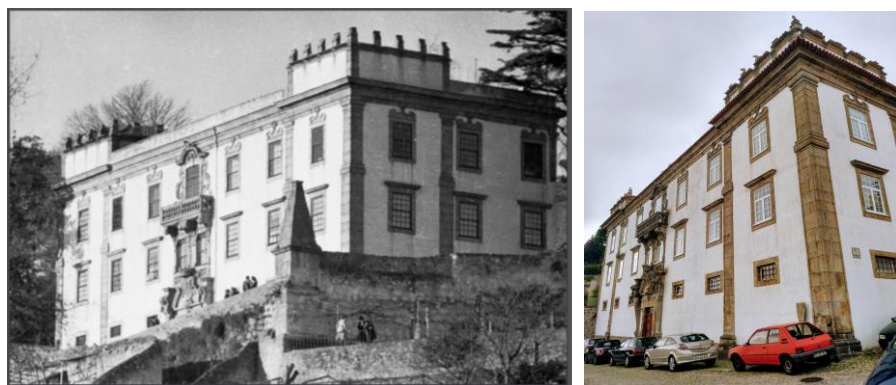
Figura 141 - Esq.: Vista geral fachada da Casa das Sereias, na rua da Bandeirinha. Arquivo Barreiros, Guilherme Bomfim. 1894-1973. AHMP, disponível em linha: https://bit.ly/2DCeW3u ; Dir.: Casa das Sereias em 2018.
