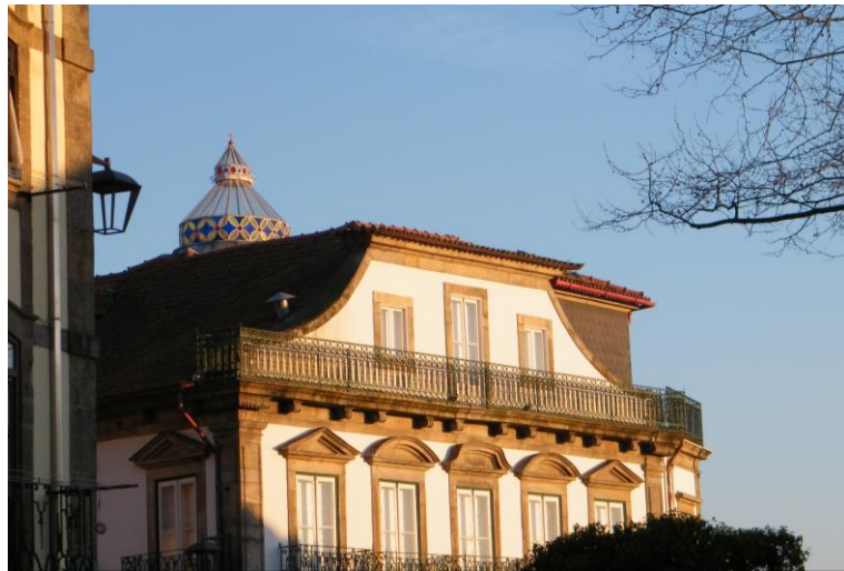
Figura 139 – Pormenor da fachada principal e da claraboia do edifício. Fotografia de Vera Gonçalves. 2017
