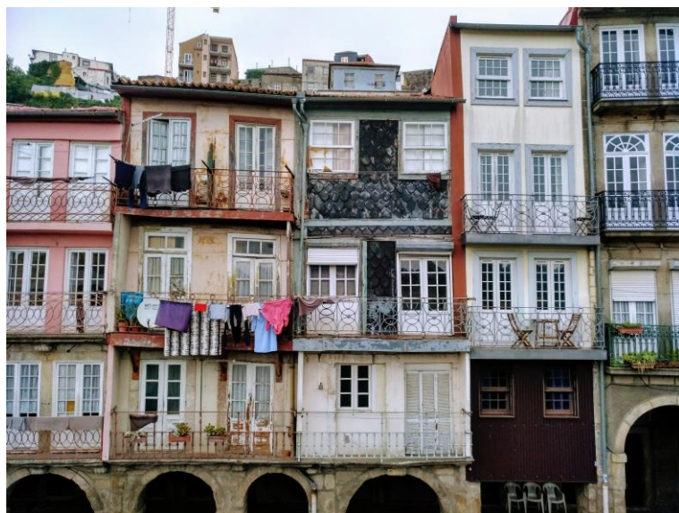
Figura 105 - Edifícios cujos pisos superiores foram erguidos com estrutura de tabique. Rua de Miragaia. 2018.
