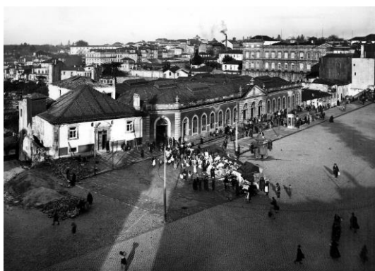
Figura 49 - Fachada principal do Mercado do Peixe e Casa da Roda dos Expostos (à esquerda). AHMP: F-P/CMP/10/279(3).
