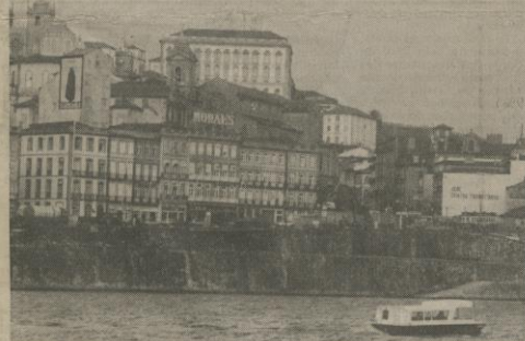
Estes paredes serão aproveitadas para a construção de um parque automóvel, que ficará camuflado. A área superior, que será coberta, englobará a construção de um café com esplanada.
