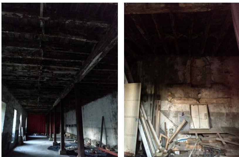
Figura 320 – Interior do edifício correspondente aos aposentos do Capelão. 2018.
