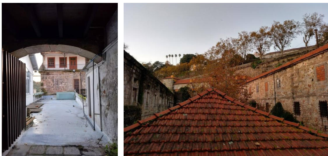
Figura 321 – Exterior do edifício correspondente aos aposentos do Capelão. 2018.
