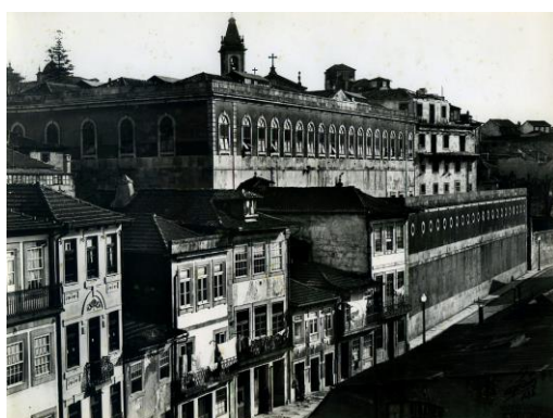
Figura 87 - Mercado do Peixe. À direita, vê-se a cobertura da Fábrica Electra. Fotografia Alvão. AHMP: D-PST/1687
