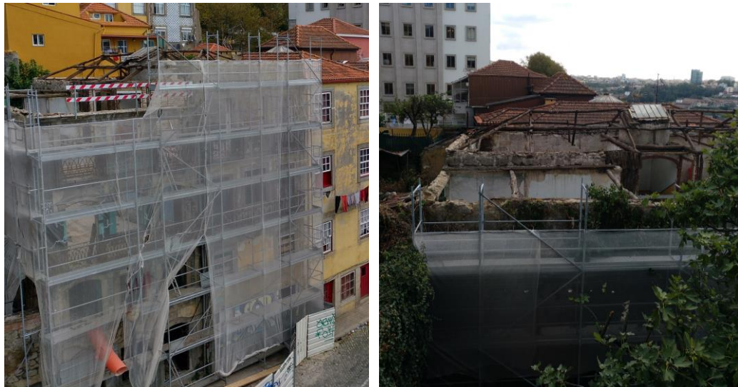
Figura 185 – Os mesmos edifícios em obras. Outubro de 2018.
