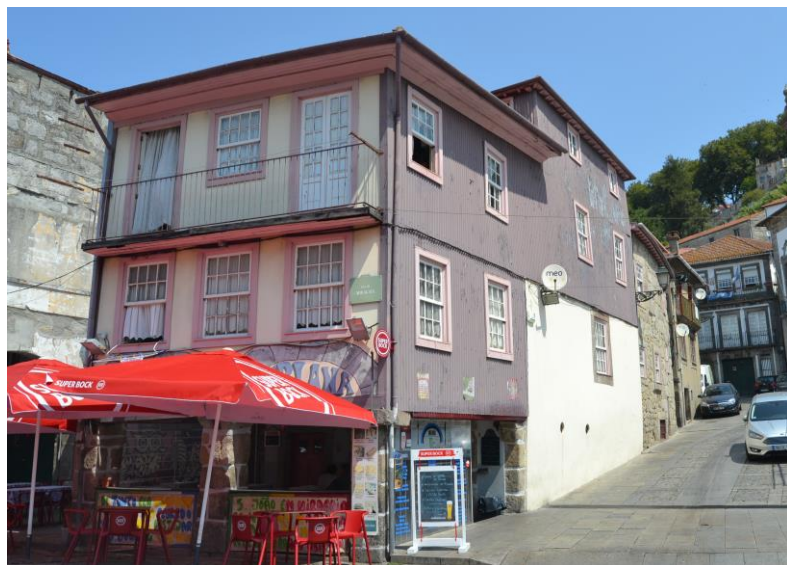
Figura 172 – Aspeto do mesmo edifício em 2018, após a intervenção. As duas casas contíguas do lado esquerdo foram demolidas.
