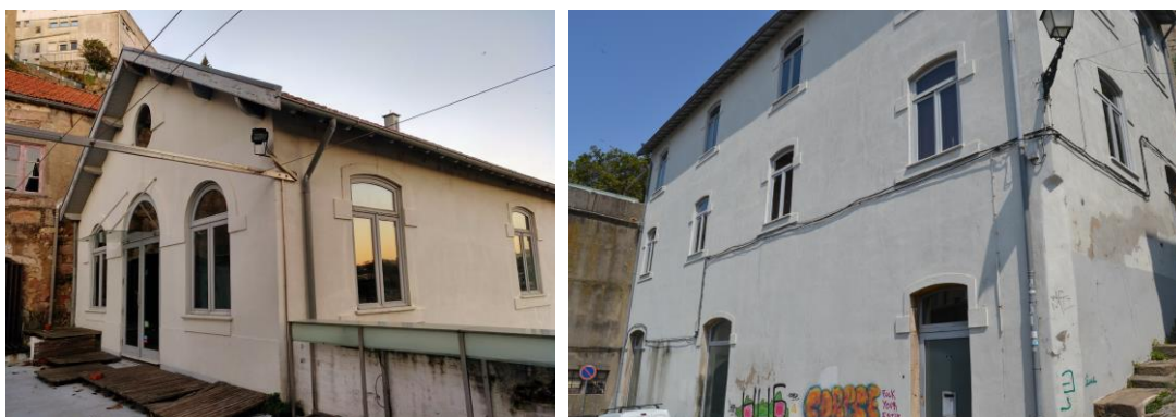
Figura 322 – Esq.: Remate superior de um dos edifícios que serviu como armazém da fábrica de cortiças de Clemente Menéres. Entretanto, neste piso cimeiro, funcionaram os restaurantes Sessenta e Sardinha Alfândega . Dir.: parte inferior do edifício. 2018.
