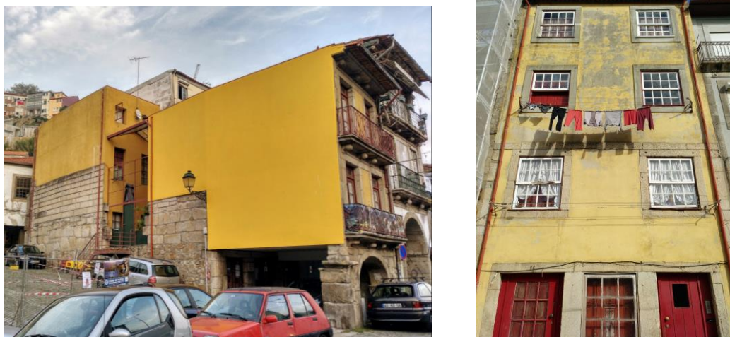
Figura 167 – Edifícios intervencionados pelo CRUARB, na rua de Miragaia (à esquerda) e na rua de Azevedo de Albuquerque (à direita). 2018.
