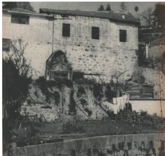
Figura 162 – Edifício utilizado pela Associação de Moradores de Miragaia, e estado da fonte em 1976. Terrenos do Monte dos Judeus. Arquivo Fernando Távora. FIMS_FT_0198-12-0078.
