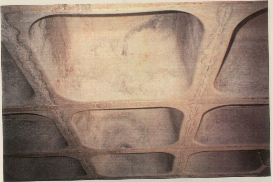
Fig. 4.21- Superfície moldada com cofragem de plástico que deu origem a uma superfície com cor uniforme
