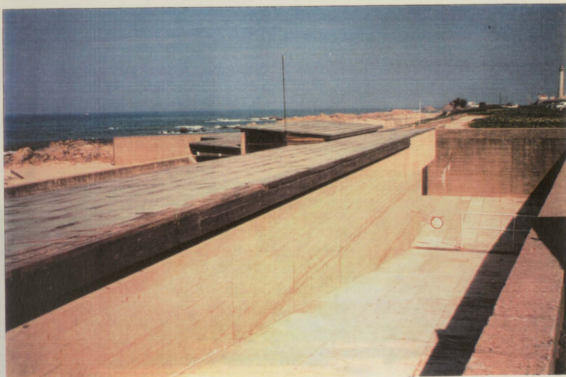
Fig. 1.1- Piscina de Leça da Palmeira- executada em 1960-67
