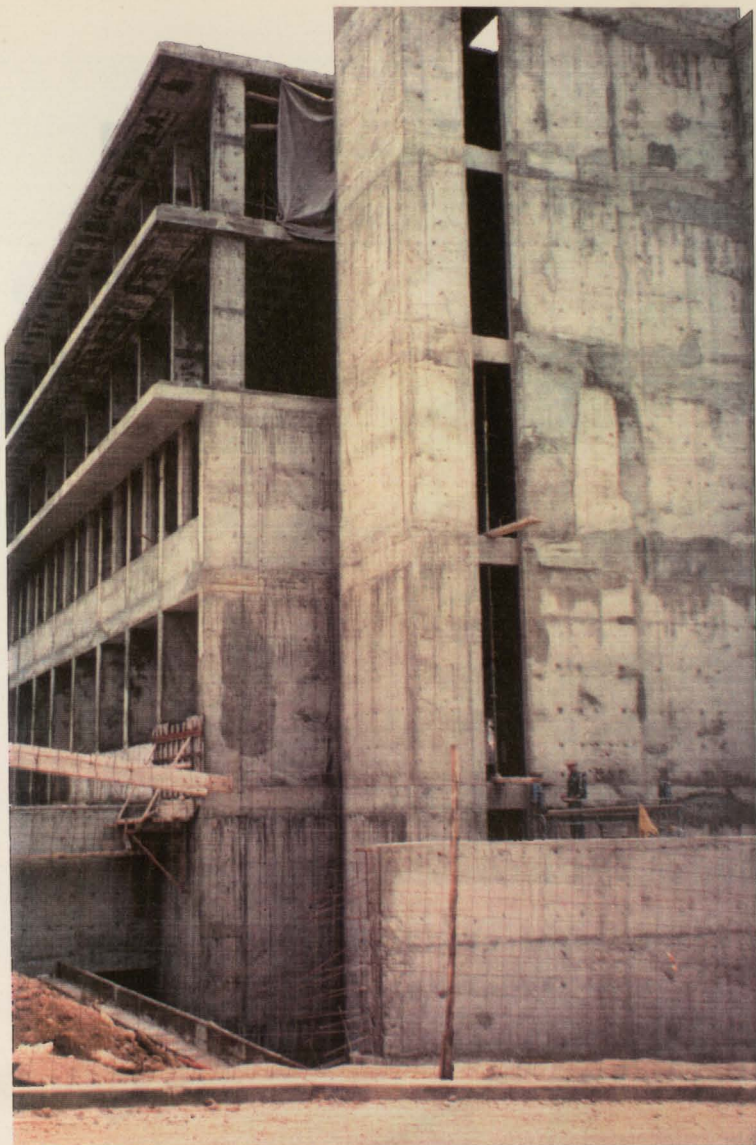
Fig. 5.9- Vista do mesmo edifício referido na fig. anterior onde se vê as sujidades provocadas pelo decurso dos trabalhos
