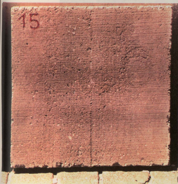
Fig. 6.19- Composição IV Cofragem- madeira aparelhada com metal
