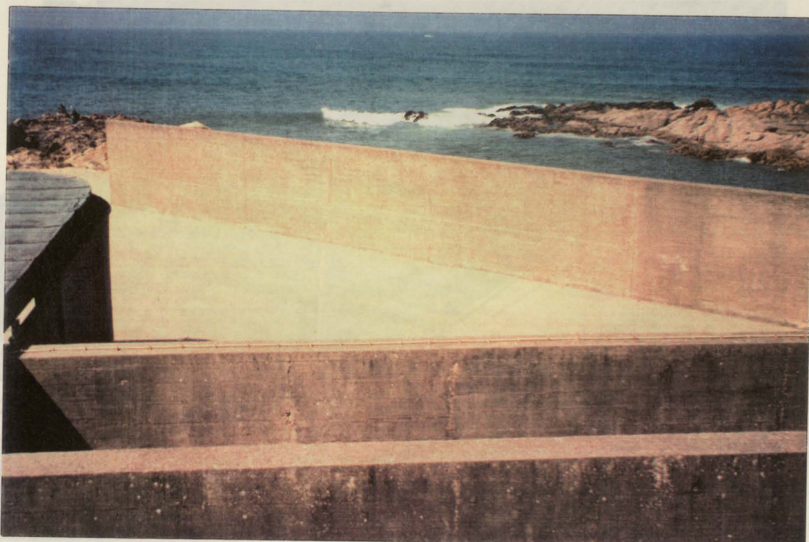
Fig. 9.7- Betão aparente junto ao mar com 25 anos de idade e que se comportou até agora de maneira excelente
