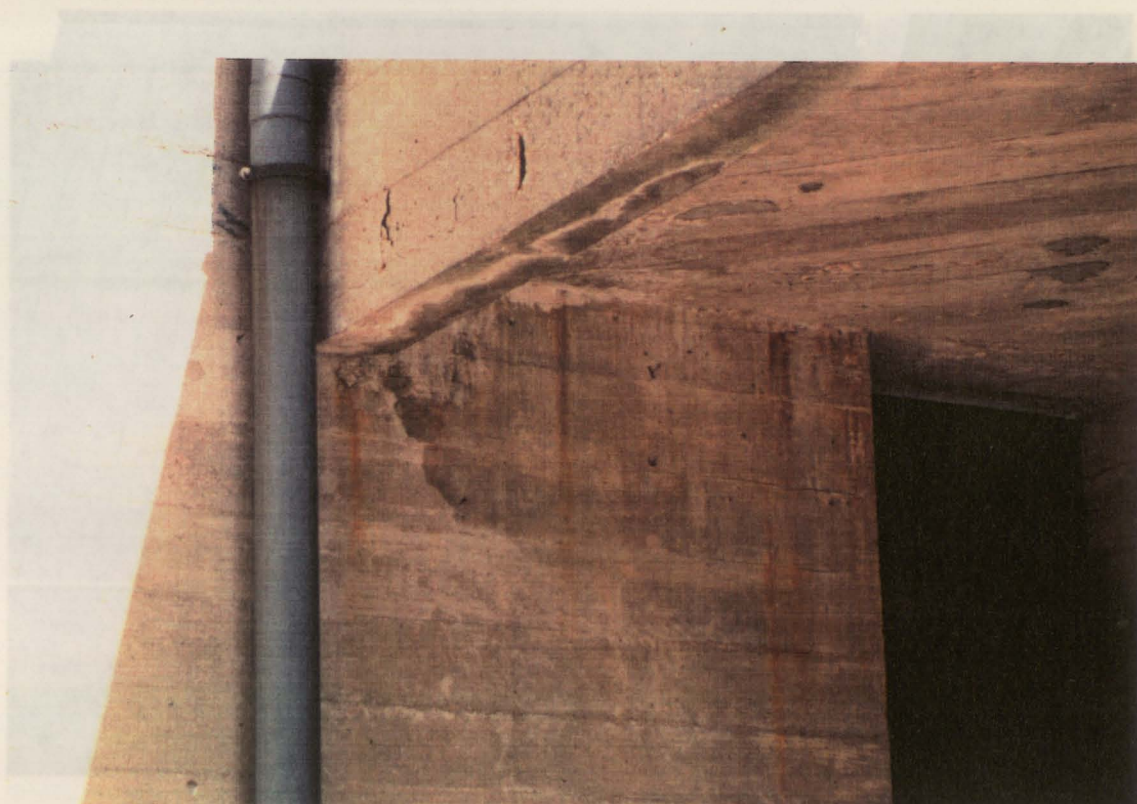
Fig. 9.4- Betão sujeito ao ataque da acção química
