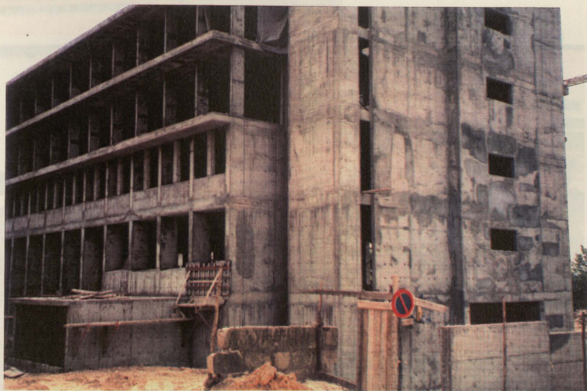
Fig. 5.8- Aspecto de um edifício em construção destinado a ficar em betão aparente
