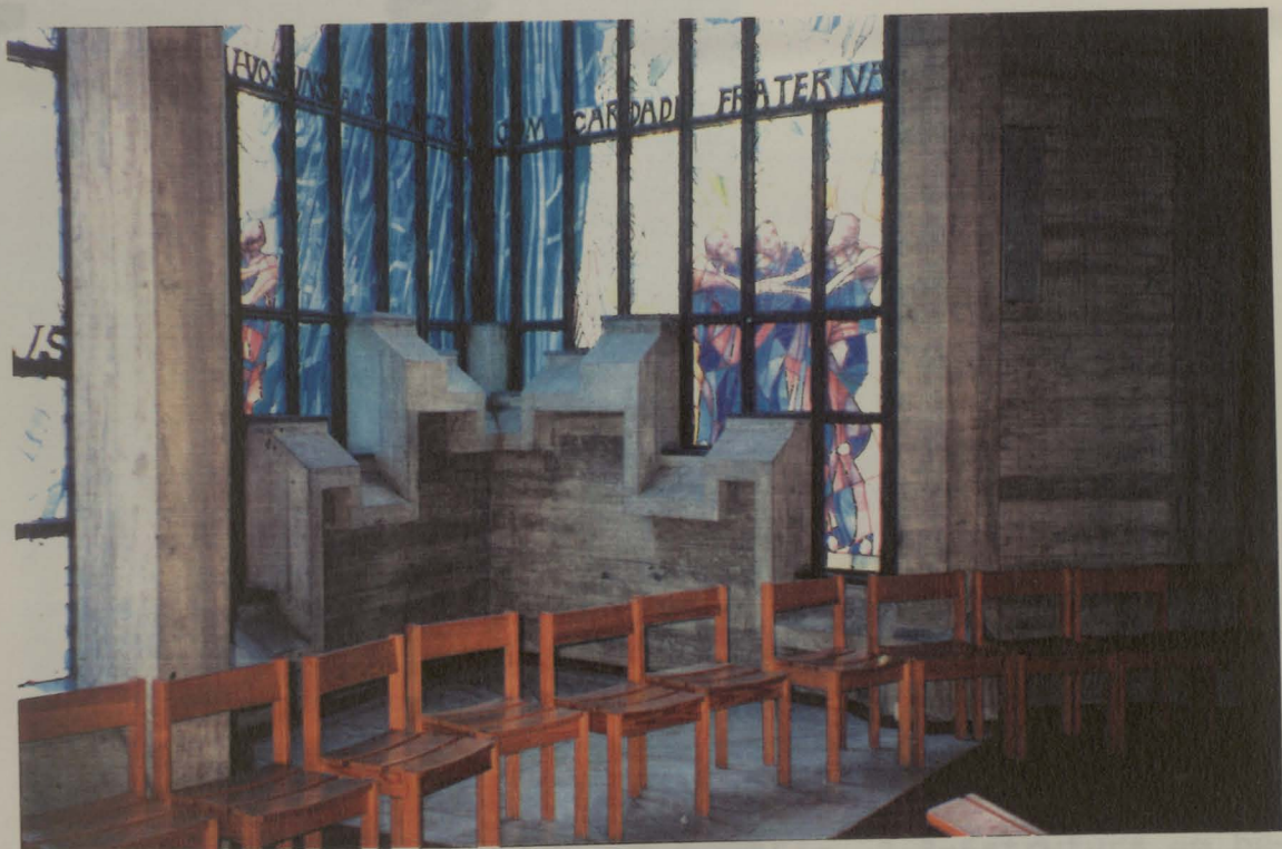
Fig. 3.6-Interior da Igreja da N.ª Senhora da Boavista. Exploração de formas arquitectónicas conseguidas com cofragem de madeira
