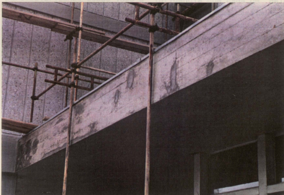
Fig. 9.10- Pormenor de grande reparação no mesmo edifício representado na figura anterior
