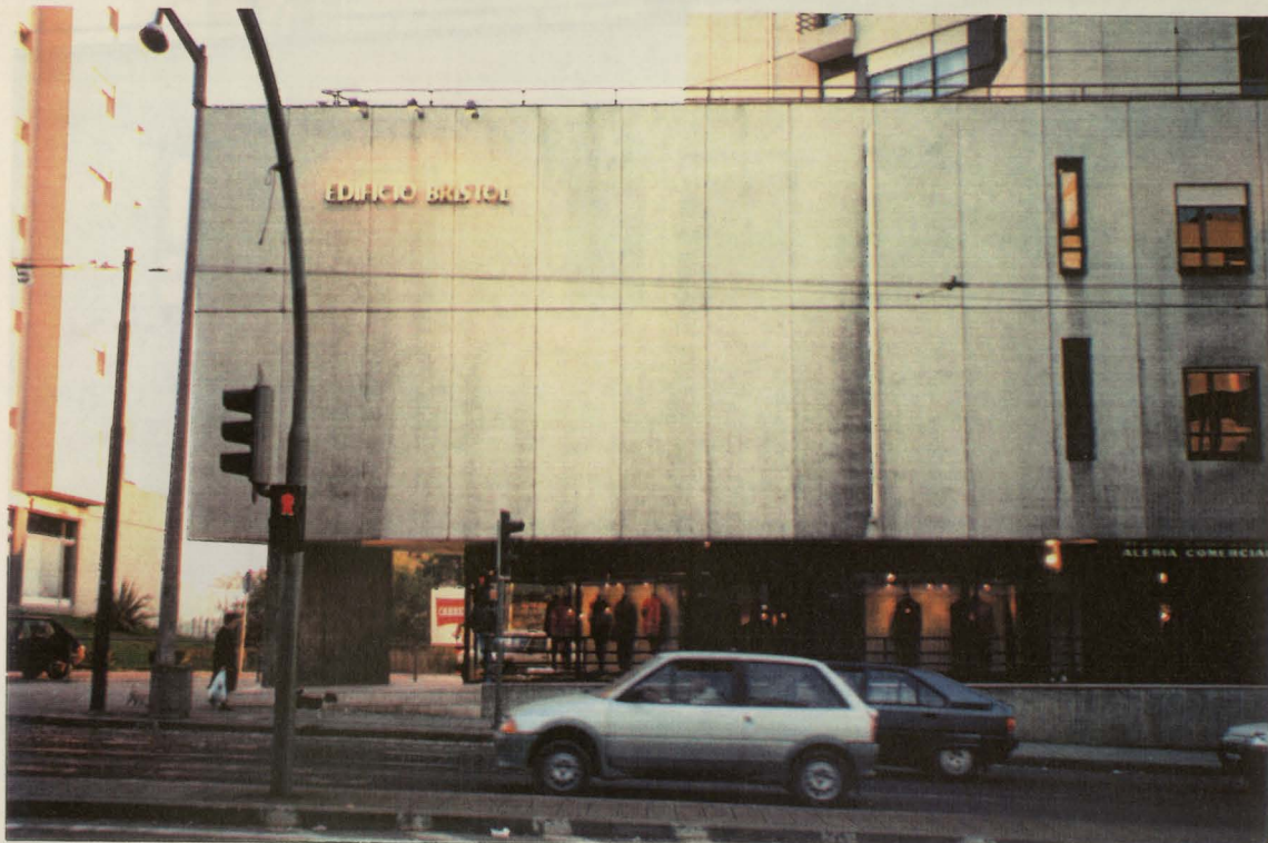
Fig. 9.1- Superfície de betão sujeita durante anos ao tempo
