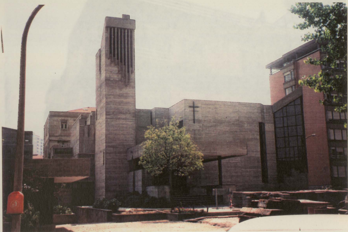
Fig. 1.3- Igreja da N.ª Senhora da Boavista construída integralmente em betão aparente - Arq. Augusto Ricca
