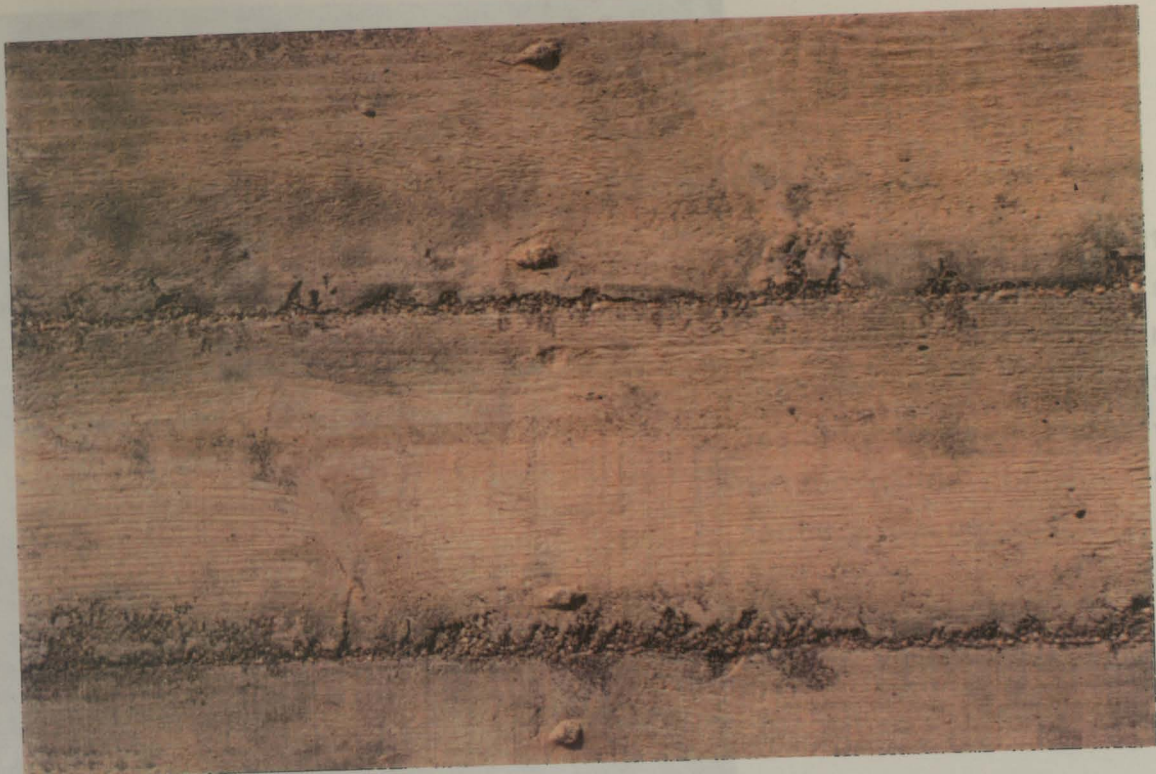
Fig. 3.7- Pormenor de uma superfície de betão cofrado com madeira em que se verifica as consequências da fuga de calda de cimento pelas juntas das tábuas
