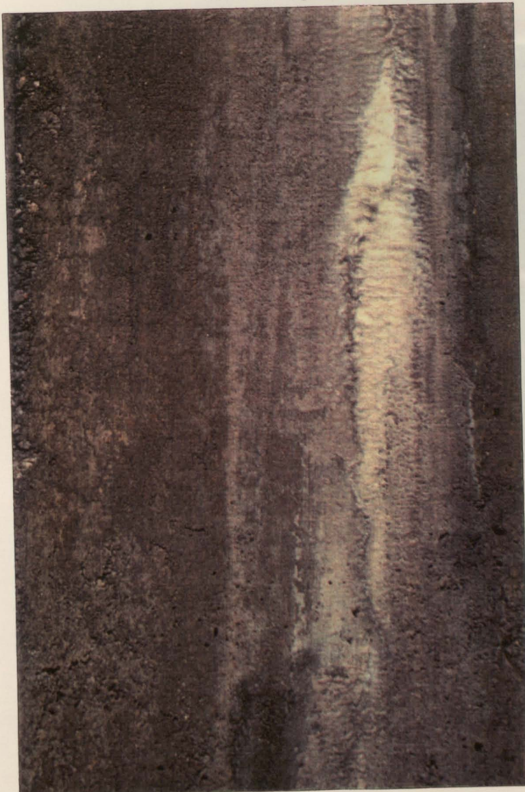
Fig. 4.21- Superfície moldada com cofragem de plástico que deu origem a uma superfície com cor uniforme
