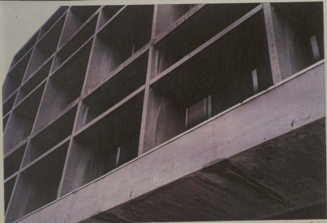
Fig. 3.10- Estruturas prefabricadas executadas em moldes metálicos
