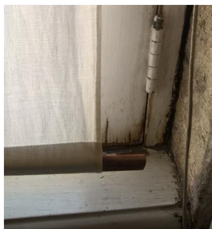
Fig.8 – Pormenor de janela da Sala de Jantar
