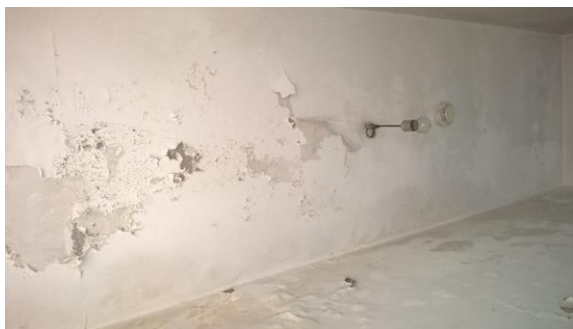
Fig.5 – Teto do Corredor do 1º Piso
