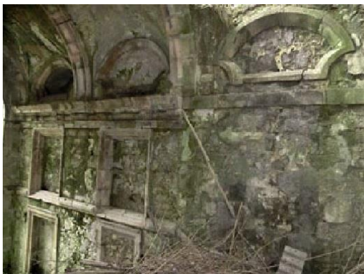
Figs. 33 e 34– vista do interior da Capela-Mor a partir da parede do altar. Em Baixo: Detalhe da parede poente da Capela-mor. Podem ver-se entaipadas todas as aberturas desta parede. O restante espaço de parede disponível poderia servir como suporte para trabalho de talha dourada.
