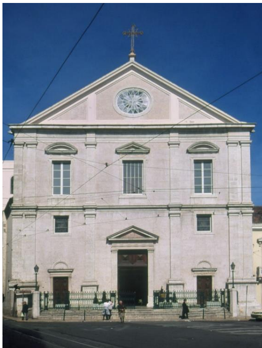
Fig. 49 - Fachada da igreja de São Roque, Lisboa.
