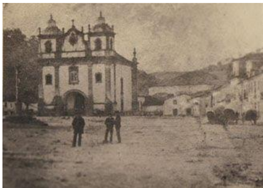
Fig. 75 – Igreja Nova de Alcobaça, no Rossio de Alcobaça (demolida).
