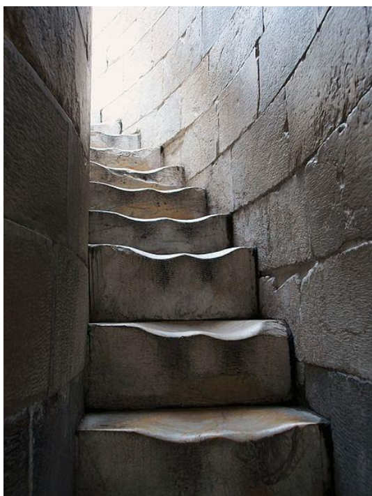
Fig. 10 - Desgaste humano provocado na escadaria interior da Torre de Pisa.
