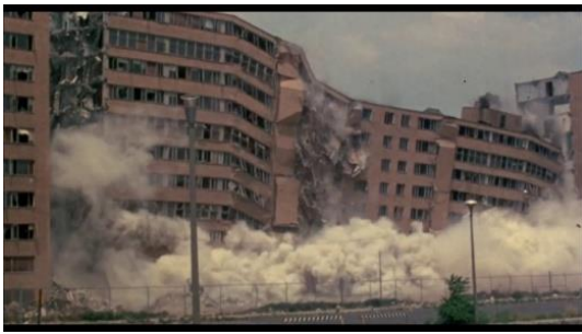
Fig. 25 - Demolição de Pruitt Igoe. Frame do Filme "Koyaanisqatsy" (1982), de Godfrey Reggio.
