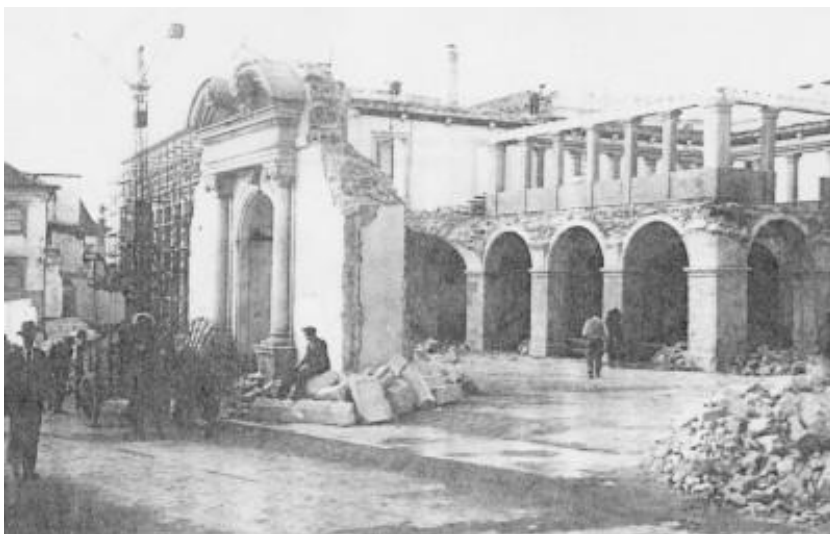
Fig. 80 – aspecto da demolição da Alta de Coimbra – O Colégio de S. Boaventura em fase de demolição adiantada para posteriormente se construir o Departamento de Antropologia.
