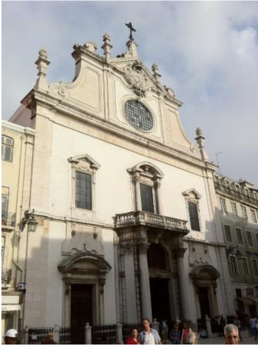
Fig. 40 – Portal da Basílica Patriarcal de Lisboa, hoje aplicado como portal da Igreja de São Domingos, Lisboa.
