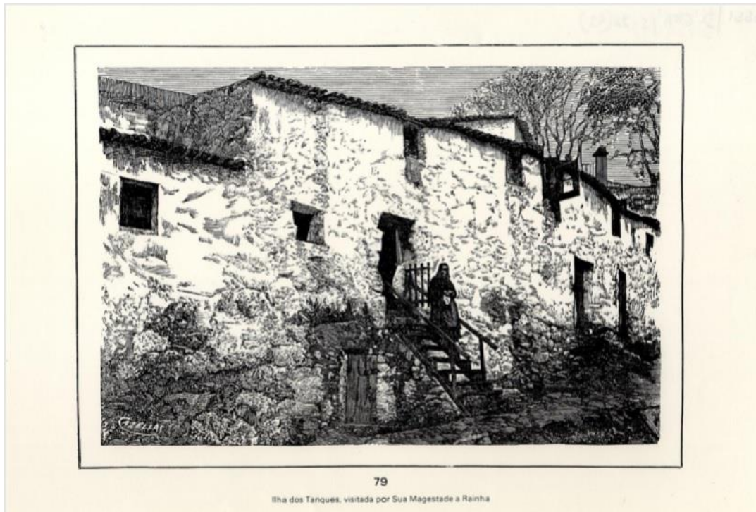
Figura 25: Casa na Ilha dos Tanques
