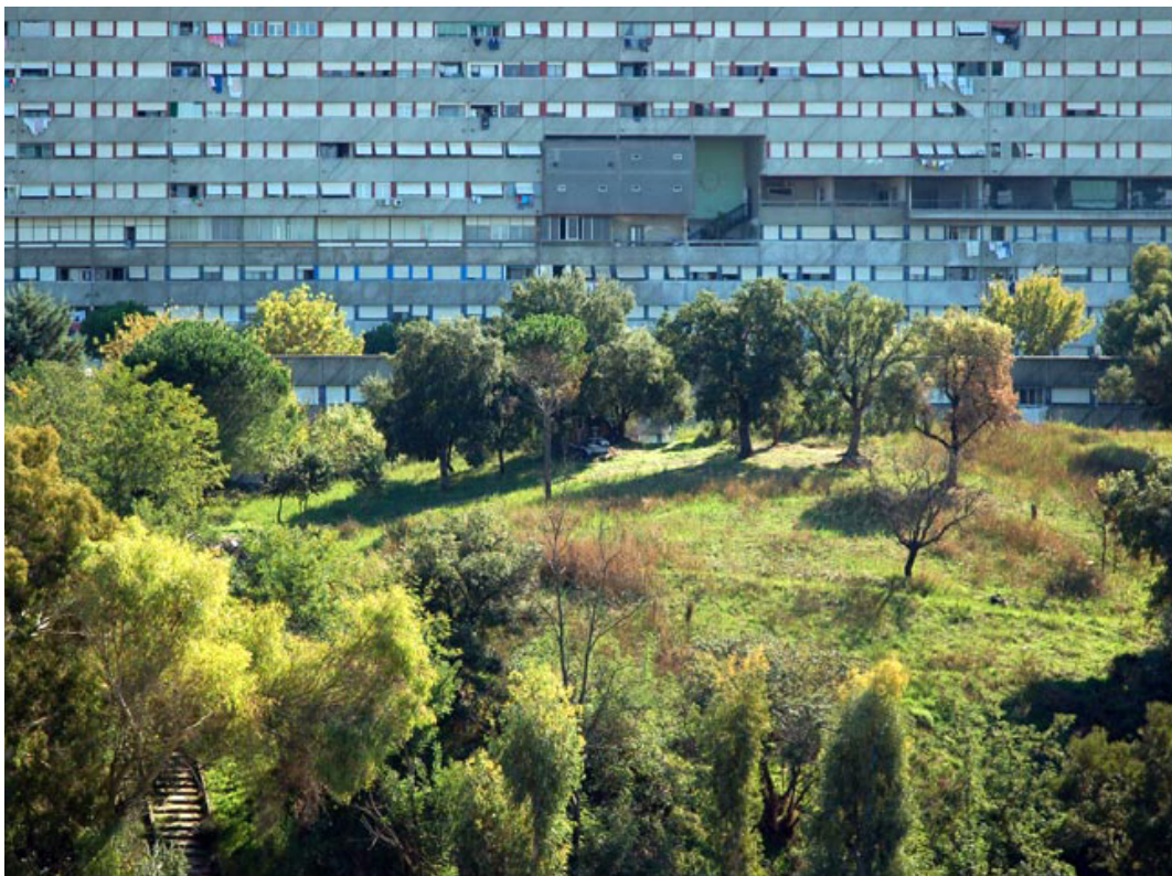
figura 19 Corviale, Roma, desenhado por Mario Fiorentino em 1972, as primeiras famílias entraram no prédio em 1982, as obras nunca foram acabadas. Em 2009 começou um projeto de requalificação. Fonte: https://it.wikipedia.org/wiki/Corviale#/media/File:Corviale_III.jpg , consultado no dia 26/08/2018
