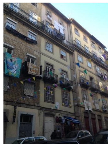
55. Fachada do edifício na Rua de São João
