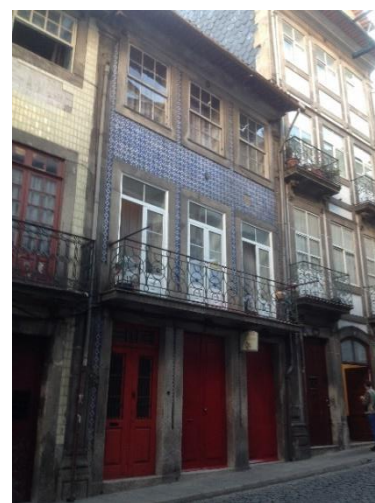
56. Fachada do edifício na Rua de Belomonte
