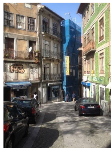
52. Fachada do edifício na Rua do Loureiro
