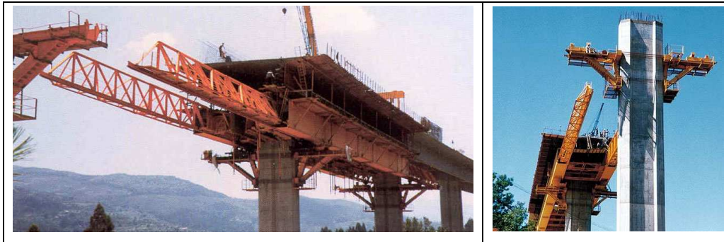
Figura II.27 – CA inferior apoiado em consolas – cortesia NRS
