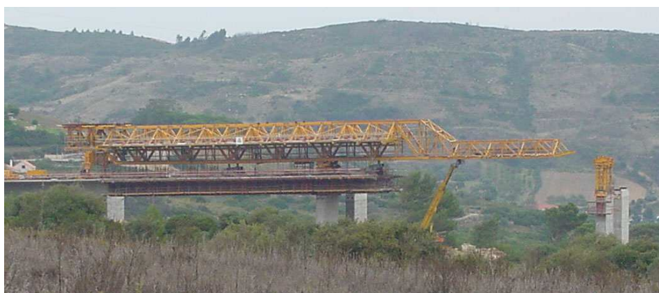
Figura II.11 – CA superior – Execução dum viaduto na auto-estrada A10 – cortesia Brisa
