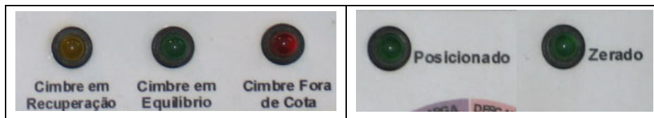
Figura IV.40 – “Led’s” existentes na consola do Sistema de Controlo
