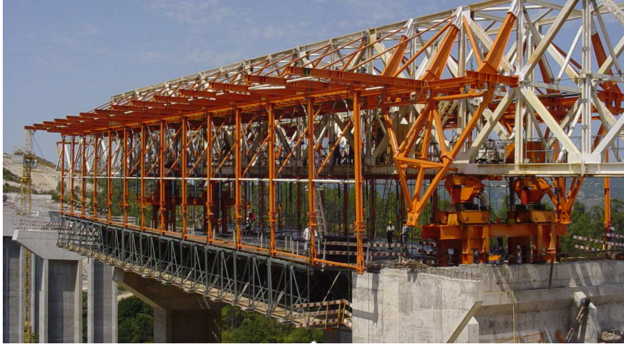
Figura IV.13 – CA superior posicionado para execução do primeiro tramo. Apoio traseiro sobre o encontro e apoio dianteiro no primeiro pilar.
