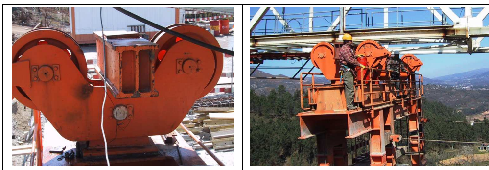
Figura II.29 – “ Bogie ” (esquerda); avanço do CA sobre o “ bogie ”(direita) – cortesia Mota-Engil
