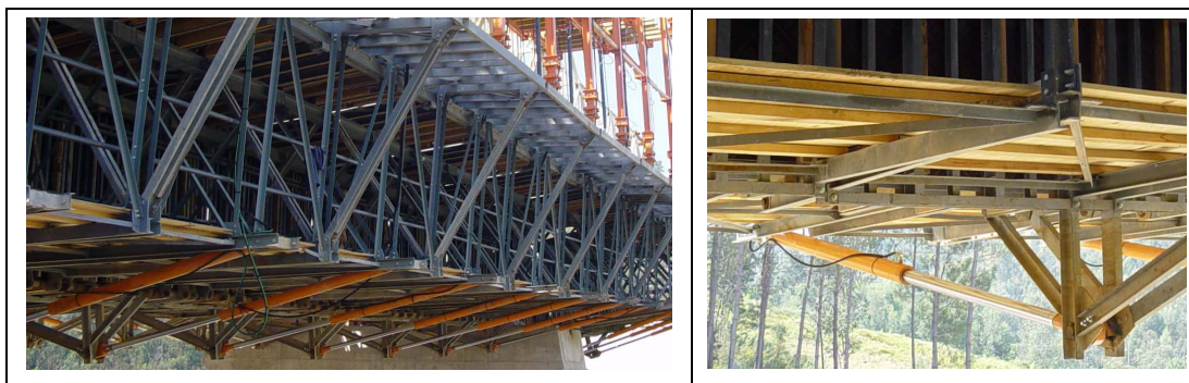
Figura II.16 – CA Superior equipado com sistema óleo-hidráulico para abertura/fecho das cofragens. Perspectiva geral (à esquerda) e pormenor (à direita) – cortesia Mota-Engil
