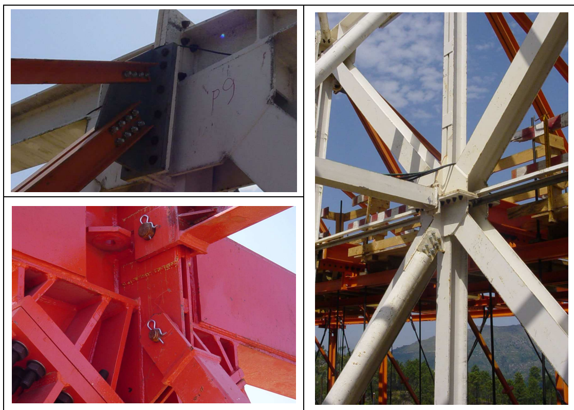
Figura II.34 – Ligações entre elementos de contraventamento e treliças principais; ligações aparafusadas e por encaixe com cavilhas de travamento.
