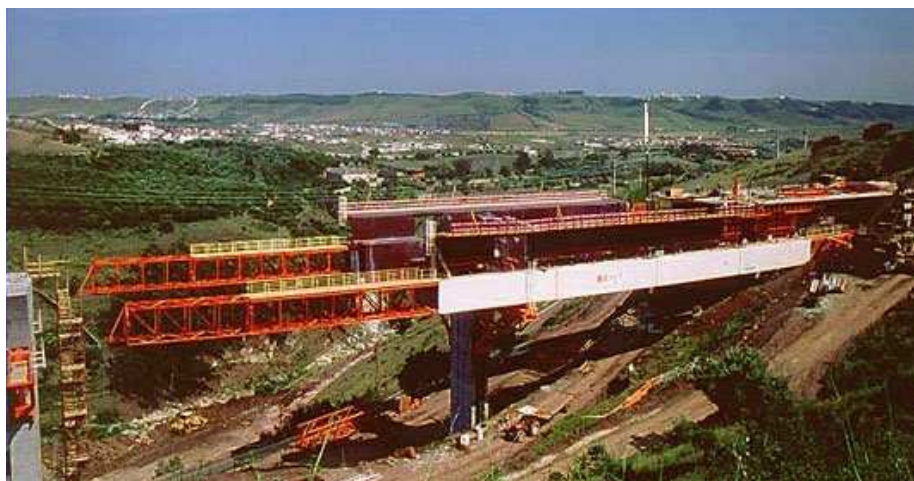
Figura II.12 – CA inferior – Execução de viaduto na A9 (CREL) – cortesia NRS
