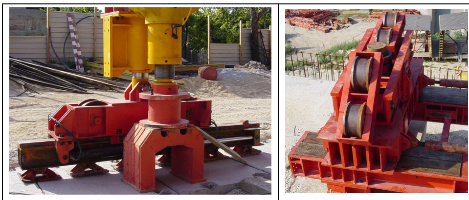
Figura II.23 – Sistema de movimentação do cembre. Apoio traseiro com sistema hidráulico de empurre e “bogies” (esquerda), e apoio dianteiro com “bogies” (direita) – cortesia Mota-Engil
