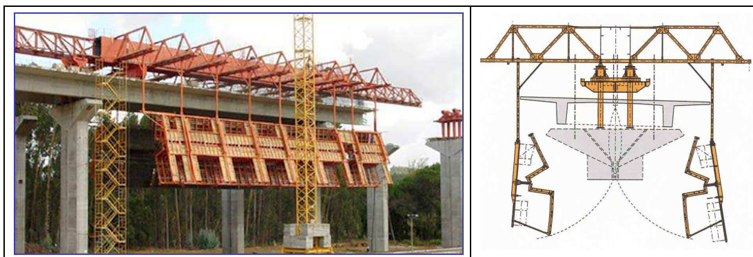
Figura II.17 – CA Superior com estrutura em caixão de almas cheias com cofragens totalmente abertas e preparado para avançar . Perspectiva geral (à esquerda) e vista transversal (direita) – cortesia NRS
