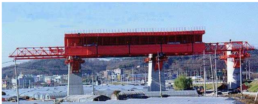
Figura II.8 – Construção com cibre autoportante e autolançável – cortesia NRS.
