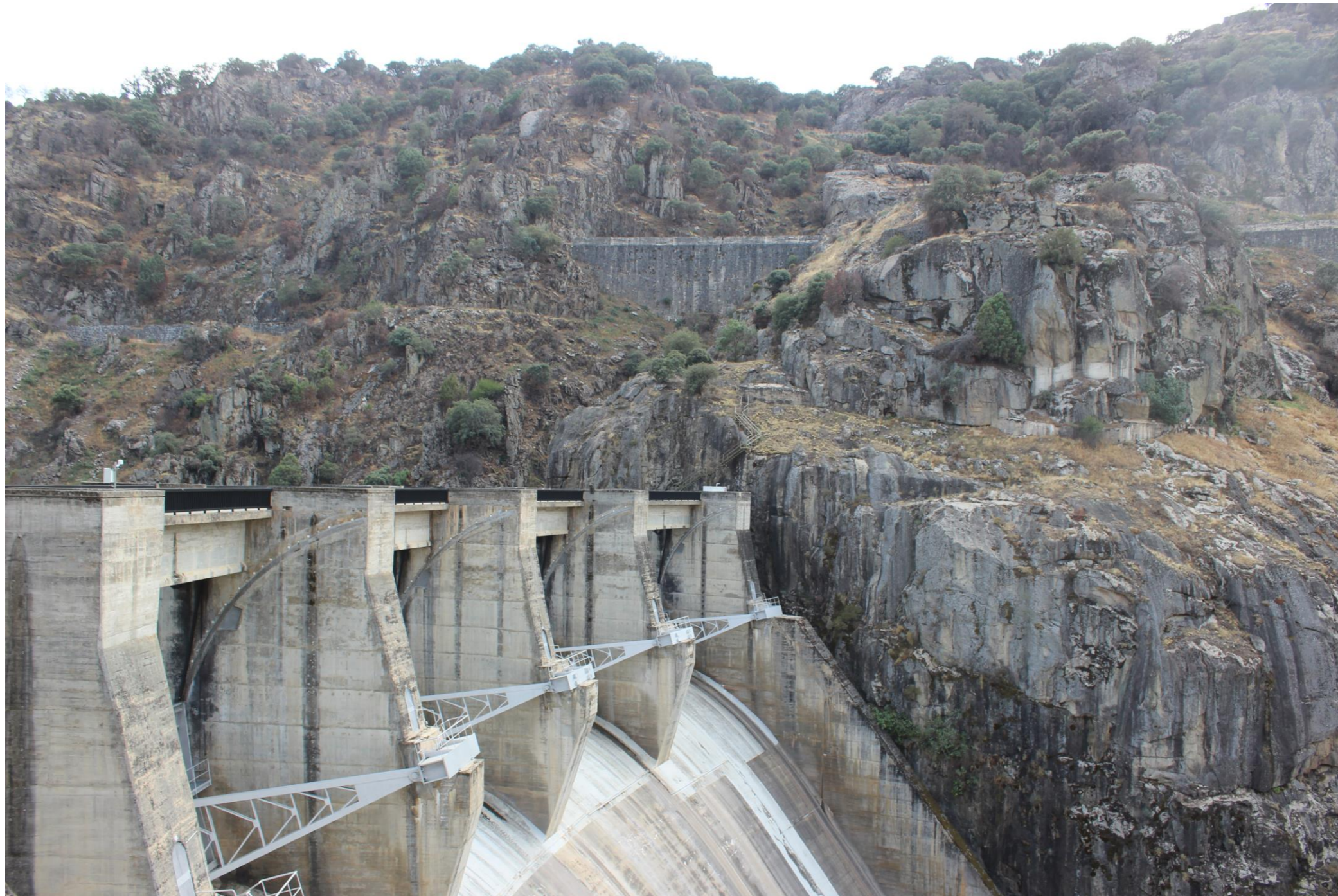
Fig.3– A barragem do Picote. Agosto de 2018. Fotografia da Autora
