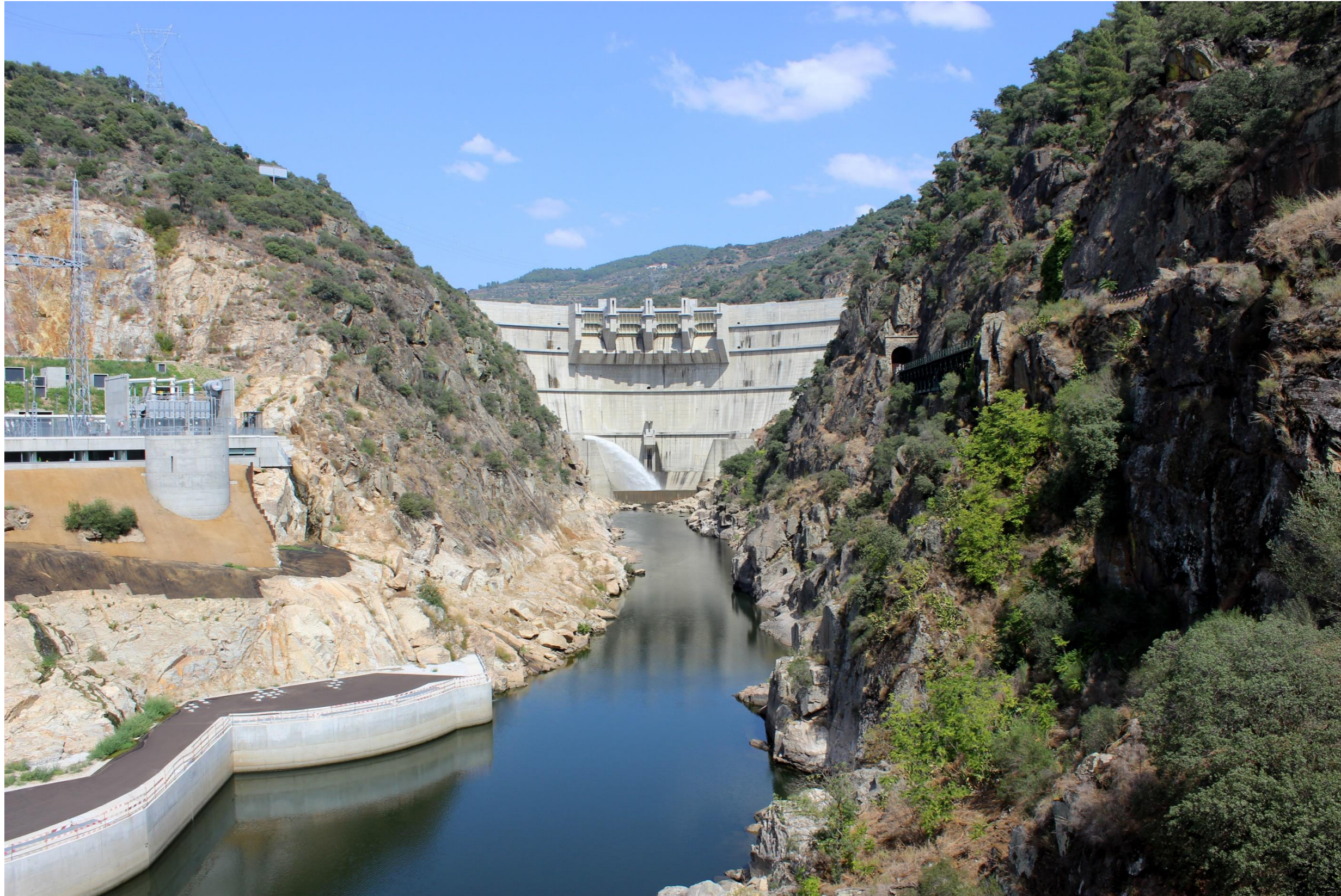
Fig.2 – Barragem de Foz Tua entre as falésias. Agosto de 2018. Fotografia da Autora
