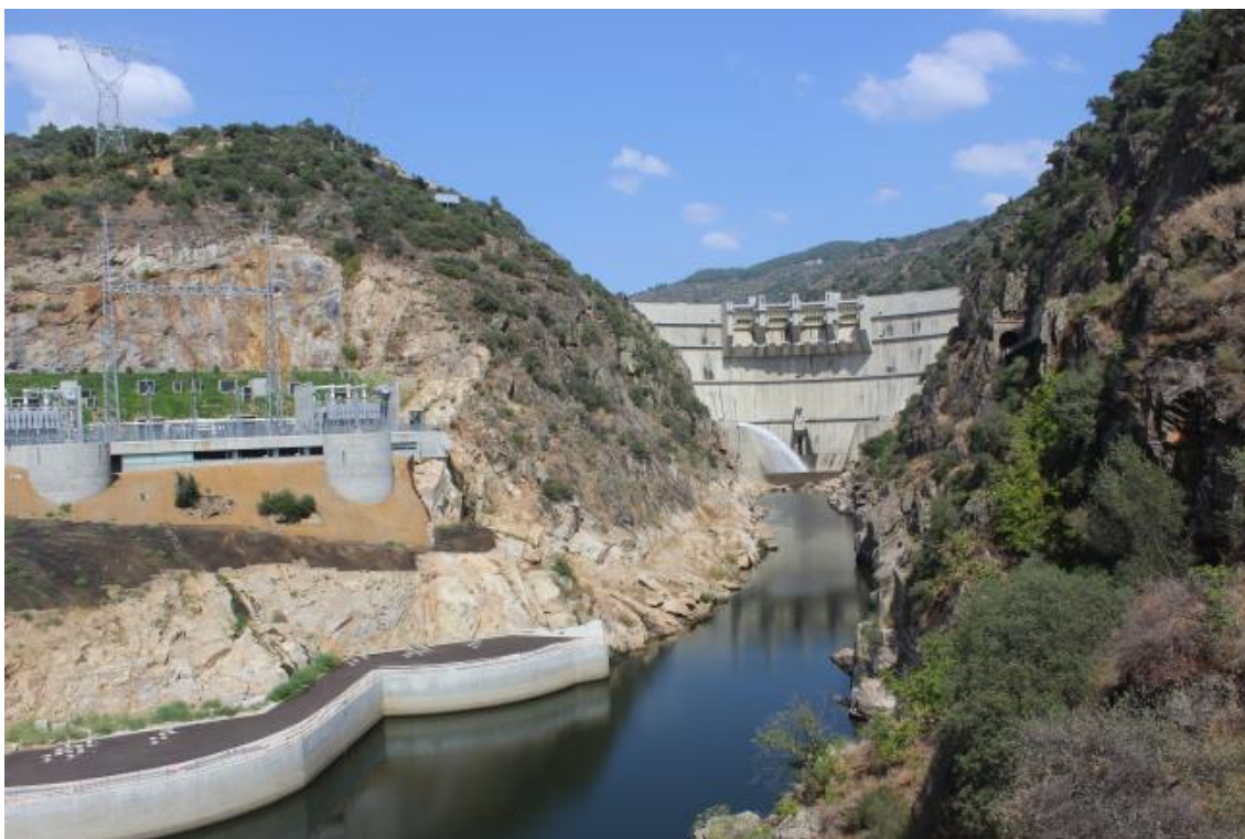
Fig.34- Barragem e Central de Foz Tua. Fotografia da autora.
