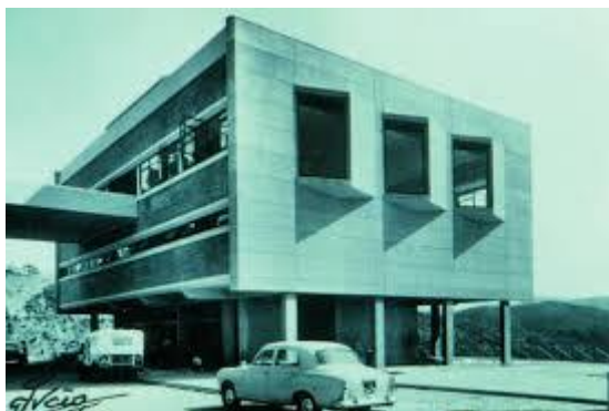
Fig.20 - Edifício de Comando de Bemposta – 1960. Foto de época – Alvão.
