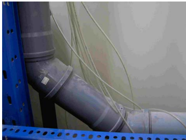
Figura 2.8 - Curva de mudança de direcção usada.
