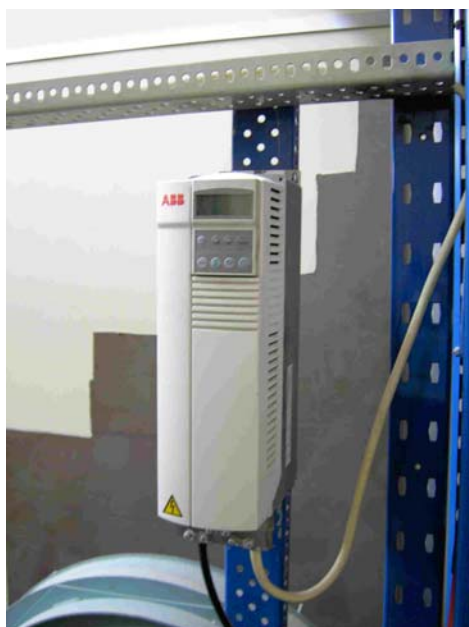
Figura 2.3 - Variador de frequência usado (ABB- modelo ACS401000932).
