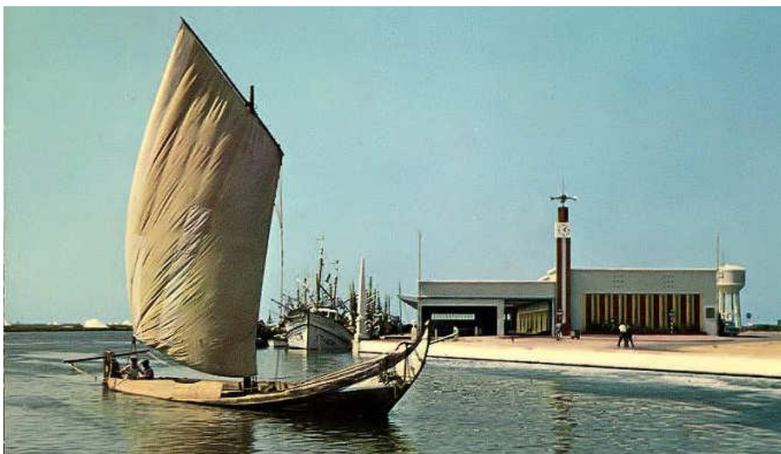
Fig. 65 | Foto do Moliceiro no Canal das Pirâmides, junto ao edifício da Antiga Lota Pesqueira.
