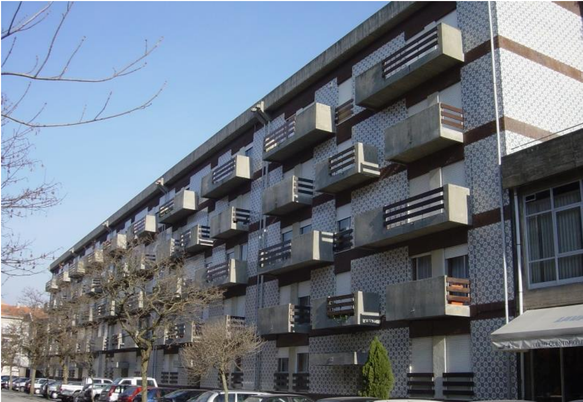
Fig. 8 | Edifício tipo, zona de Habitação Carramona.
