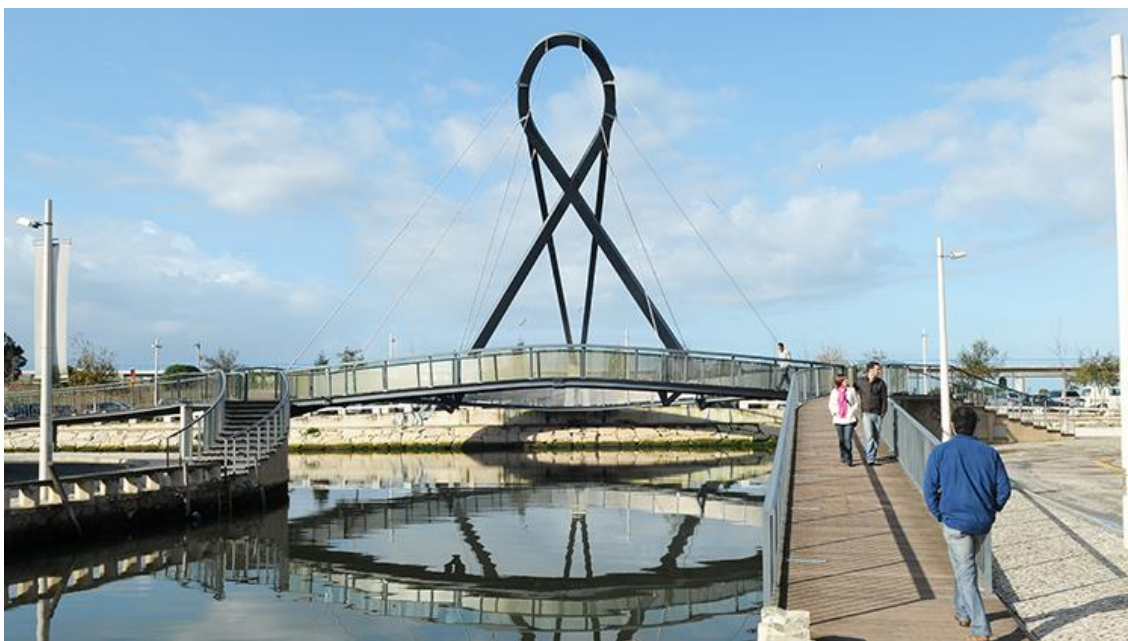
Fig. 17 | Ponte dos Botirões, Arquiteto Luís Viegas.
