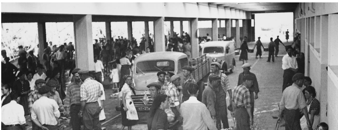
Fig. 73 | Imagem de corredor situado entre a zona descarga do peixe o edifício da Lota
