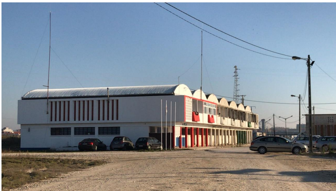
Fig. 74 | Edifício Armazém de Redes.
