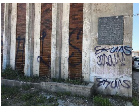
Fig. 78 | Canteiro fachada lateral Lota.
