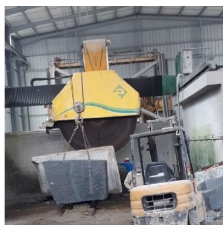
Colaborador ajusta a colocação manualmente
