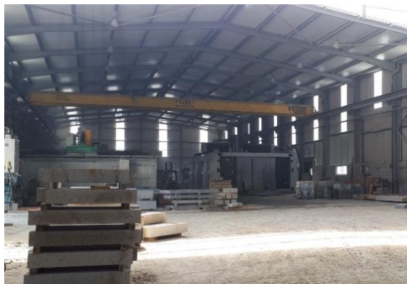
Figura 52 – Ponte rolante (Fonte: autor)
