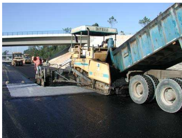
Figura 4.109 – Aplicação da mistura com reciclagem a quente
