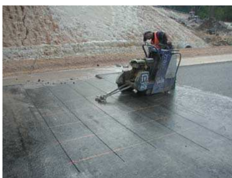
Figura 4.110 – Corte das placas da camada executada com misturas com reciclagem
