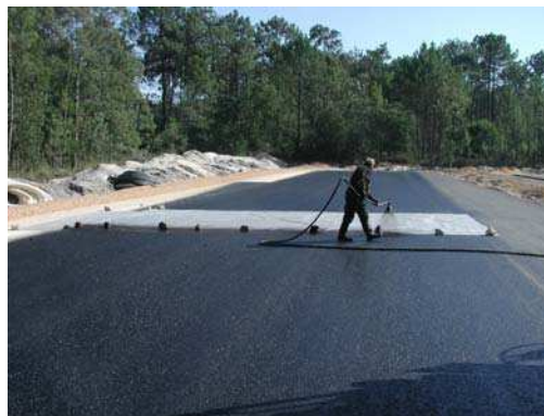
Figura 4.108 – Aplicação do geotextil
