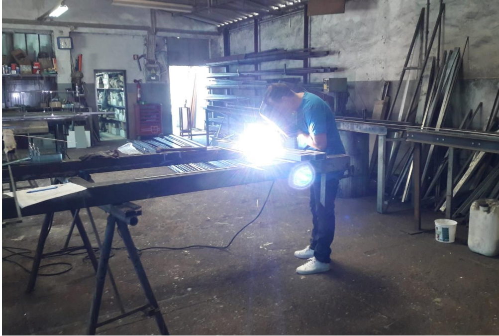
Figura 4.30 - Soldagem da estrutura.
