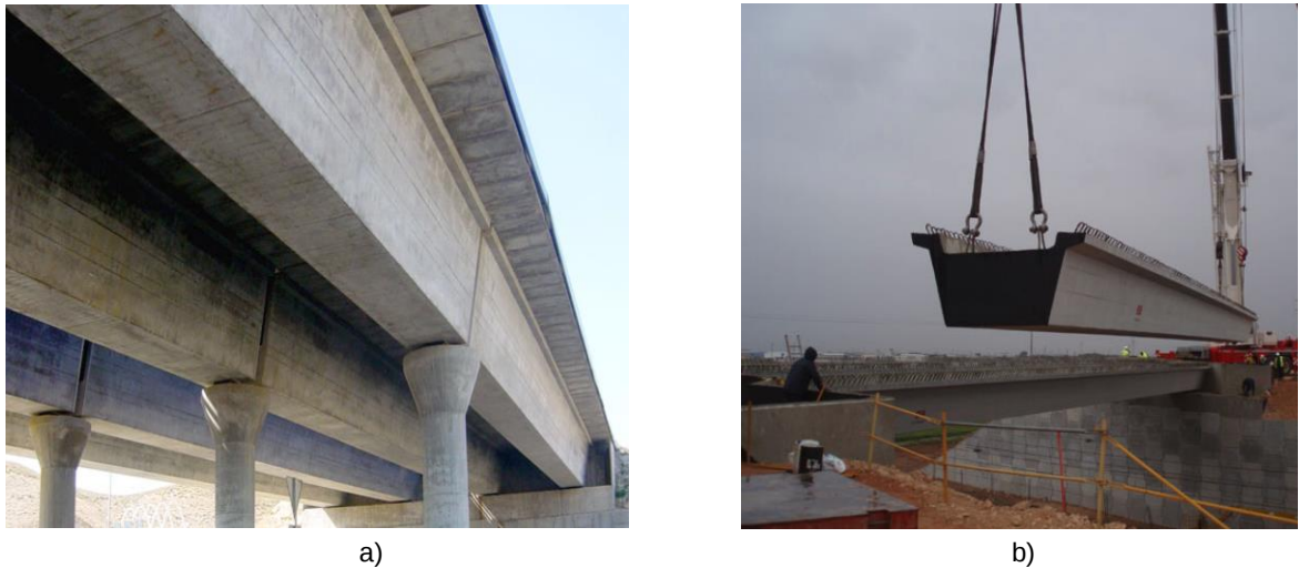
Figura 5.2 – a) Apoios das vigas e carlinga, b) extremidade de uma viga Artesa.
