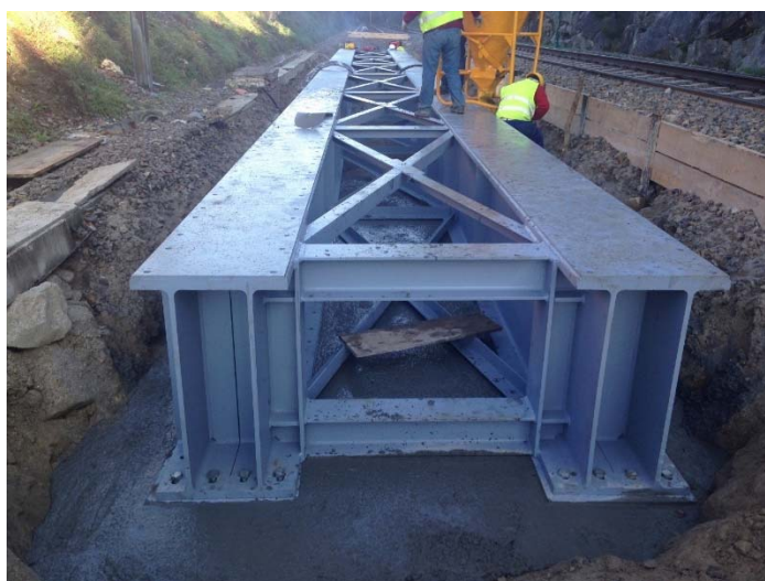
Fig. 163 – Suspensão de via férrea executada (Félix, J.)
