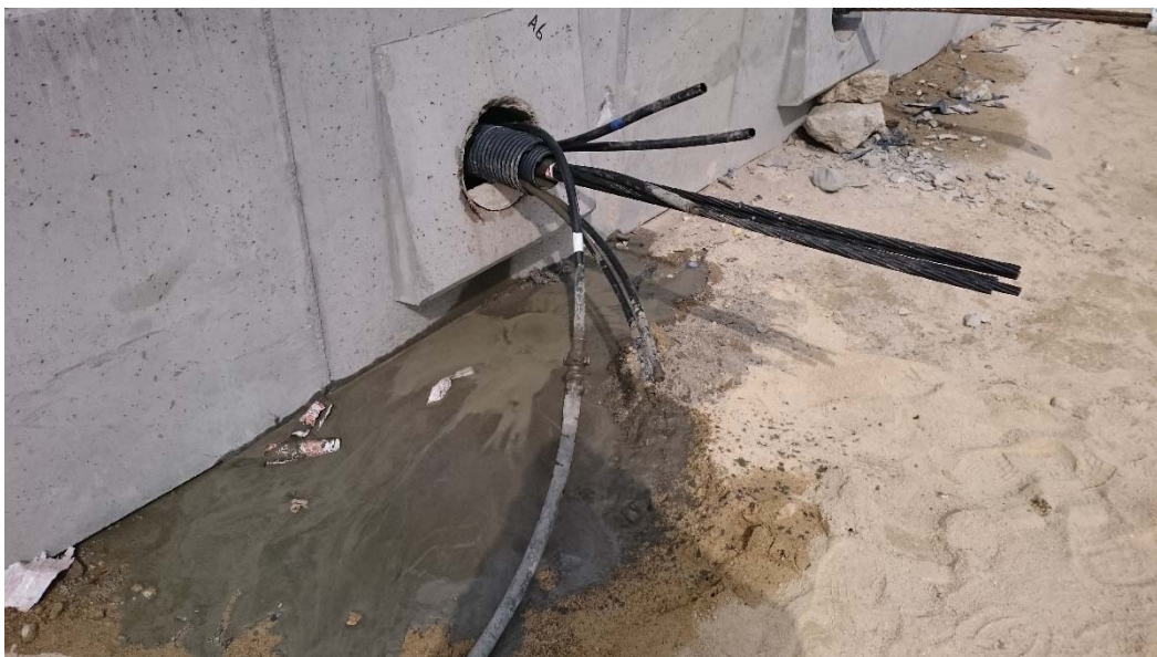
Fig. 187 – Injeção das ancoragens (TAS 23/03/2016)
