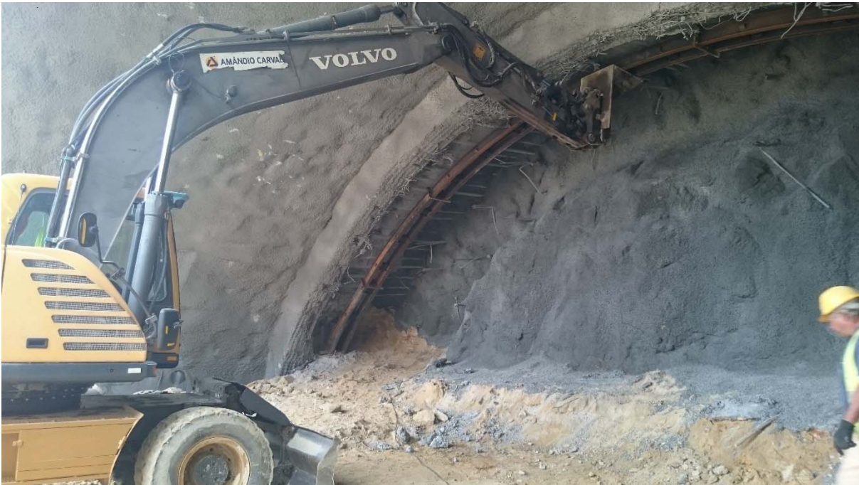
Fig. 196 – Fase 2 – escavação da calote superior em ZG3emb – colocação da 1ª cambota (TAS 21/09/2016)
