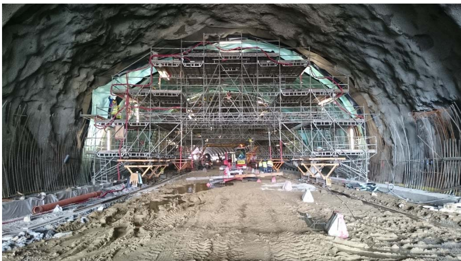
Fig. 222 – Colocação do sistema de impermeabilização (TAS 22/02/2017)
