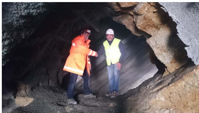
Fig. 235 – Abertura da passagem entre a frente poente e nascente (TAS 13/12/2016)
