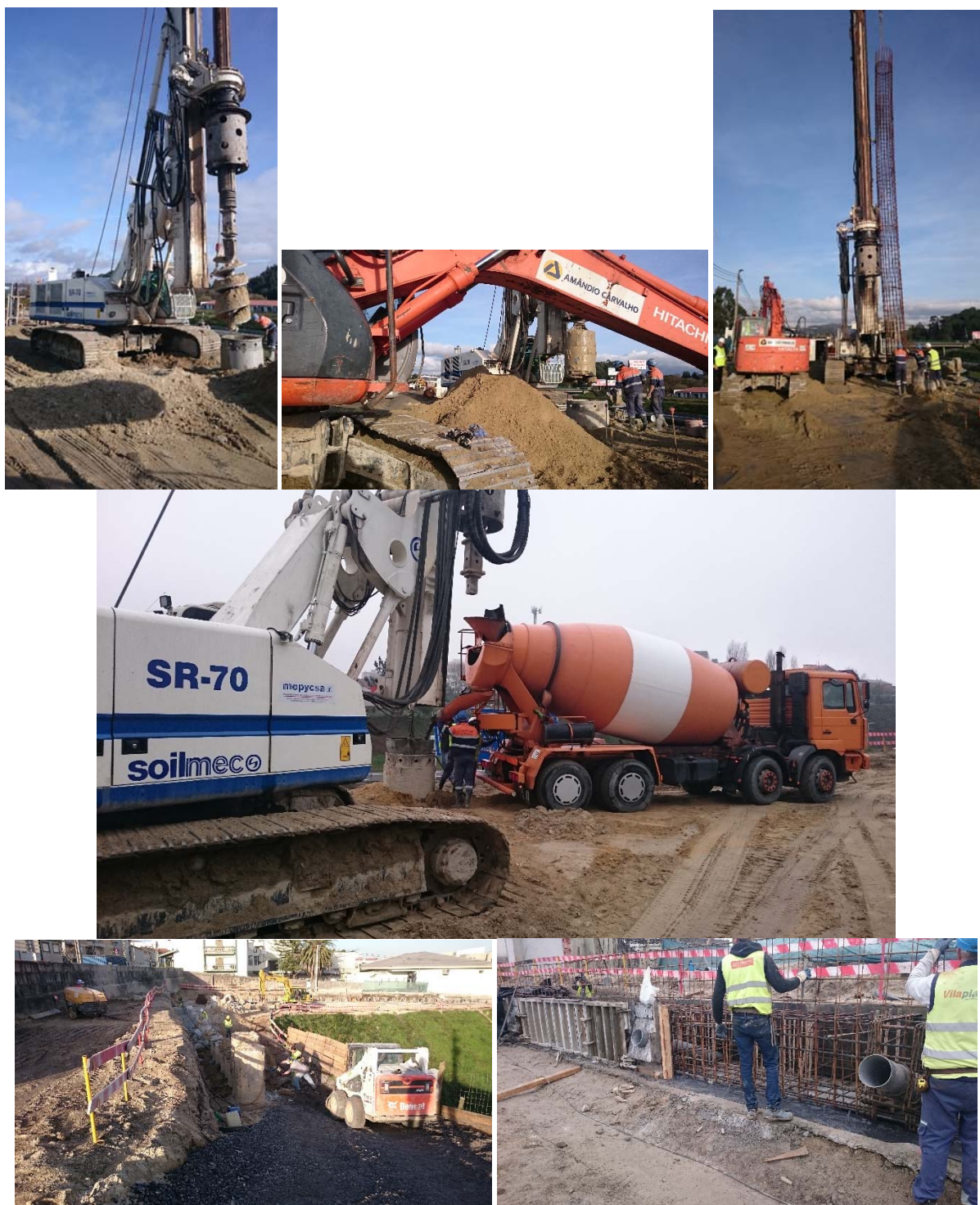
Fig. 181 – Execução de estacas no TAS
