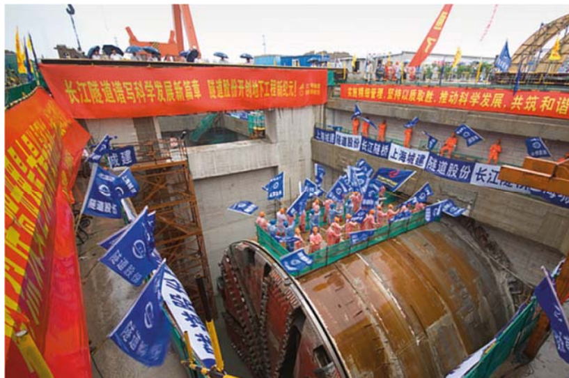
Fig. 123 – Mixshield TBM do túnel rodoviário de Shanghai sobre o rio Yangtze (www.herrenknecht.com, 2018)
