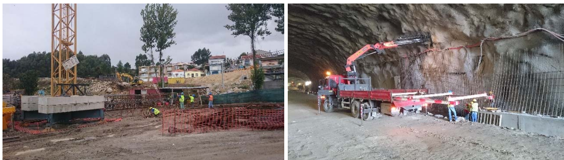
Fig. 219 – Montagem e transporte das armaduras (TAS)
