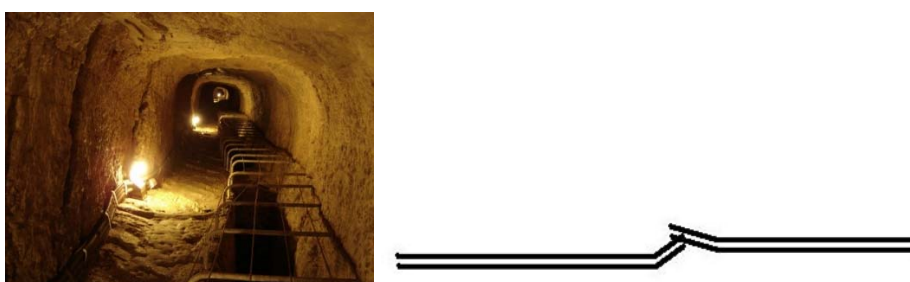
Fig. 2 – Aqueduto de Eupalinos em Samos, Grécia
