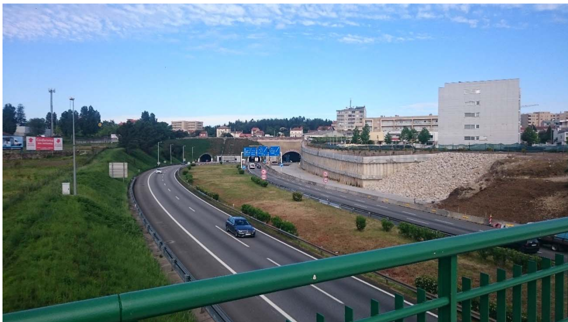
Fig. 240 – Portal nascente do túnel com obra concluída (TAS 17/05/2017)
