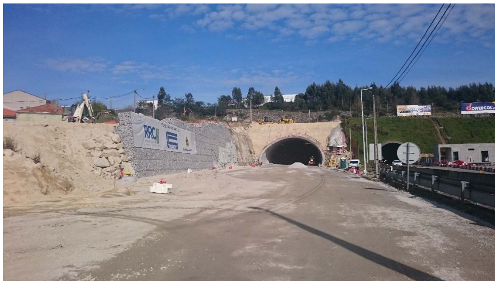
Fig. 168 – Muro de gabiões e aterro final sobre o falso túnel poente (29/03/2017)
