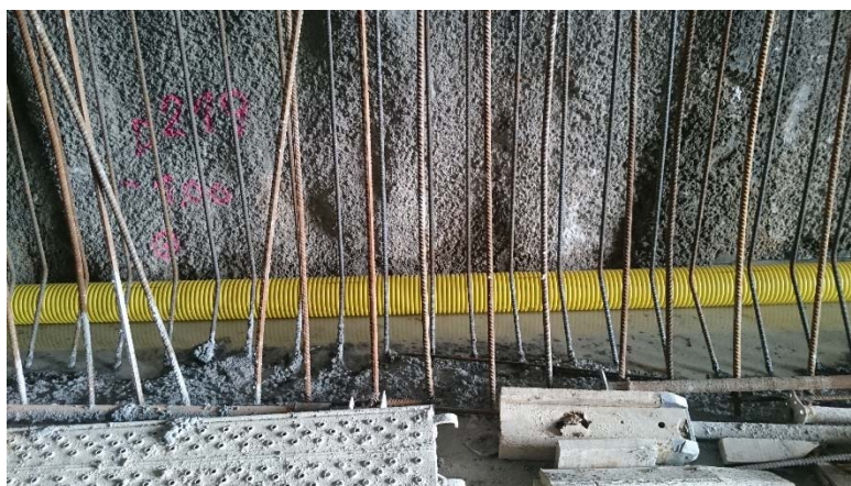
Fig. 223 – Colocação do dreno (TAS 22/02/2017)
