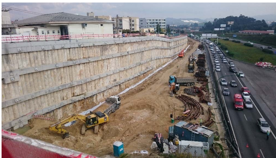
Fig. 239 – Ancoragens de substituição 89ª e 195ª (à esquerda) (TAS 20/10/2016)
