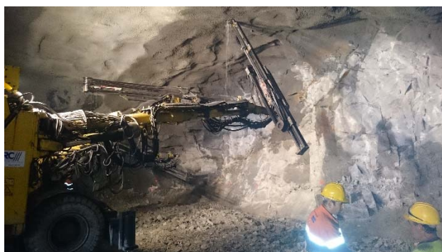
Fig. 89 – Furação com Jumbo para execução de pregagem
