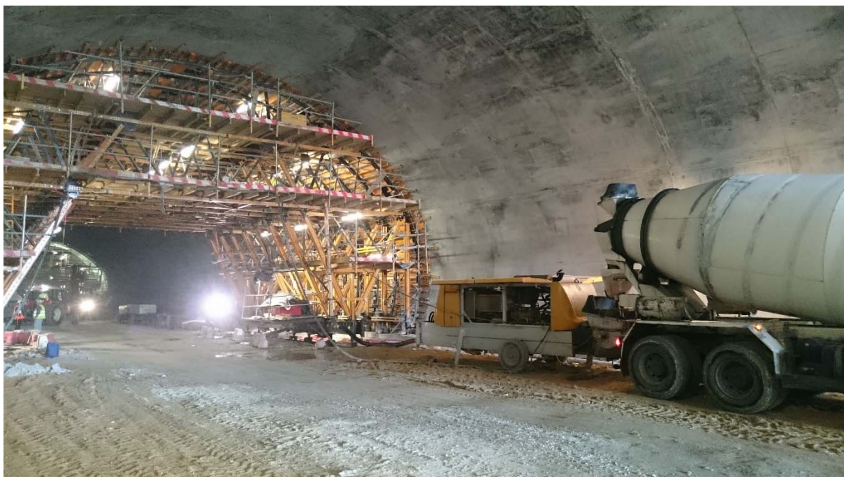
Fig. 129 – Execução do arco em betão (TAS)
