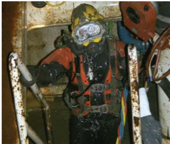
Fig. 117 – Operário equipado com equipamento de mergulho para efetuar manutenção na cabeça de corte de uma Mixshiled TBM (Nôro, 2014)
