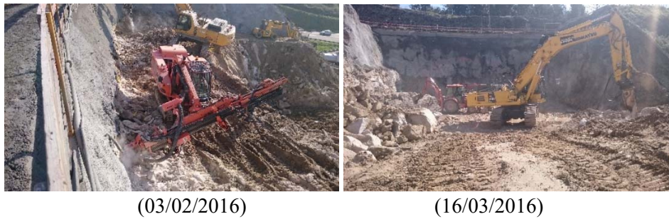
Fig. 165 – Escavação do talude poente junto ao emboquilhamento
