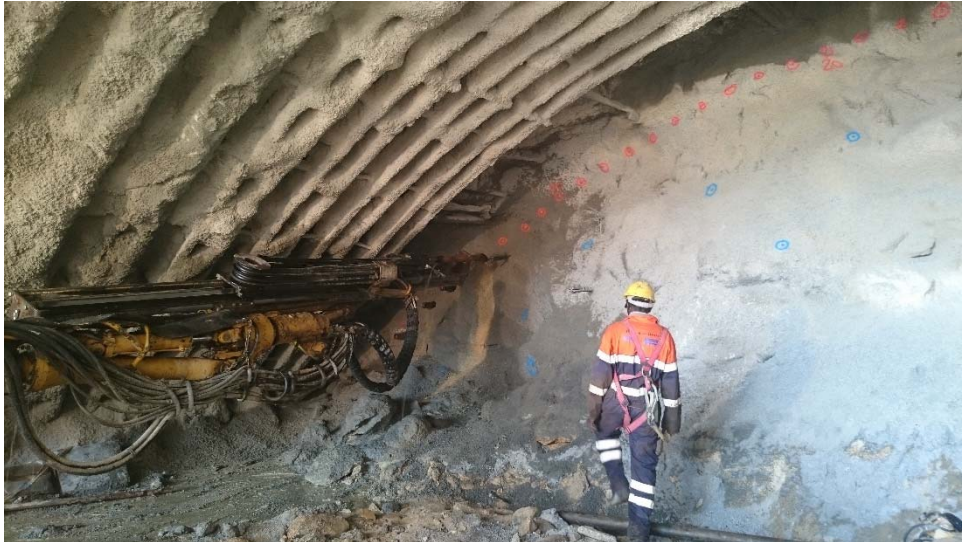
Fig. 198 – Fase 3 – escavação 36 m da calote superior em ZG3emb – enfilagens do 2º avanço 9 m (TAS 06/10/2016)
