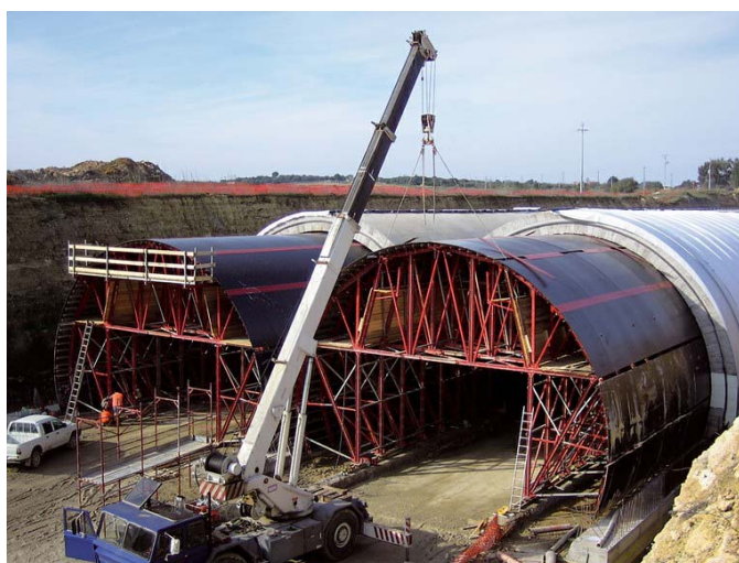
Fig. 29 – Exemplo de túnel a céu aberto ou falso túnel, Estrada Catania-Siracusa ( www.ulmaconstruction.pt , 2018)
