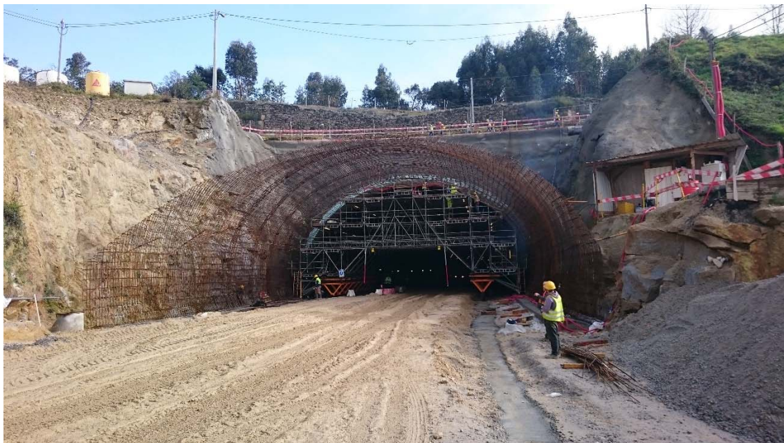
Fig. 231 – Carro de andaimes sobre carris para montagem das armaduras no falso túnel poente (TAS 04/01/2017)
