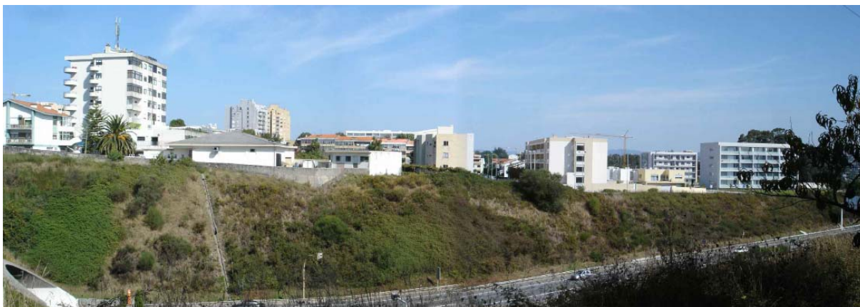
Fig. 155 – Emboquilhamento nascente – Talude de escavação (situação inicial)
