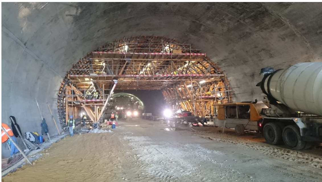
Fig. 234 – Betonagem do 7º tramo de 12 m (TAS 01/02/2017)
