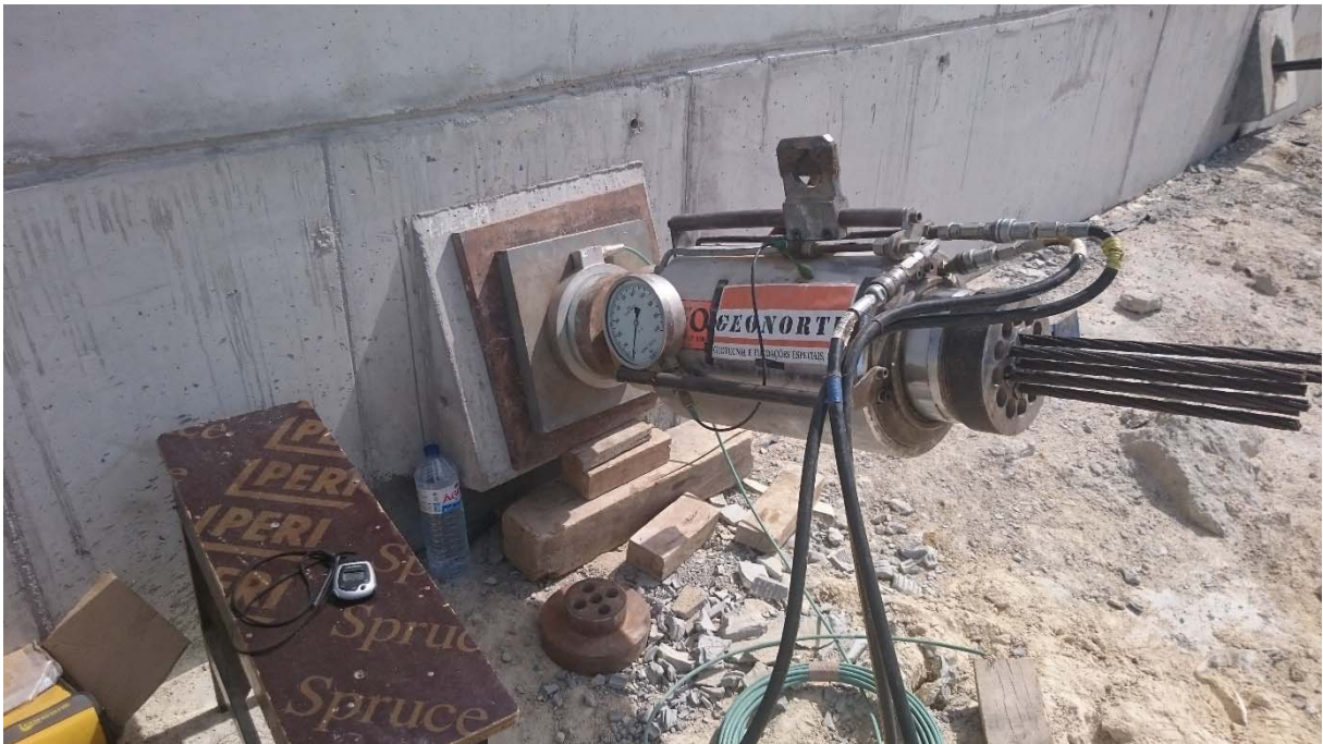
Fig. 188 – Aplicação de pré-esforço com macaco hidráulico nas ancoragens (TAS 04/05/2016)
