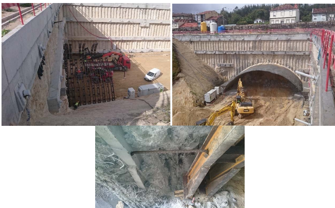
Fig. 86 – Cambotas com perfis metálicos IPN para execução de falso túnel (TAS)
