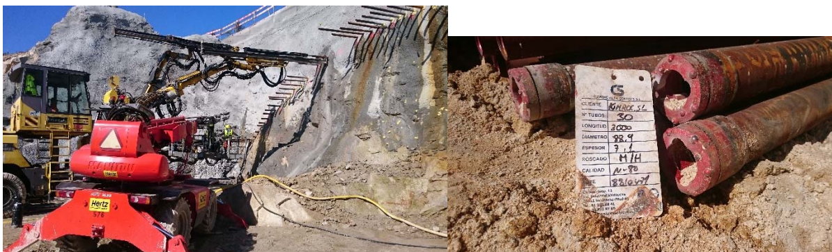
Fig. 78 – Furação e colocação de enfilagens (TAS)
