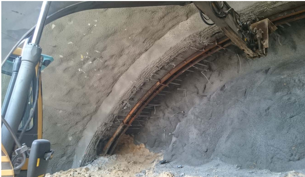
Fig. 80 – Frente de avanço com pregagem de PRFV e betão projetado e na face (TAS)
