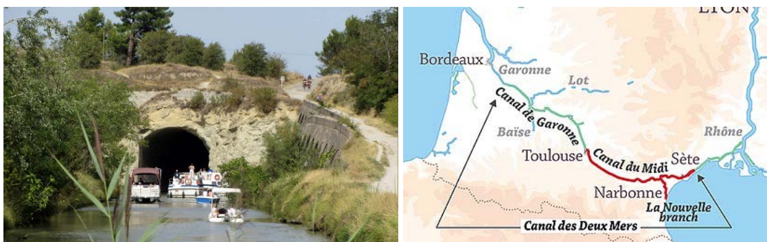
Fig. 4 – Túnel no Canal du Midi (wikipedia, 2018)
