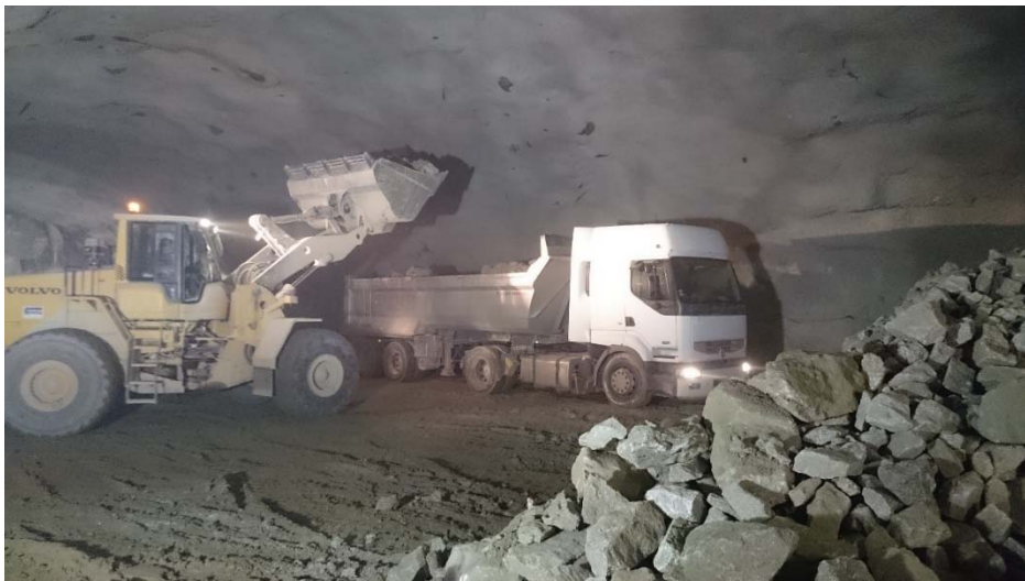
Fig. 72 – Carga e transporte de escombros com pá e camião (TAS)
