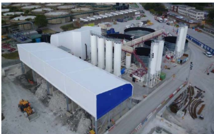
Fig. 112 – Estação de tratamento de lamas da SFM construída para escavar o Túnel “Water Lee” sob o rio Tamisa para o projecto “Crossrail”, Londres, Reino Unido (Nôro, 2014)
