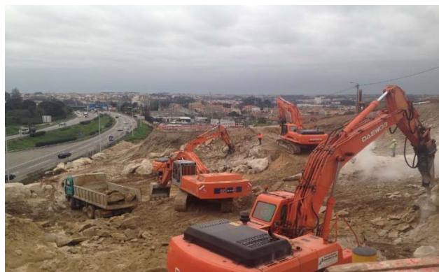
Fig. 164 – Escavação do talude poente (Félix, J.)
