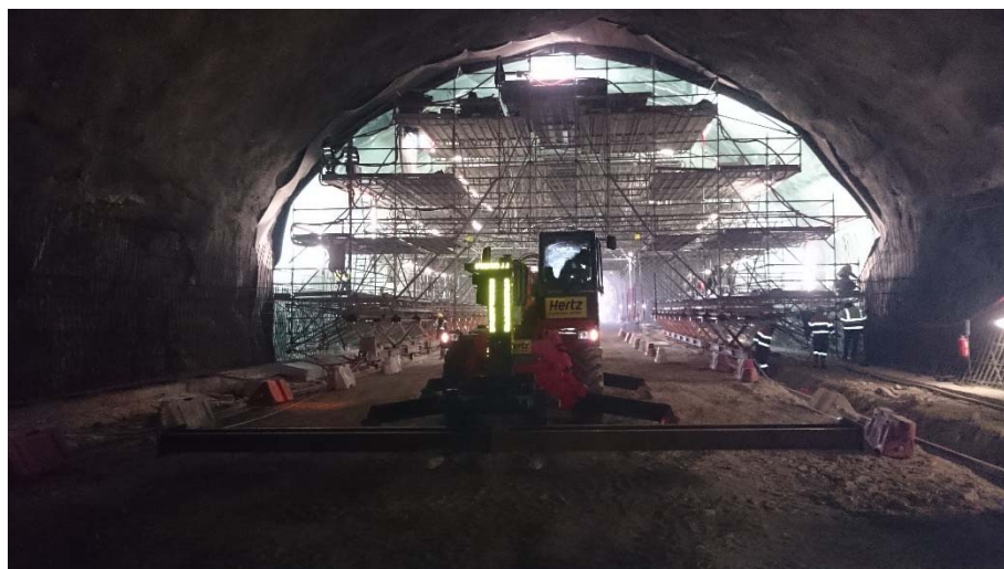
Fig. 221 – Movimentação do carro de andaimes de colocação de geotêxtil e geomembrana (TAS 25/01/2017)
