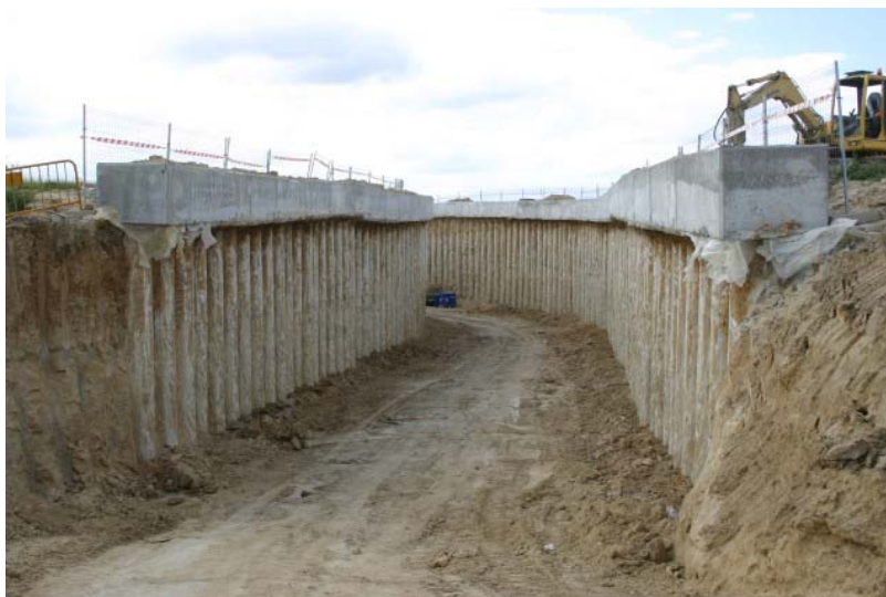
Fig. 28 – Exemplo de túnel a céu aberto ou falso túnel ( http://procedimientosconstruccion.blogs.upv.es , 2018)
