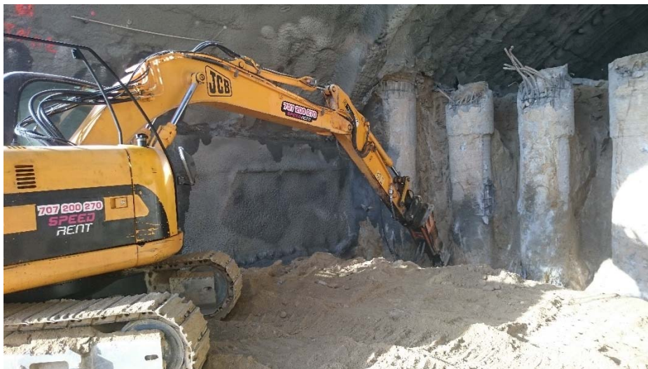
Fig. 200 – Fase 4 – demolição de estacas – escavação da calote inferior em ZG3emb (TAS 26/10/2016)
