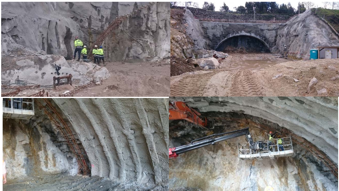
Fig. 84 – Execução de uma cambota treliçada no emboquilhamento
