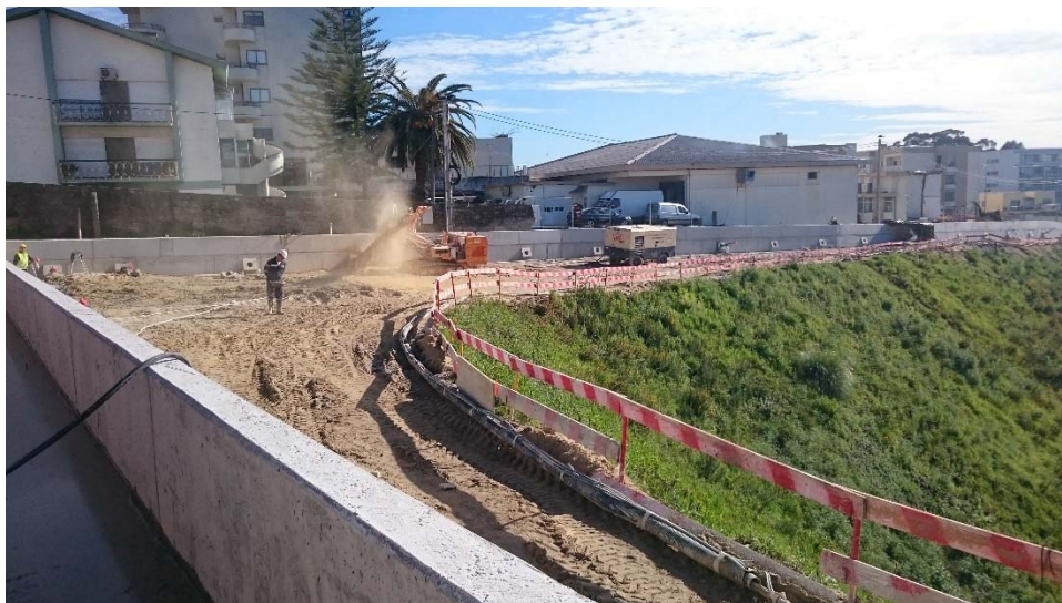
Fig. 184 – Execução da furação da ancoragem (TAS 06/04/2016)
