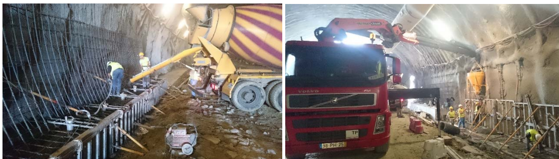
Fig. 220 – Betonagem das sapatas (TAS 10/2016)
