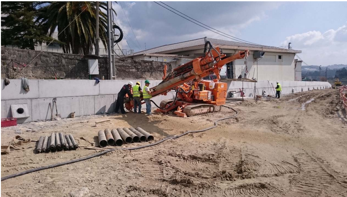
Fig. 185 – Colocação das camisas de furação nas ancoragens (TAS 23/03/2016)
