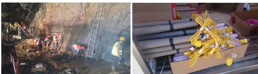
Fig. 62 – Colocação de explosivos e explosivos preparados em cana para o contorno
