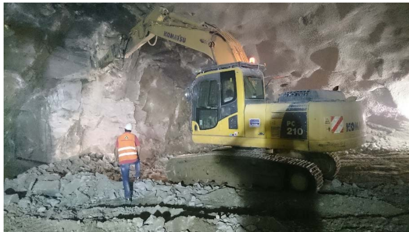
Fig. 71 – Saneamento da frente de escavação com martelo hidráulico em escavadora (TAS)
