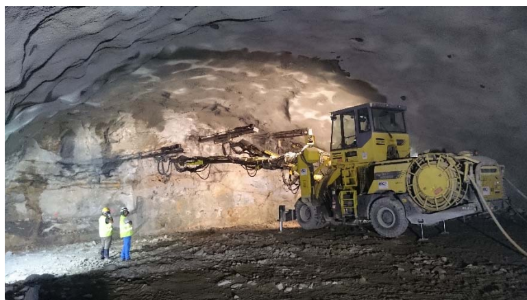
Fig. 51 – Execução dos furos com jumbo
