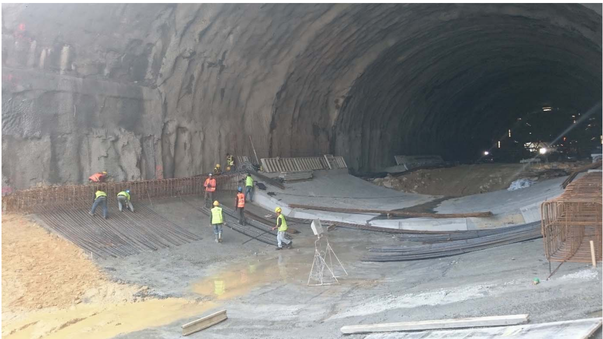
Fig. 213 – Execução do arco invertido em ZG3 (TAS 15/02/2017)
