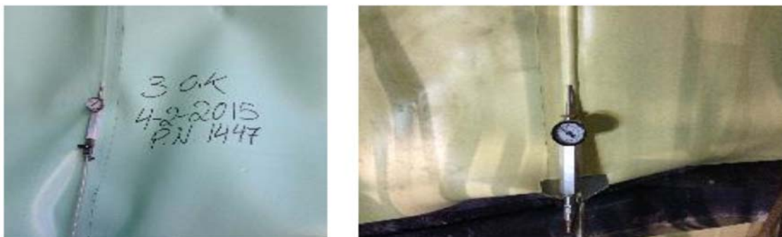
Fig. 227 – Ensaio de soldaduras duplas (Félix, J.)
