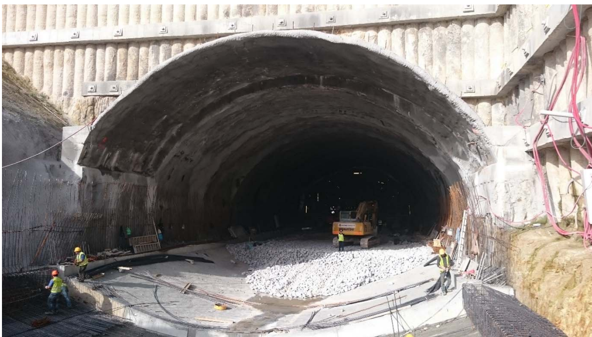
Fig. 92 – Arco invertido ou Invert (TAS)
