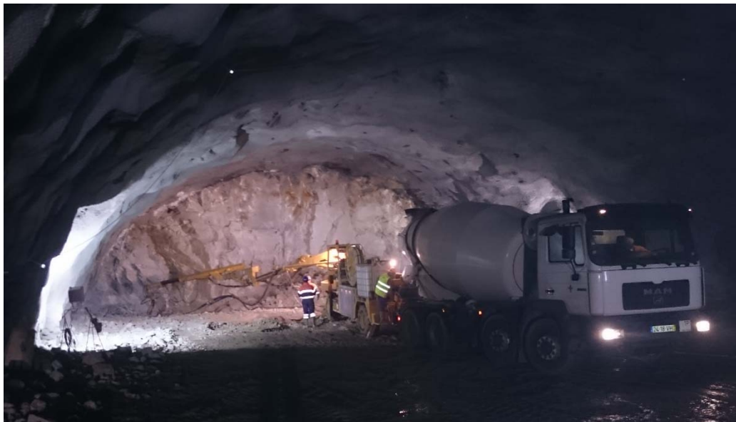
Fig. 87 – Execução de betão projetado com robot
