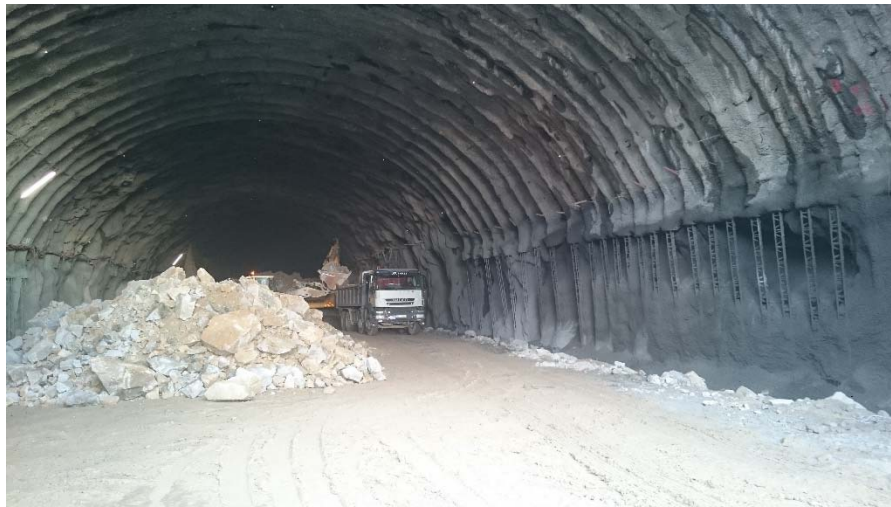
Fig. 171 – Fase 1 e fase 2 concluídas do emboquilhamento poente (15/09/2016)
