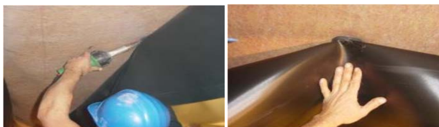
Fig. 225 – Termo soldadura da geomembrana às rondelas e aspeto da ligação entre ambas (Félix, J.)
