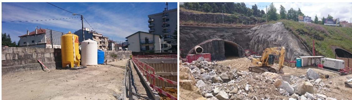
Fig. 42 – Gerador e depósitos (água e aditivos) instalado no túnel de Águas Santas
