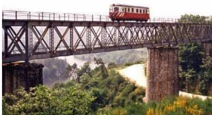
Figura 3.4 - Ponte da Baia em exploração
