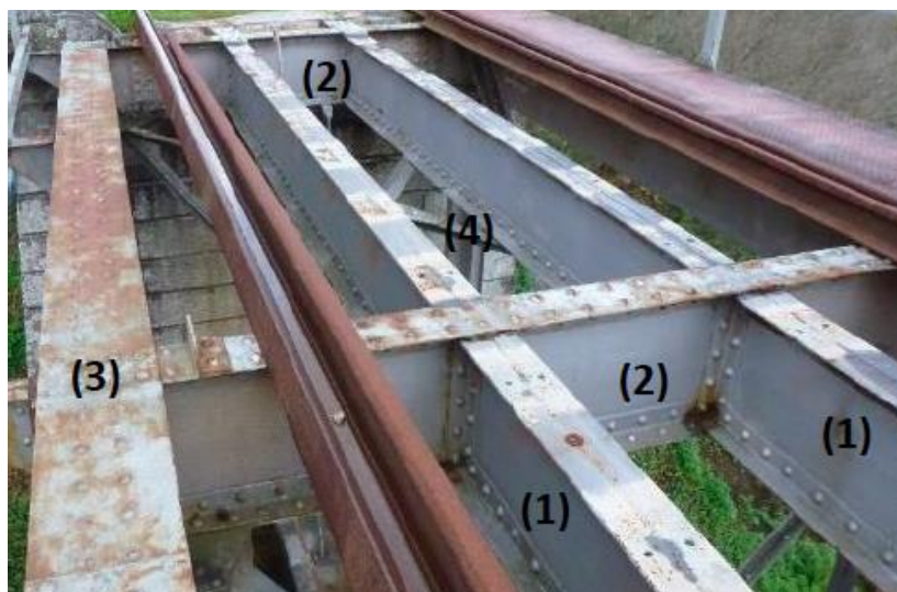
Figura 3.6 - Elementos estruturais da parte superior do tabuleiro, em que (1) longarinas, (2) carlingas, (3) corda da viga treliçada e (4) contraventamentos.
