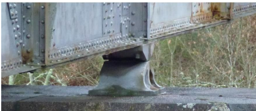
Figura 3.13 - Reforços das cordas inferiores na zona dos apoios sobre os pilares.
