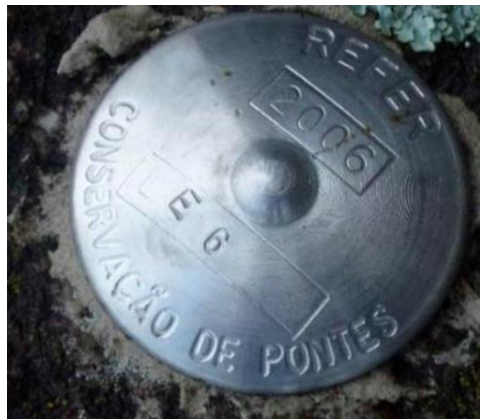
Figura 3.2 - Prova da realização da última intervenção à que foi sujeita a Ponte da Baia.
