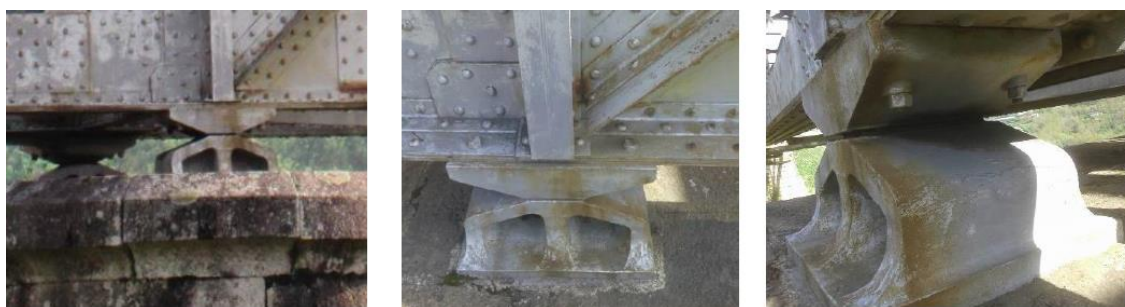
Figura 3.25 - Aparelhos de apoio duplo sobre um dos pilares de alvenaria.
