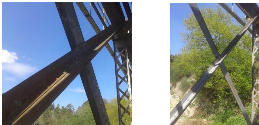
Figura 3.17 - Diagonais de contraventamento lateral.
