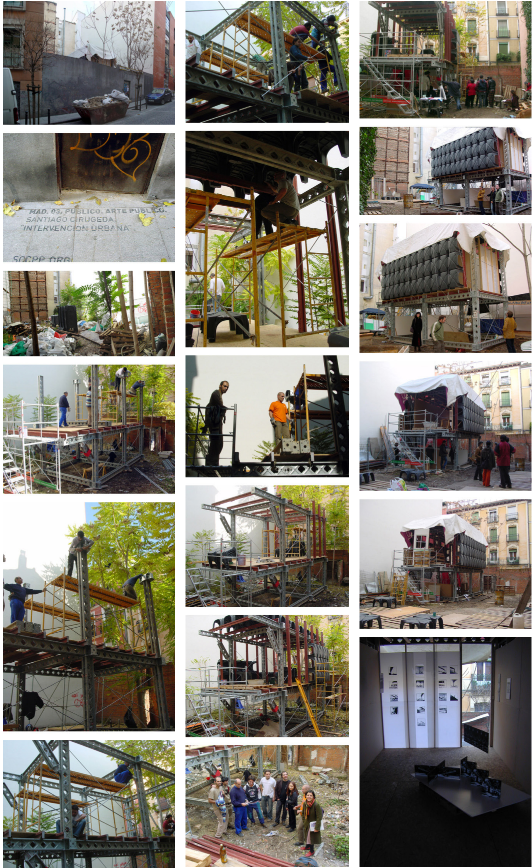
Fig.119 - Processo de montagem da unidade habitável para o festival de arte experimental MAD'03.
