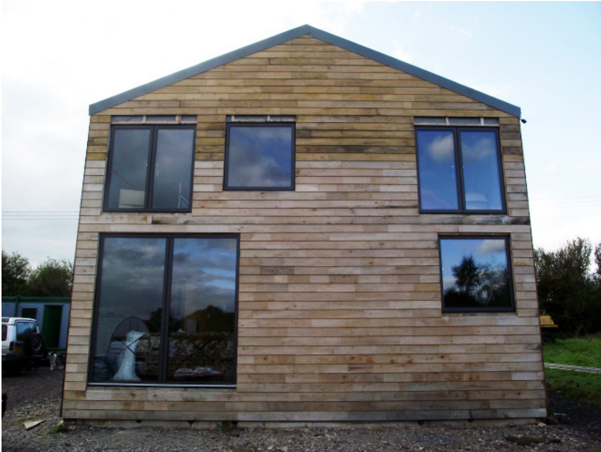
Fig.81 - A Farmhouse perto da conclusão da construção, fase de acabamentos.
