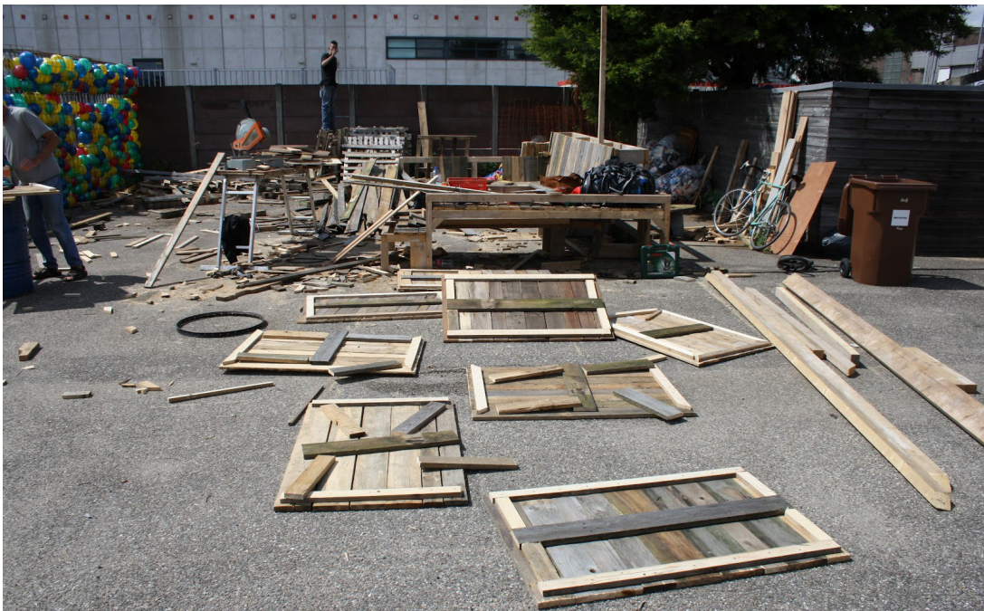
Fig.133 - Processo de corte e montagem das componentes no local onde futuramente viria a ser o Stek.
