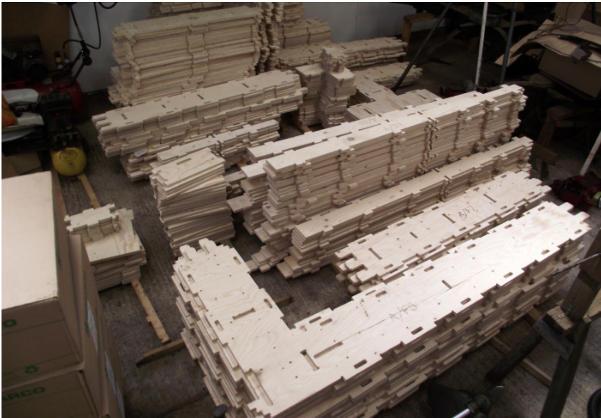
Fig.78 - Primeira remessa de componentes para a construção da Farmhouse (2016), impressas e destacadas de placas de madeira orientada. Projecto da autoria de Architecture oo e Alastair Parvin.
