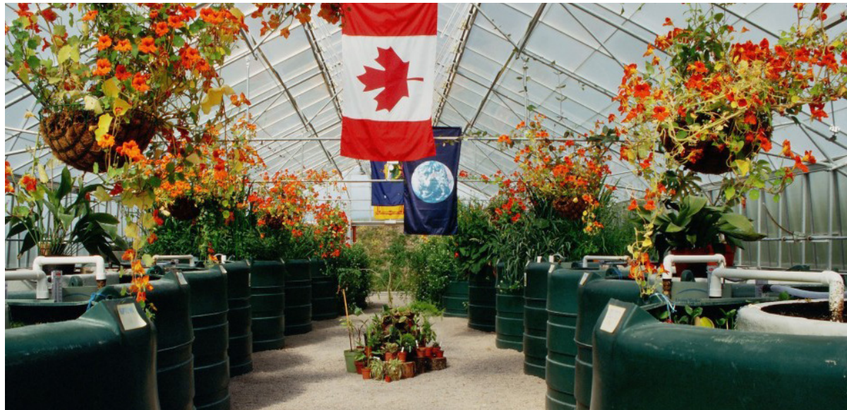
Fig.43 - Sistema de tratamento de águas residuais The Living Machine em Findhorn Community.
