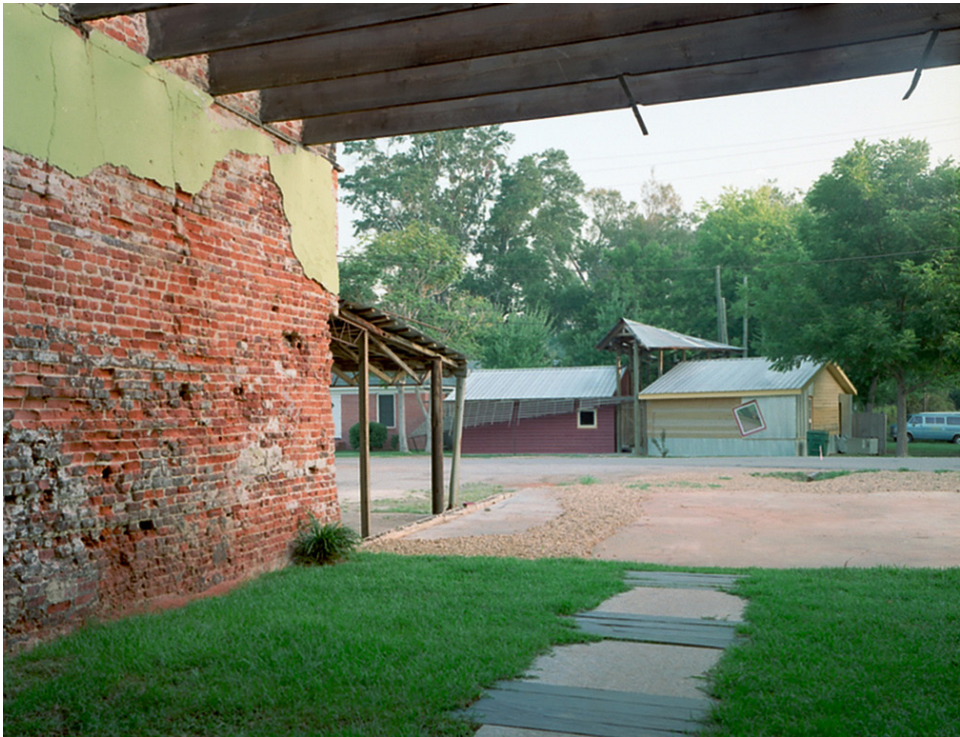
Fig.188 - Vista do pátio interior do Hero's Children Center a partir da cafeteria.
