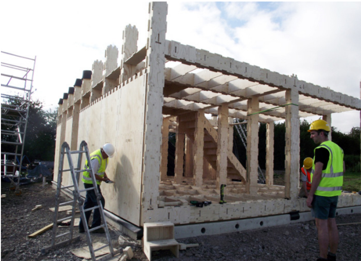
Fig.79 - Arranque da estrutura e colocação dos painéis de parede exterior.
