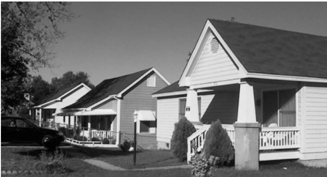
Fig.167 - Habitações relocadas e renovadas.
