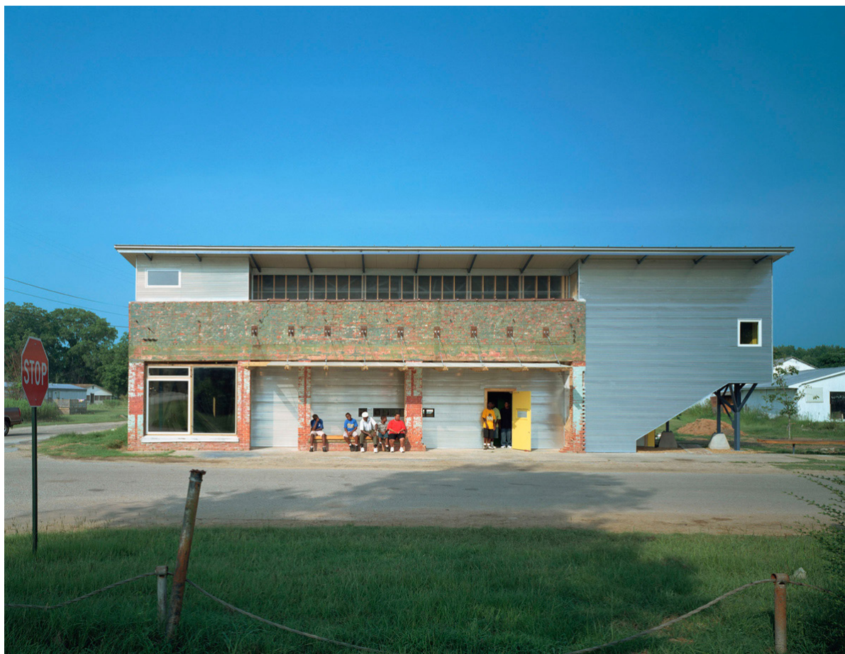
Fig.189 - Vista da fachada frontal do Akron Boys and Girls Club.
