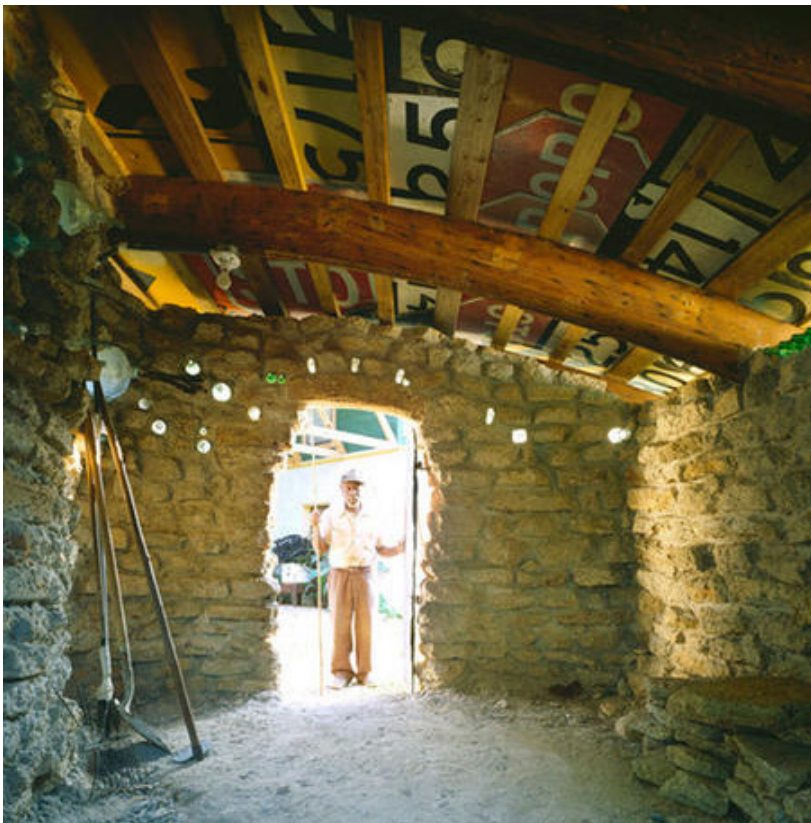
Fig.180 - Interior do fumeiro ou “Ronchamp do Alabama”.
