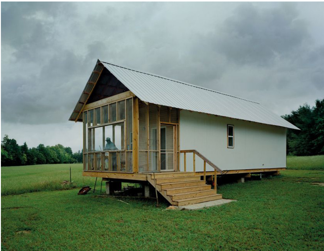
Fig.195 - 20k House construída em 2009 em Newbern.
