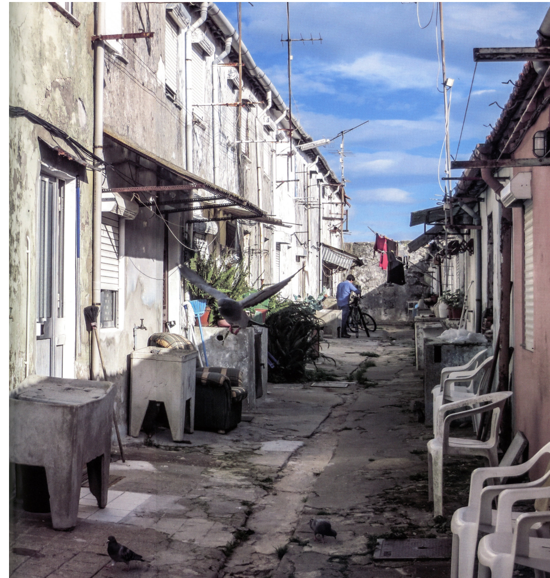
Fig. 4 - Ilha da Bela Vista, imediatamente antes da recente reabilitação iniciada pelo Laboratório de Habitação Básica (2014-2016)
