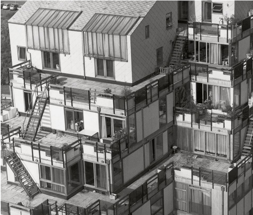
Fig.68 - Vista do bloco “administration-school” em La Mémé, onde se observa o sistema de saídas de emergência, que foi colocado após o início da construção de forma a adaptarem-se à legislação que entretanto tinha mudado. Estando no entanto harmonizado com a complexidade da arquitectura do projecto.
