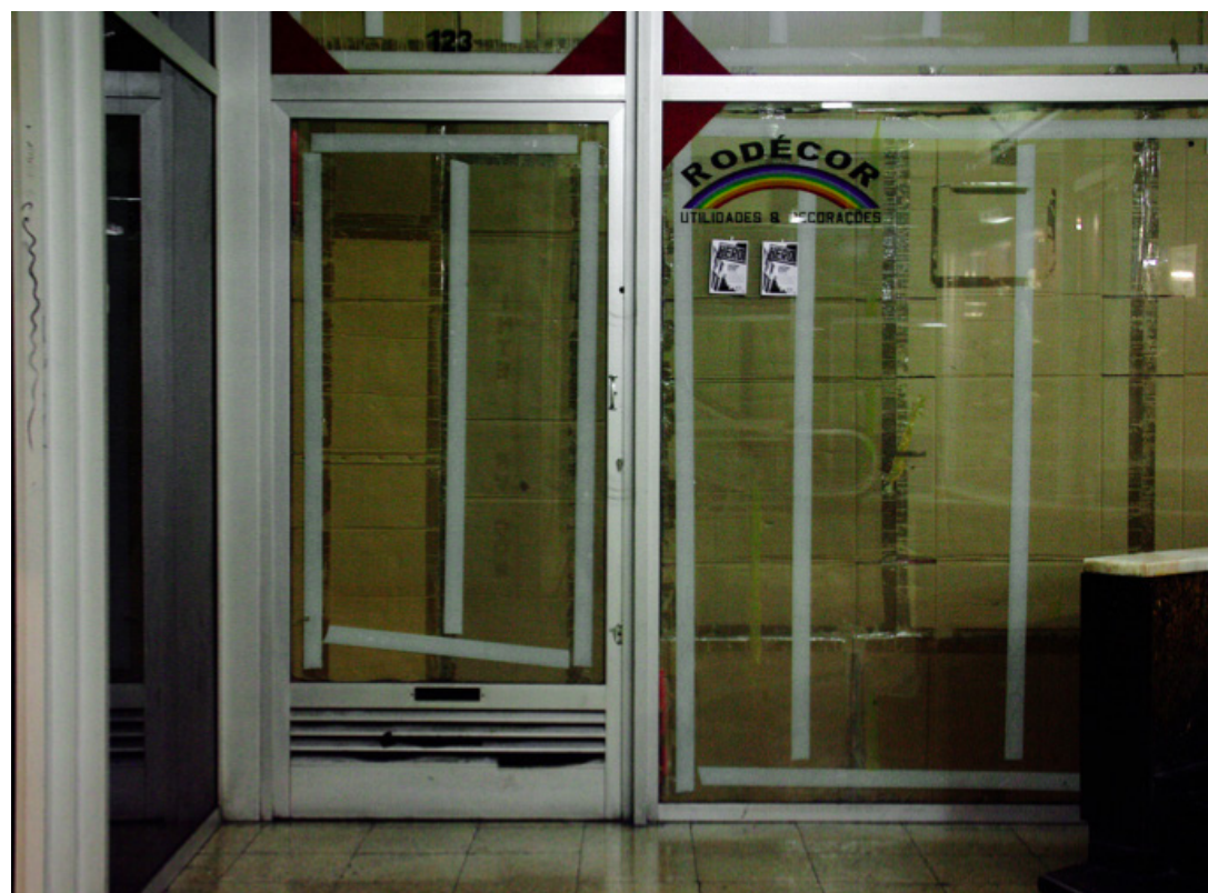
Fig. 8 e fig.9 - fachada exterior de lojas ocupadas por músicos.
