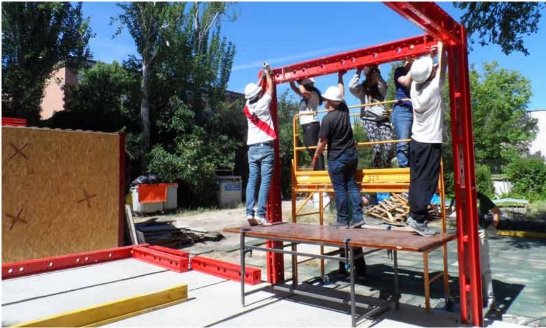
Fig.124 - Montagem da estrutura metálica.
