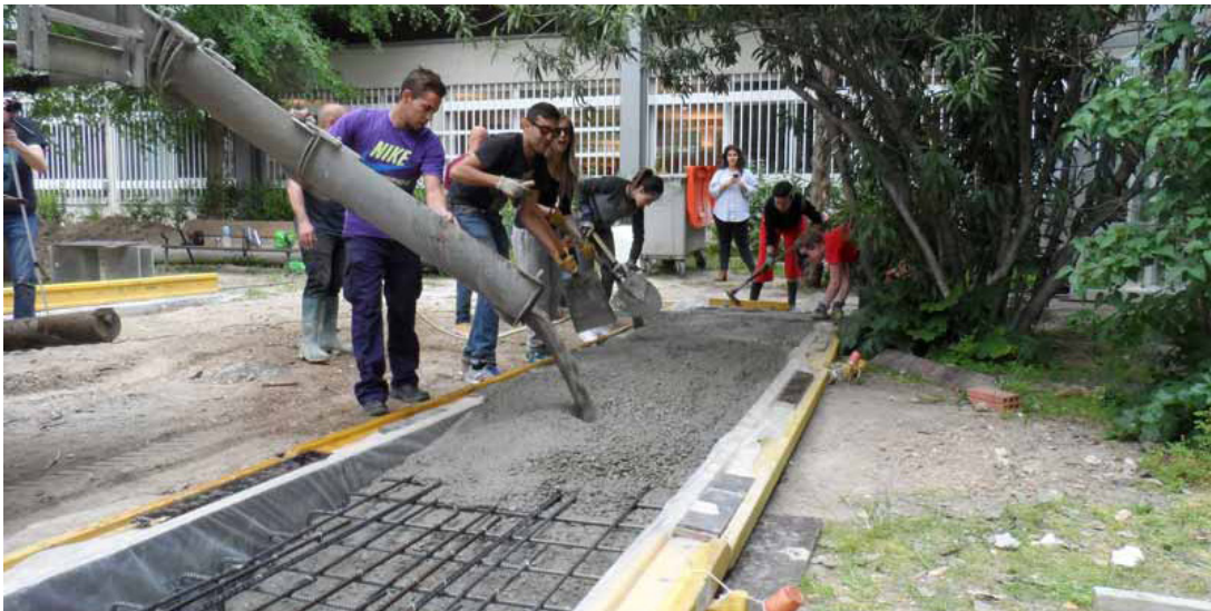
Fig.123 - Alunos a betonar uma das fundações da ampliação.
