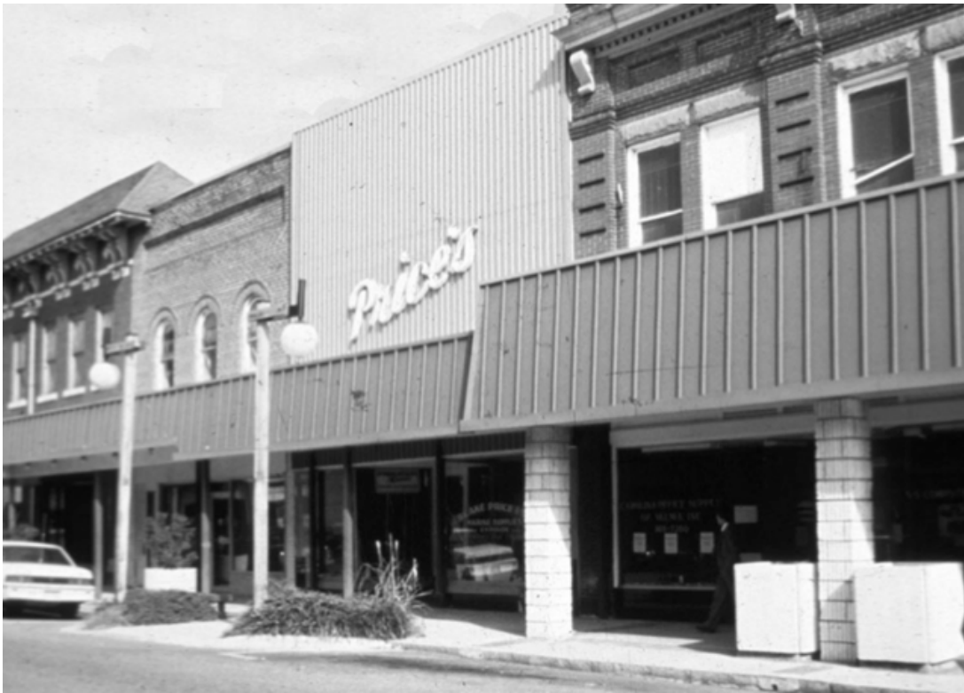
Fig.171 - Fotografia do aspecto da zona a intervir anos antes da intervenção.
