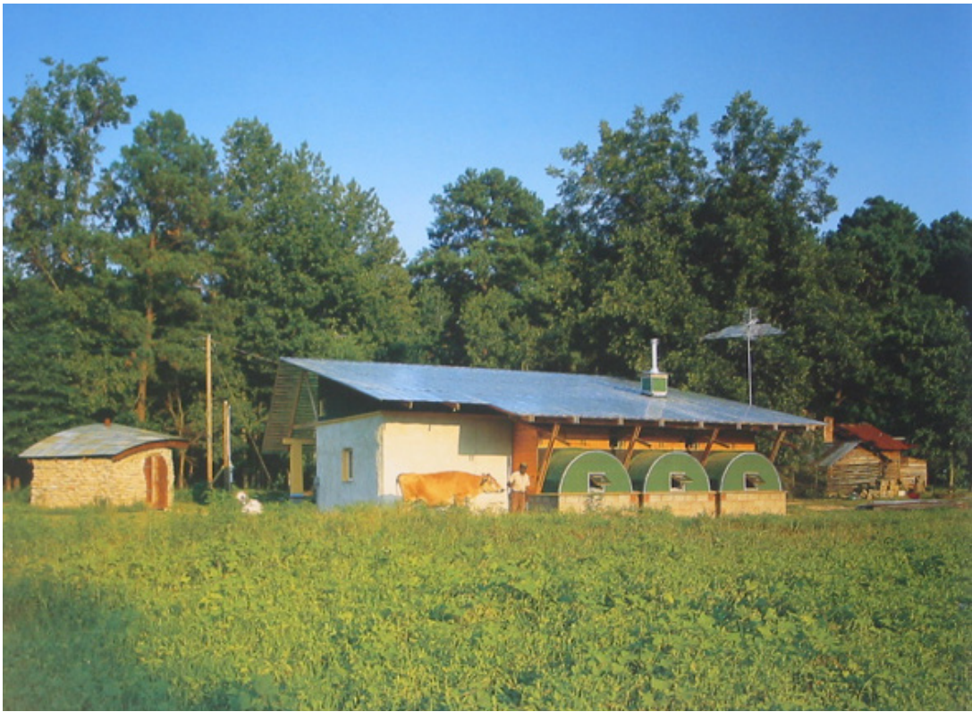
Fig.178 - Vista da fachada traseira da Bryant House.
