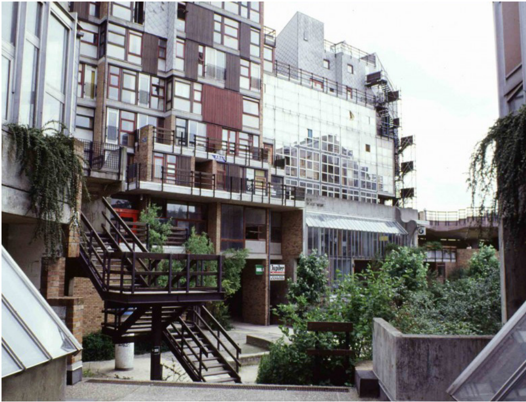
Fig.67 - Fachada interior oeste, evidenciando a morfologia plural da residência La Mémé adquirida em consulta com os estudantes originais. O bloco envidraçado contém alojamentos individuais enquanto que o precede acomoda alojamentos colectivos.
