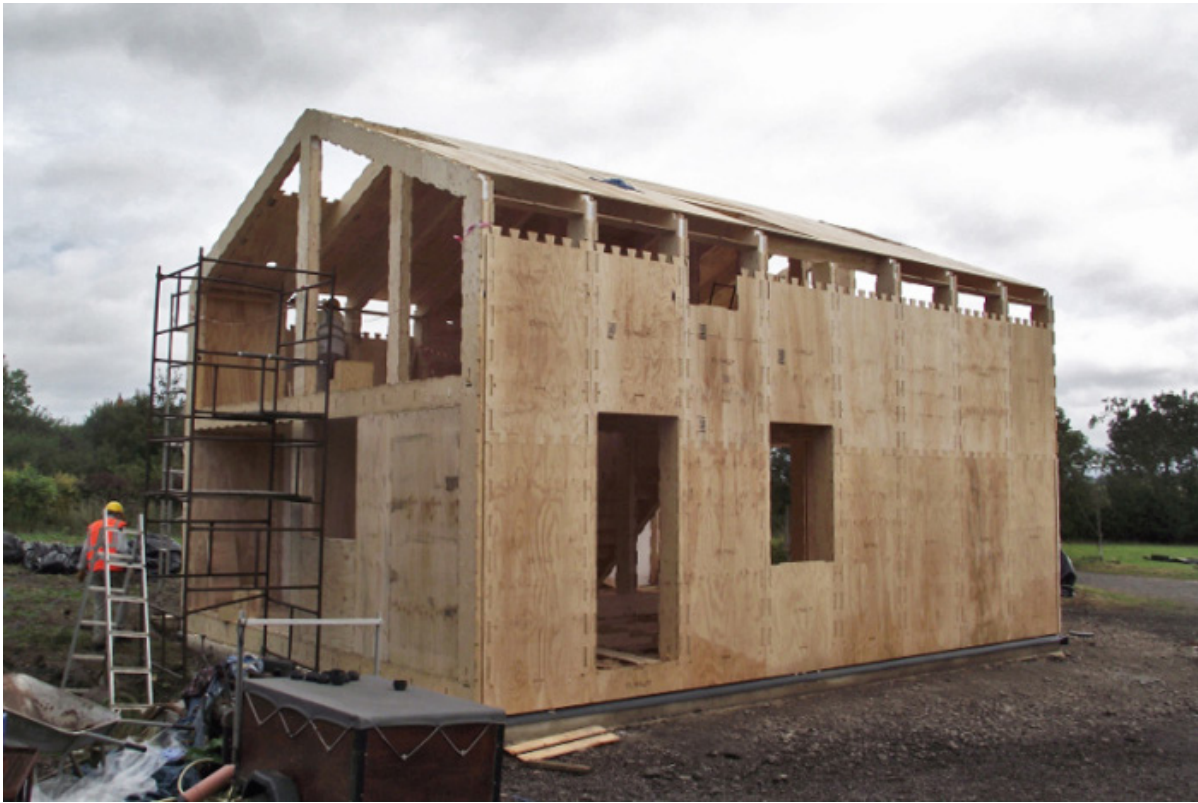
Fig.80 - Estrutura completa e fase terminal da colocação de painéis de paredes e cobertura. Primeiro painel de impermeabilização é colocado na cobertura.z
