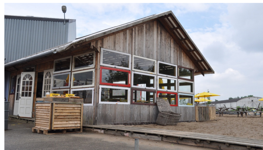
Fig.147 - Bar da Belcrum Beach, também este construído por voluntários da comunidade do STEK. Salienta-se o facto de tanto as portas como os caixilhos das janelas terem sido reaproveitados das demolições no Dr. Struycken District.
