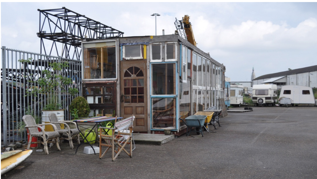
Fig.153 - Arrumos para o material agrícola construído mais uma vez com o recurso a caixilhos e portas das demolições em Dr. Struycken District. Ao fundo um pequeno parque de caravanas.
