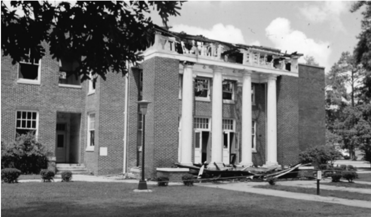
Fig.164 - Edifício da Pembroke State University antes da intervenção.
