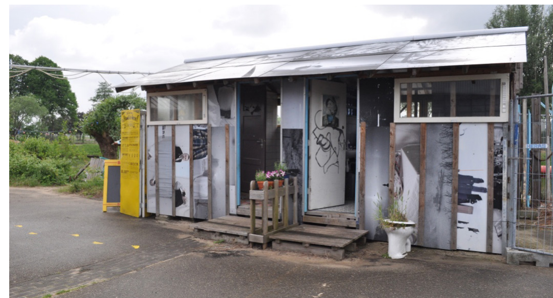
Fig.145 - Instalações sanitárias auto-construídas pela comunidade do STEK.
