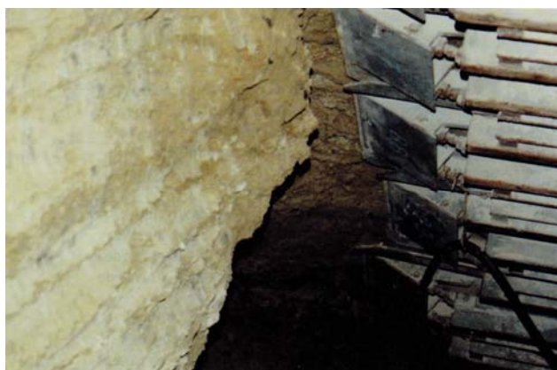
Figura 3.13 Extremidades dianteiras das lanças, vistas pelo interior (Brazão Farinha, 1997).
