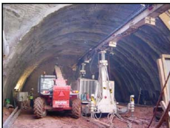
Figura 5.30 Posto de tracção (escavação). Melâneo et al. , 2004a
