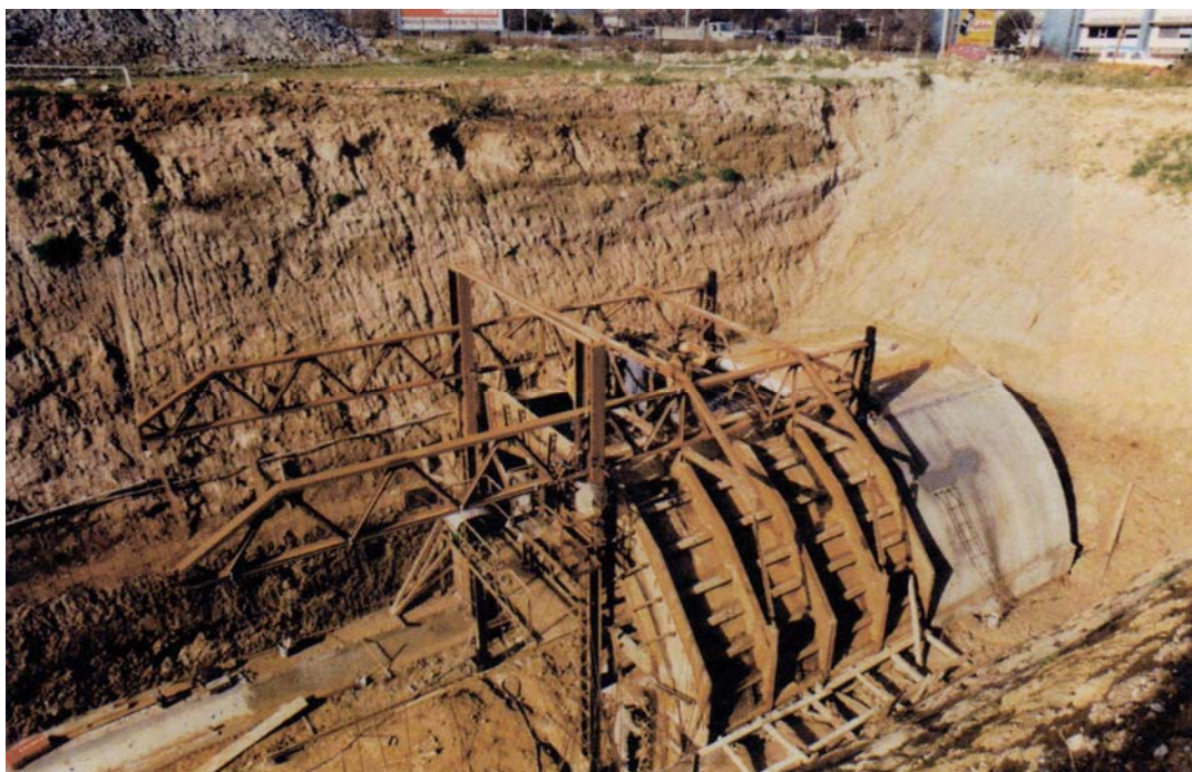
Figura 3.3 Escavação a céu aberto e moldagem da estrutura da galeria entre as estações Cidade Universitária e Campo Grande (Brazão Farinha, 1997).
