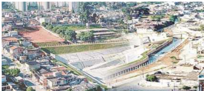
Figura 39. Reservatório de retenção em São Paulo – Pirajuçara, Vol. 120.000m 3 (PGESP, 2005).
