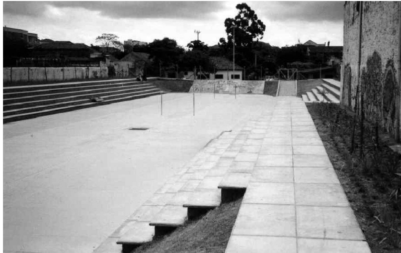
Figura 36. Reservatório de amortecimento em Santo André
