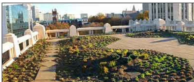
Figura 26. Telhado verde - Zona central da cidade de Atlanta, EUA (EPA, 2005).
