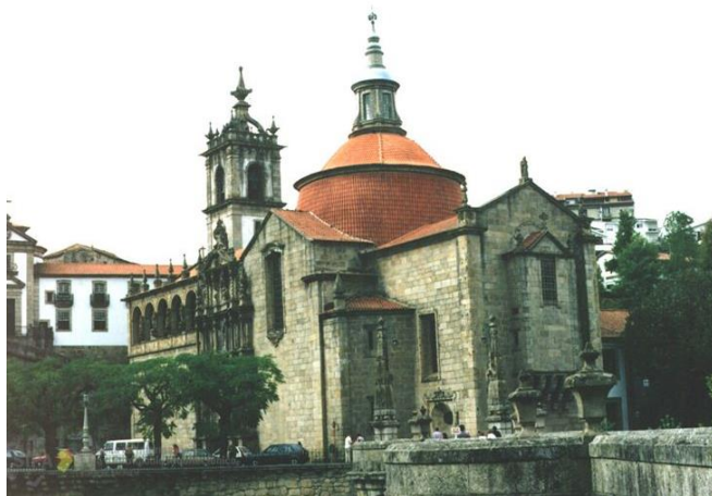
Fig. 5.1 – Igreja de São Gonçalo
