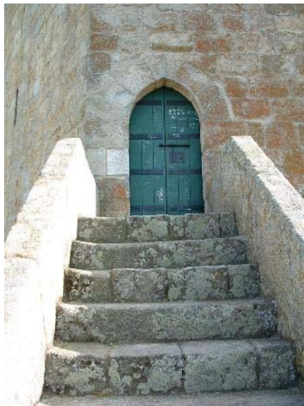
Figura 4.2 – Acesso ao interior da torre
