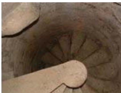
Figura 4.3 – Escada interior em espiral
