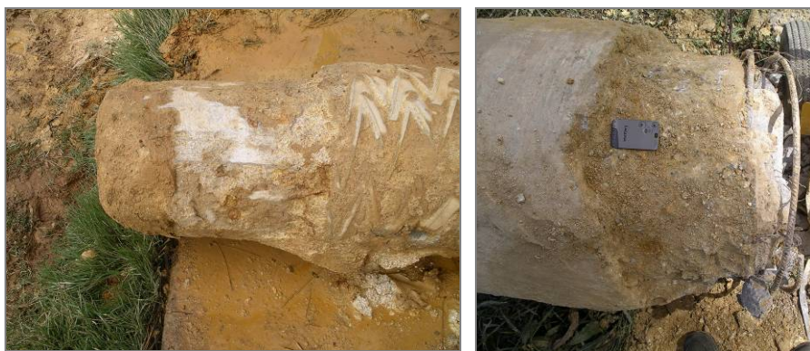
Figura 3.51 - Pormenor da ponta da estaca moldada.
