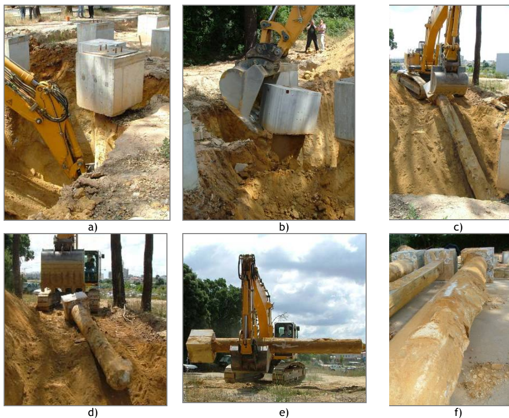
Figura 3.49 - Faseamento da extracção das estacas de 6m: a) início da escavação; b) c) d) retirada da estaca do terreno; e) transporte da estaca para depósito; f) vista geral da estaca após retirada.
