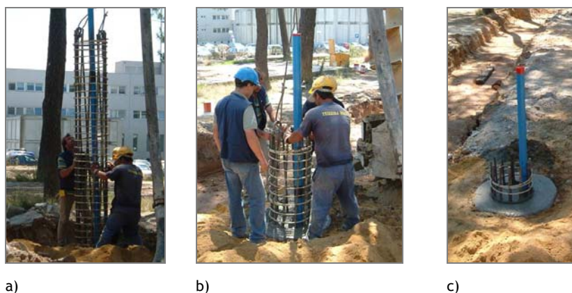
Figura 3.30 - Colocação da armadura.
