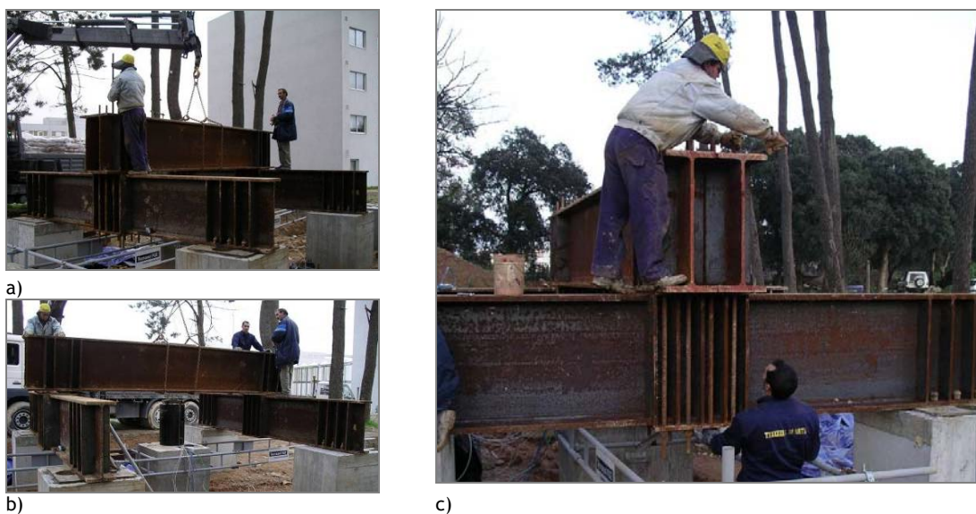
Figura 3.32 - Estrutura de reacção: a) b) colocação da viga central; c) ligação entre o perfil central e o perfil lateral.
