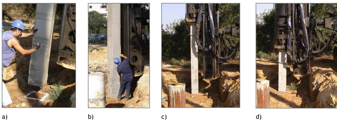
Figura 3.31 - Execução das estacas pré-fabricadas cravadas: a) implantação da estaca; b) verificação da verticalidade da estaca; c) d) cravação da estaca.
