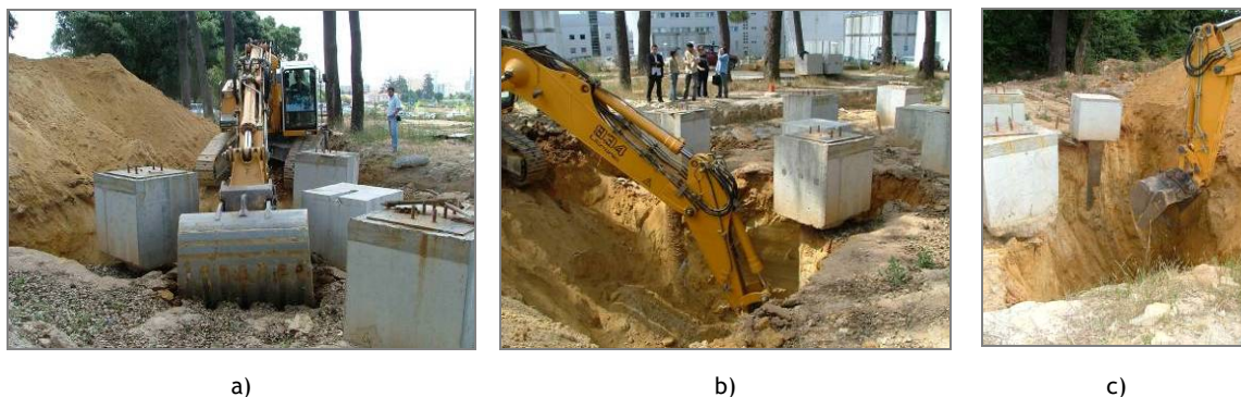
Figura 3.48 - Escavação: a) início do trabalho; b) c) fases da remoção do terreno.
