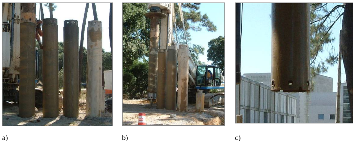
Figura 3.25 - a) b) Tubo moldador metálico; c) Pormenor da base do tubo moldador metálico.
