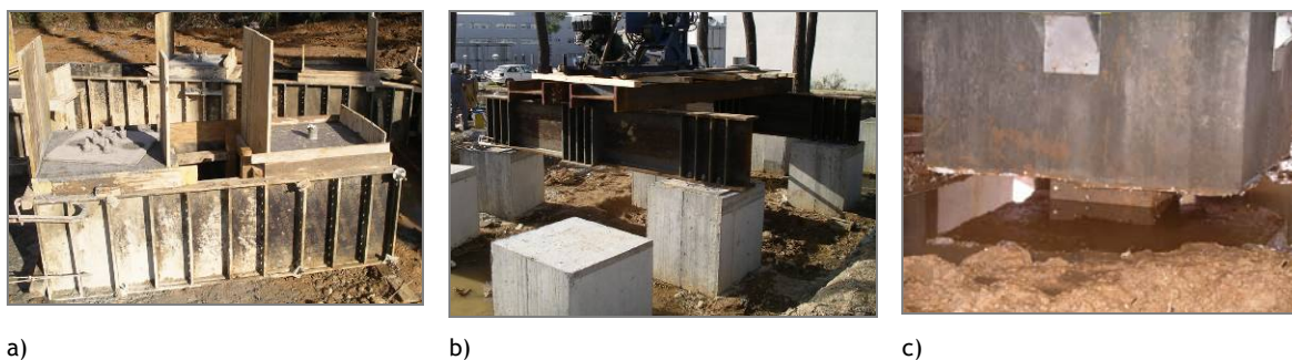
Figura 3.35 - Execução dos maciços de encabeçamentos: a) betonagem; b) apoio entre os perfis metálicos e os maciços de encabeçamentos; c) distância entre o maciço e o solo envolvente.
