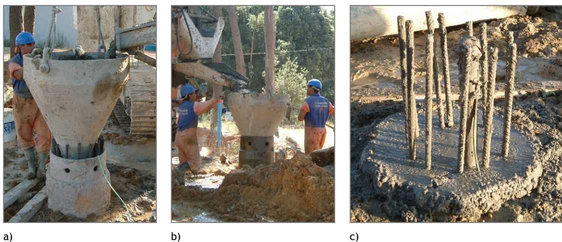
Figura 3.28 - a) b) Betonagem da estaca; c) Betonagem finalizada.
