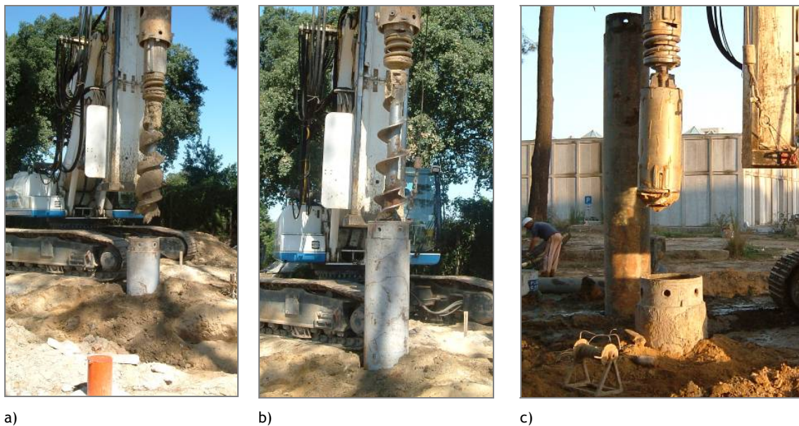
Figura 3.26 - Limpeza do tubo: a) b) Trado; c) Limpadeira.
