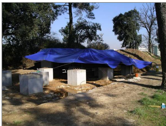
Figura 3.36 - Lona de cobertura da estrutura de reacção.
