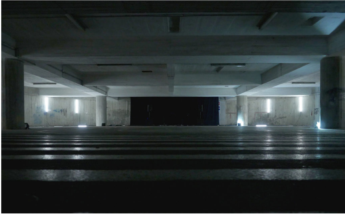
Figura 138: Vista geral da instalação
