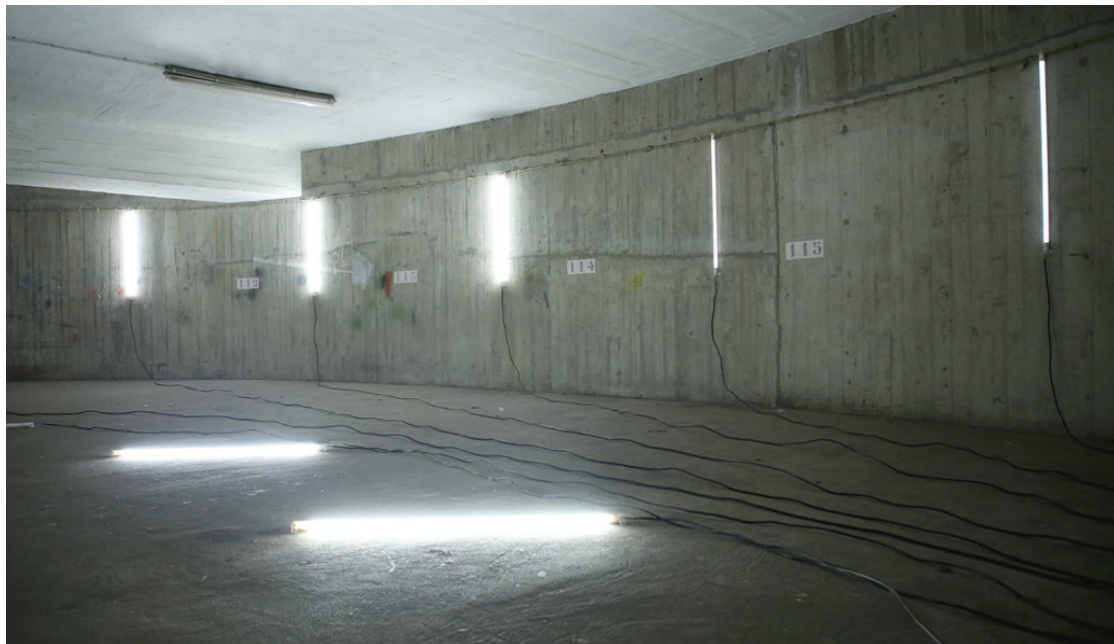
Figura 137: Vista de pormenor da instalação
