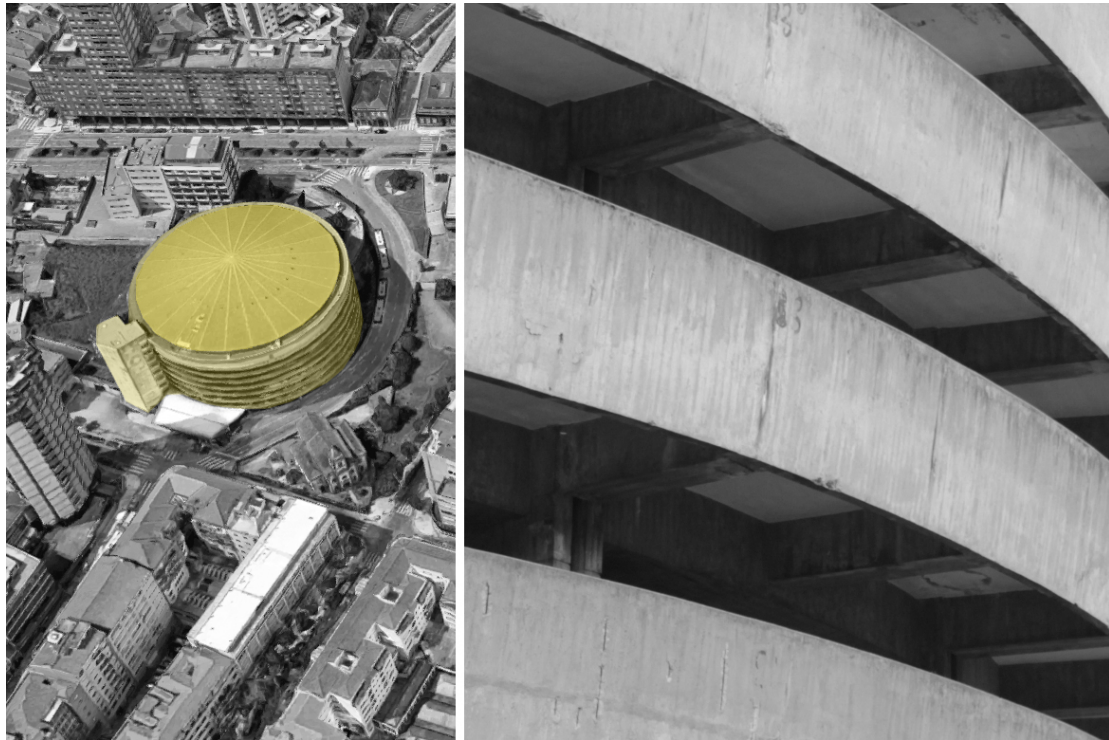
Figura 129: Vista geral e de pormenor do edificio
