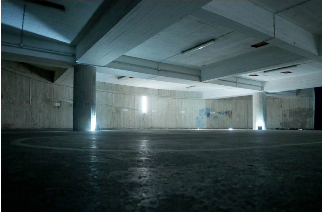
Figura 136: Vista da entrada da instalação
